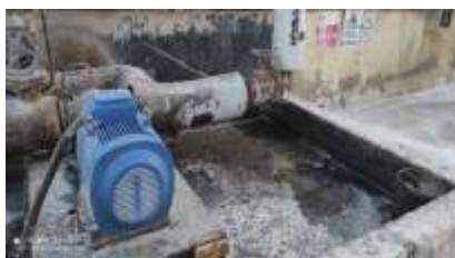
Figura 70 – area carico BTZ; particolare del bacino di contenimento su cui sono installate le pompe di trasferimento
