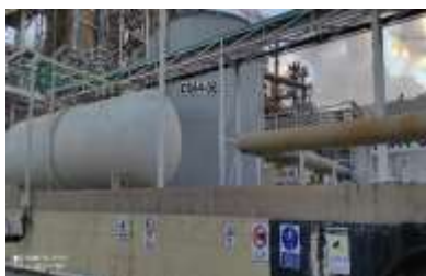
Figura 69 – serbatoio stock olio combustibile BTZ all'interno di apposito bacino di contenimento
