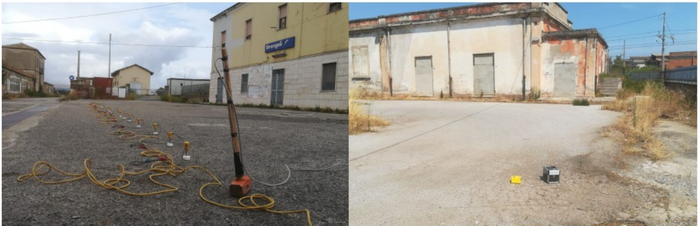
Figura 2-1 - Strumentazione impiegata per l'esecuzione delle prove masw (a sinistra), per le prove hvsr (a destra.)
