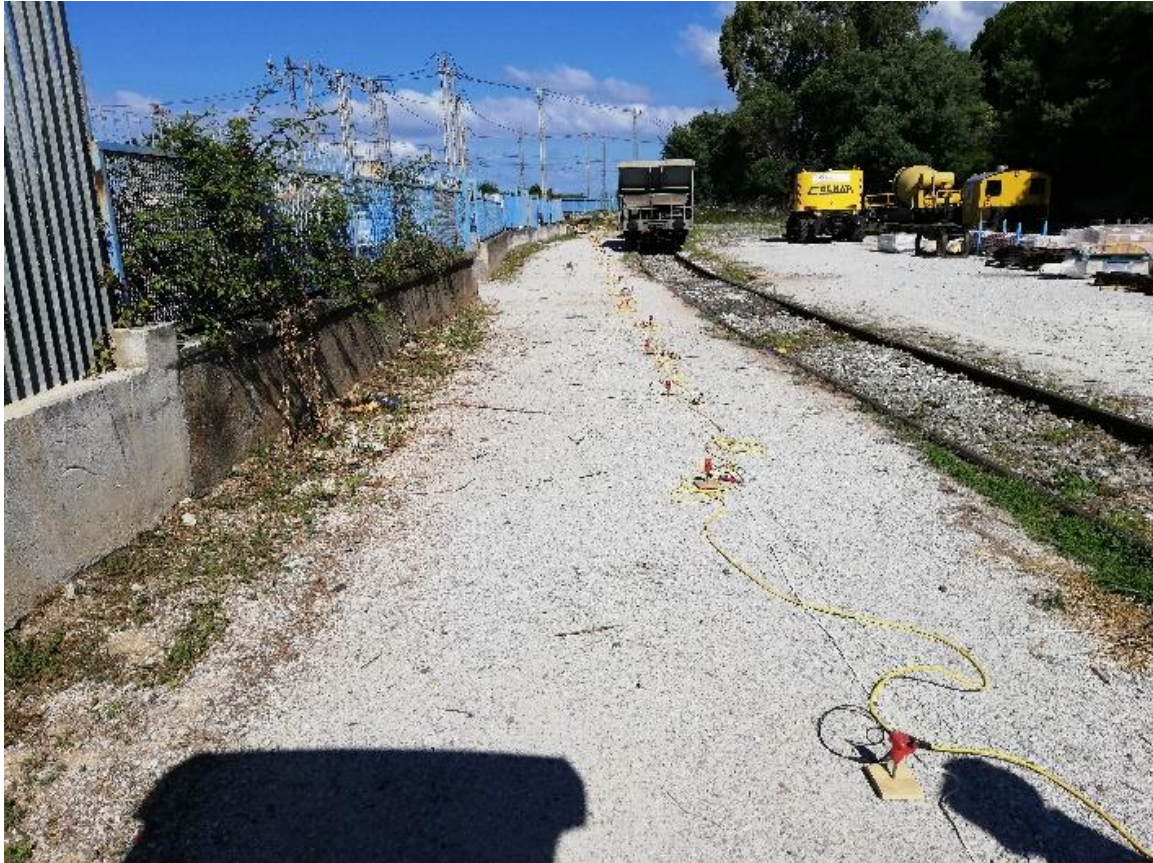
Figura 7 - Esecuzione delle indagini MASW
