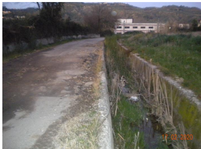
Figura 16 – Tratto di valle del canale PT10
