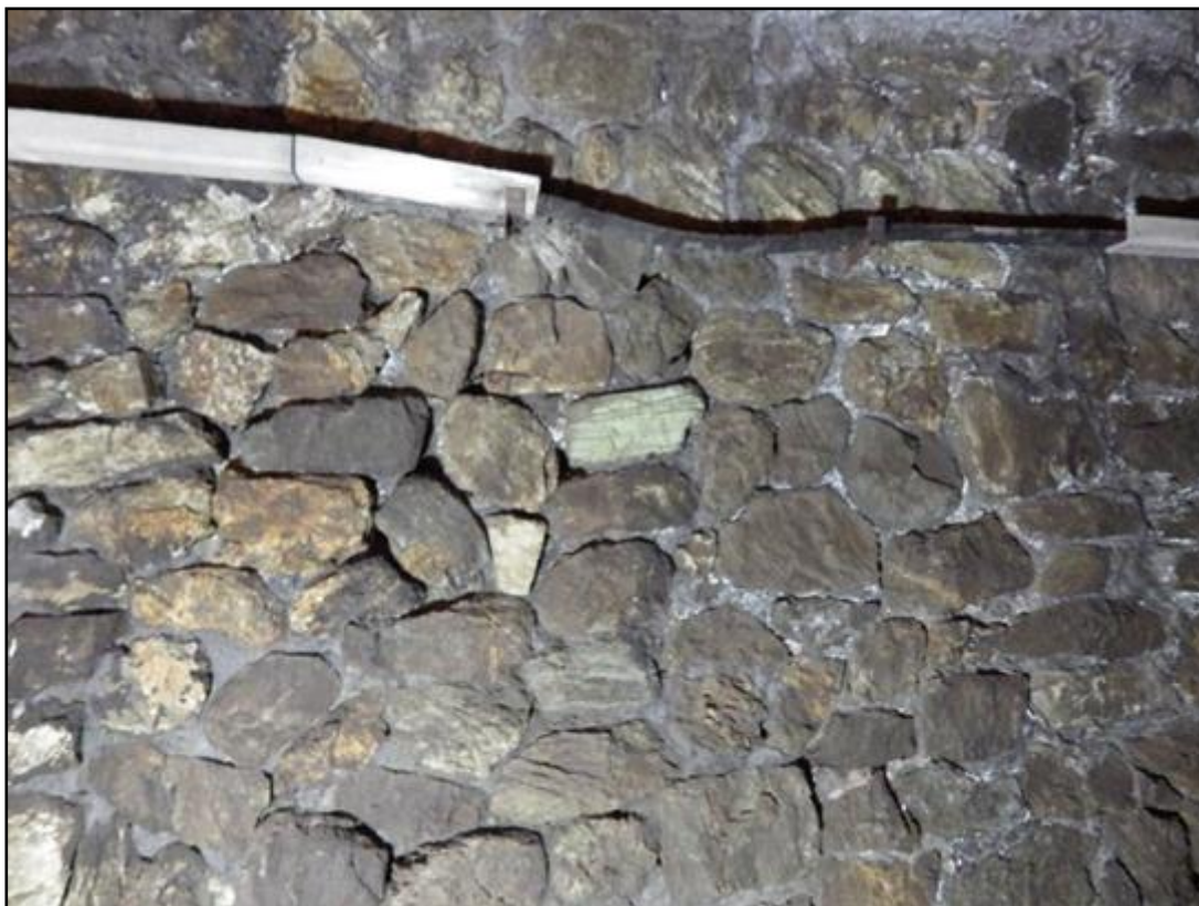
Figura 3.2 – Galleria Cordolo, particolare del rivestimento in blocchi lapidei al piedritto progr. 13+534.
