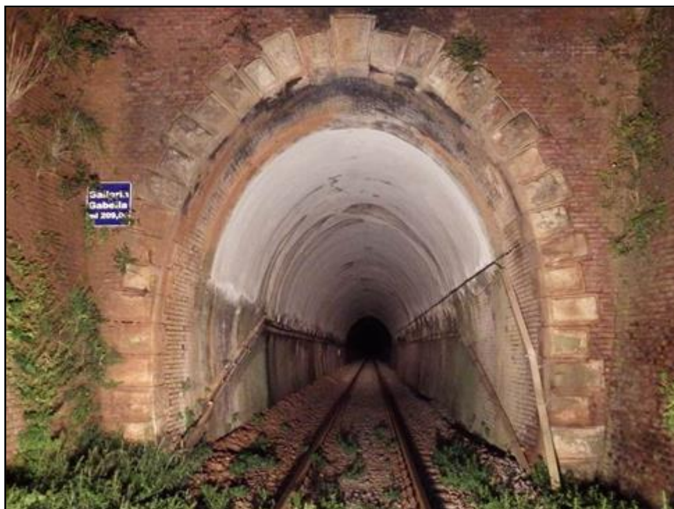
Figura 3.1 – Galleria Gabella, imbocco lato Lamezia Terme, progr. 12+952.
