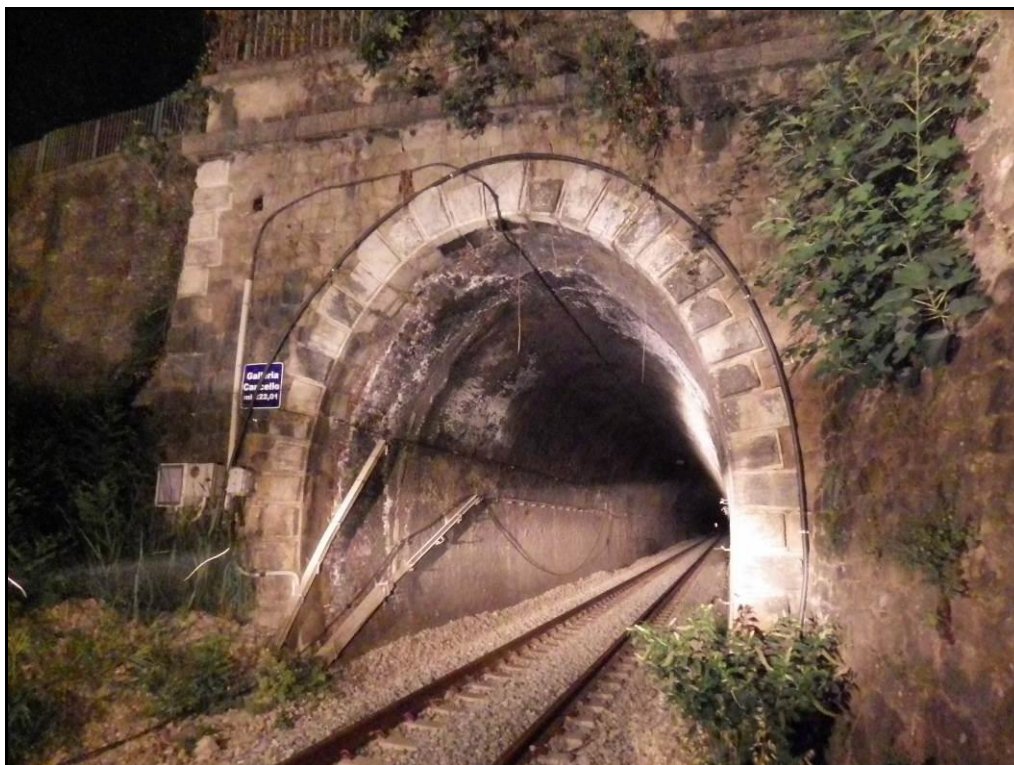
Figura 3.8 - Galleria Cannello, imbocco lato Catanzaro, progressiva 20+488.
