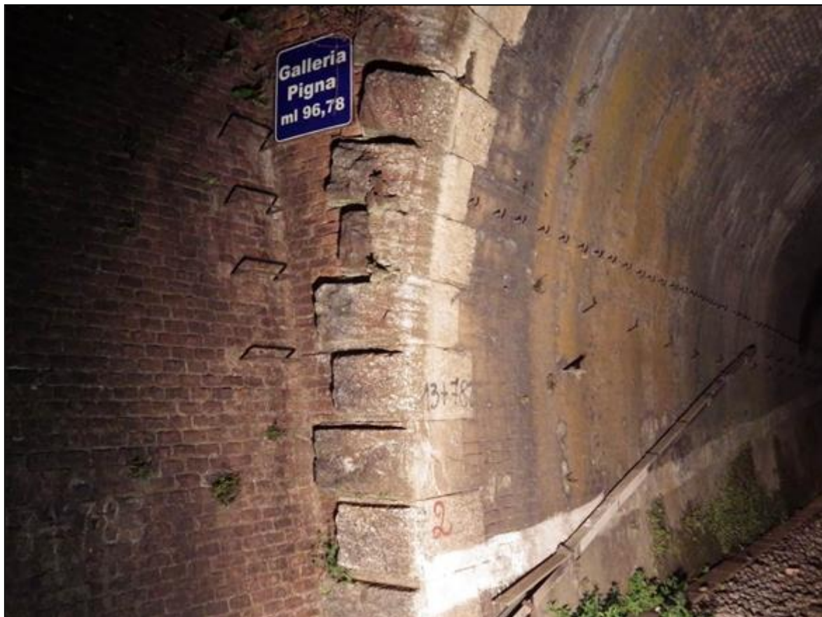
Figura 3.3 – Galleria Pigna, particolare del piedritto all'imbocco lato Lamezia progr. 13+784.
