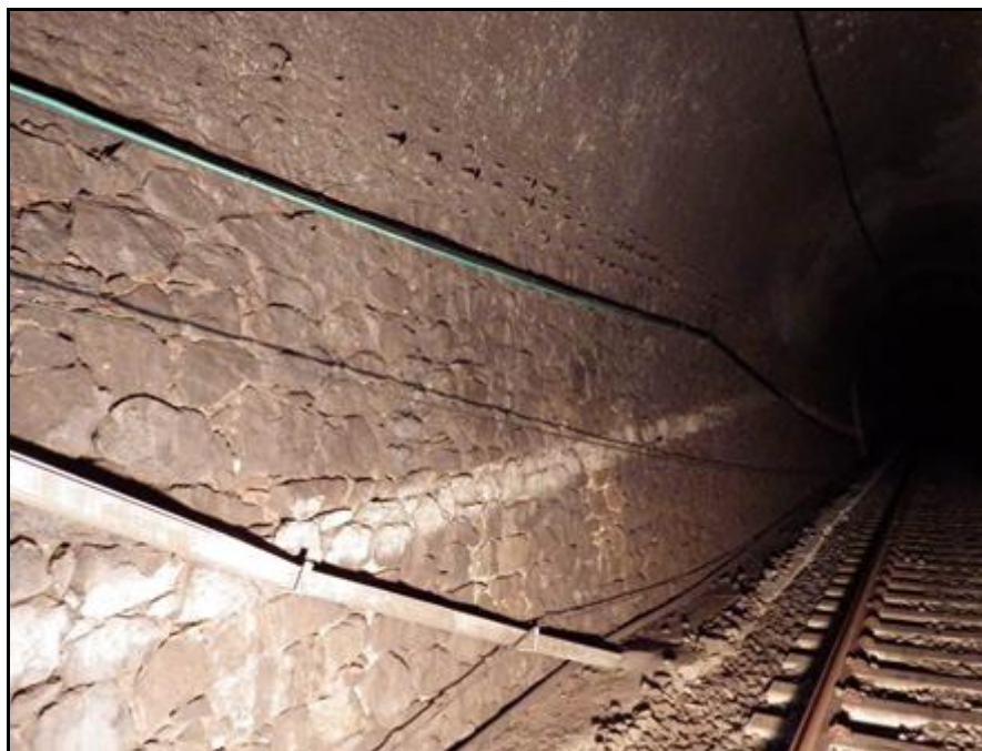
Figura 3.6 - Galleria Pianopoli, rivestimento in pietrame lapideo ai piedritti e mattoni in calotta alla progressiva 17+582.
