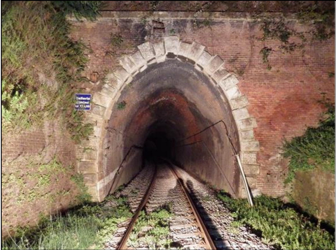
Figura 3.4 – Galleria Cimmino, imbocco lato Lamezia progr. 14+453.
