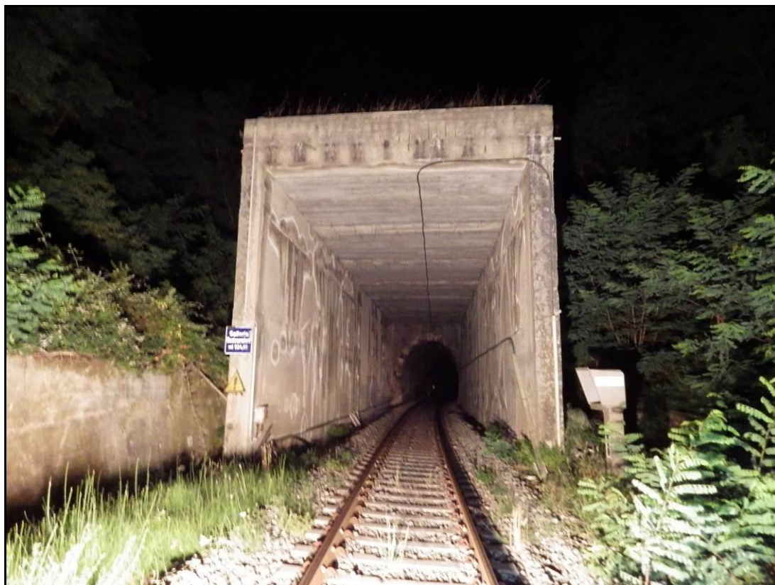
Figura 3.7 - Galleria Montecavaliere, tratta in artificiale all'imbocco lato Lamezia, progressiva 18+958.
