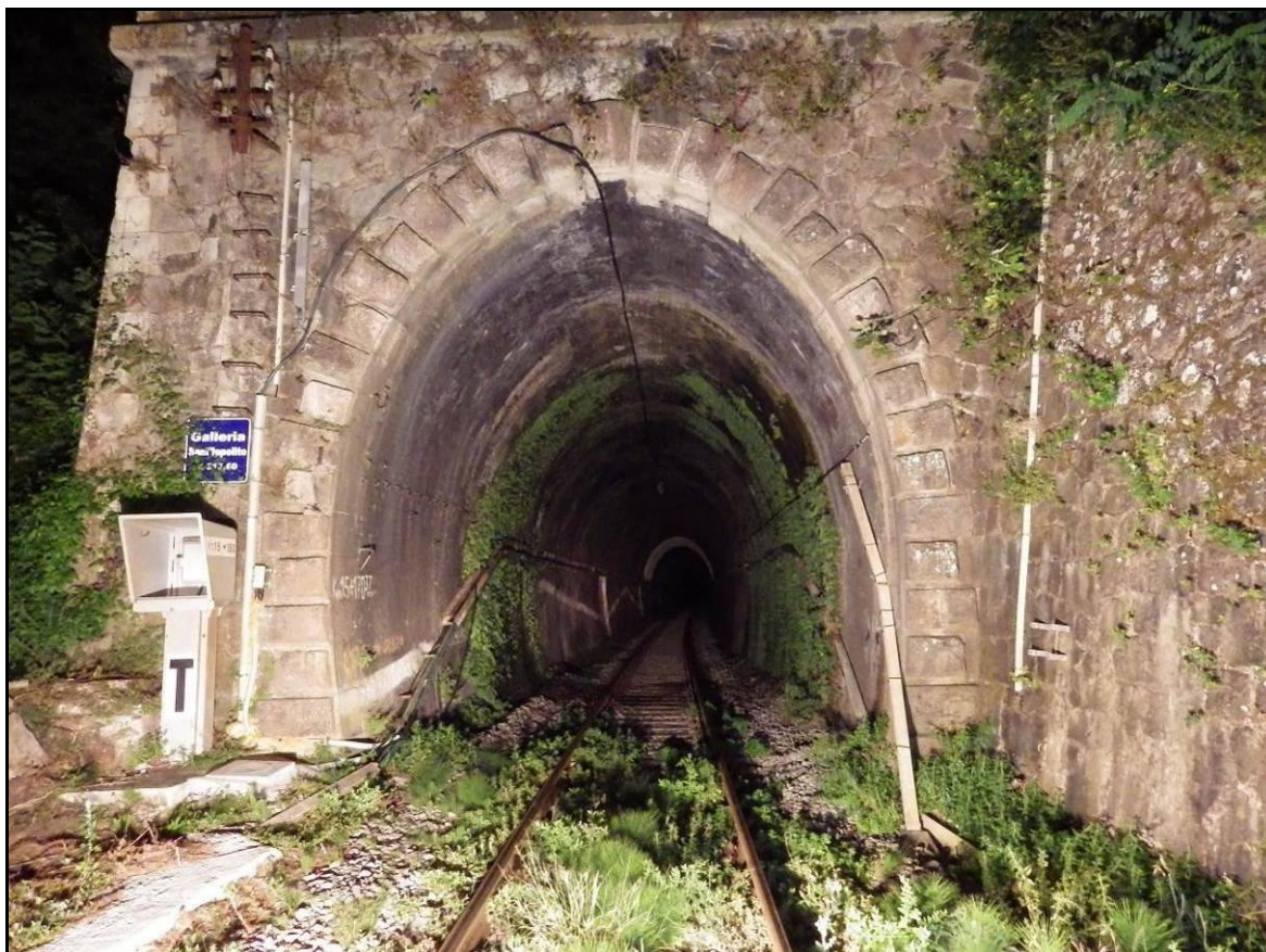
Figura 3.5 – Galleria San Ippolito, imbocco lato Lamezia progr. 15+170.
