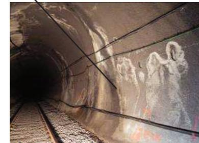
Macchie di umidità sul rivestimento di spritz-beton
