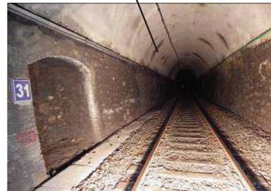
Macchie umide sul rivestimento di spritz-beton
