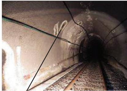
Doppi cambi di sezione con rivestimento ammalorato da umidità
