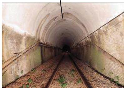
Zone umide sul rivestimento di spritz-beton
