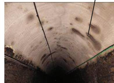
Spritz-beton con presenza di macchie umide e lievemente concrezionate
