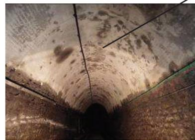
Umidità presente sul rivestimento di spritz-beton
