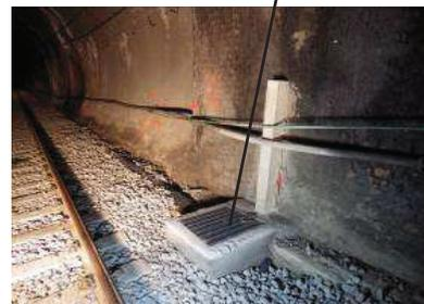
Pozzetto di recente realizzazione collegato ad una tubazione sotterrata
