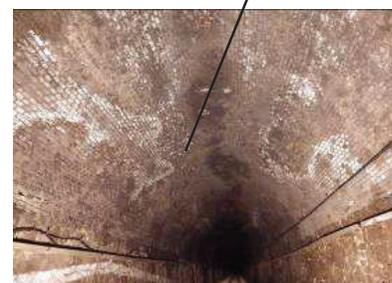
Zone umide in calotta con presenza di muffa
