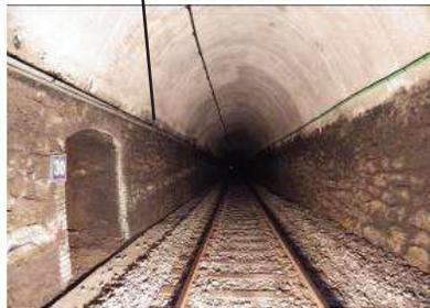
Macchie umide sul rivestimento di spritz-beton
