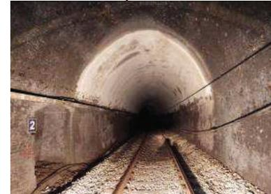
Zone umide in calotta su rivestimento di spritz-beton
