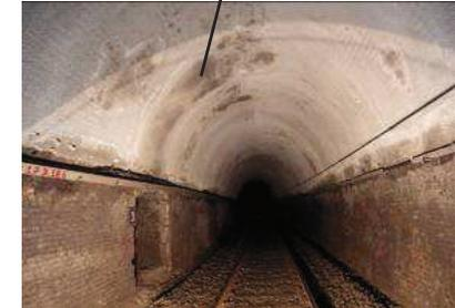
Zone umide in calotta su rivestimento di spritz-beton
