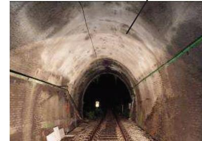
Macchie umide sul rivestimento di spritz-beton
