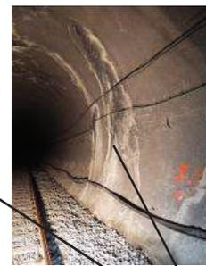
Macchie di umidità sul rivestimento di spritz-beton
