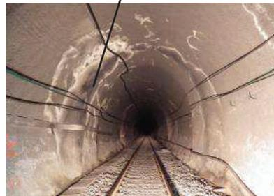
Macchie di umidità e muffa sul rivestimento di spritz-beton
