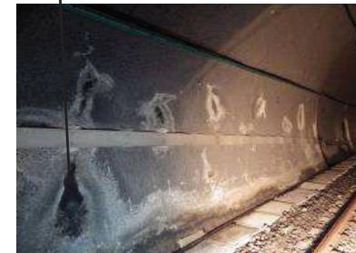
Presenza di piccole macchie di umidità con concrezioni
