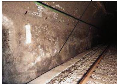
Rivestimento in mattoni ammalorato per la presenza di umidità e concrezioni
