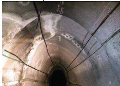
Doppio cambio di sezione con rivestimento ammalorato da umidità
