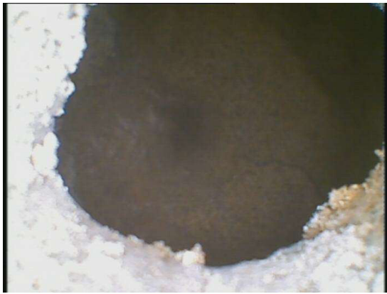
0,50 m: limite rivestimento
