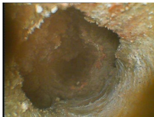
0,50 m: limite malta di rivestimento
