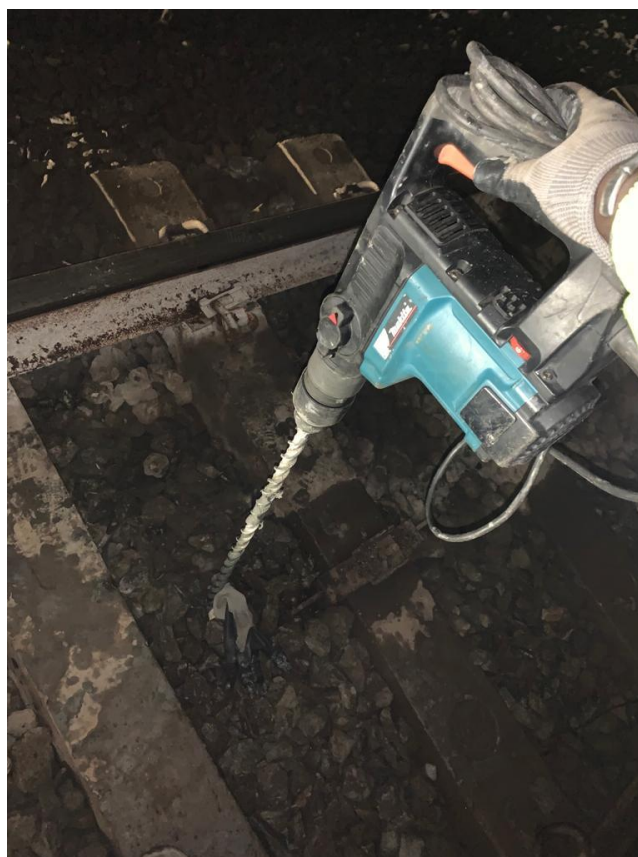
Figura 3: Esecuzione perforazione a distruzione di nucleo nel ballast
