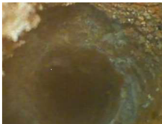
0,30 m: limite rivestimento in mattoncini rossi / malta
