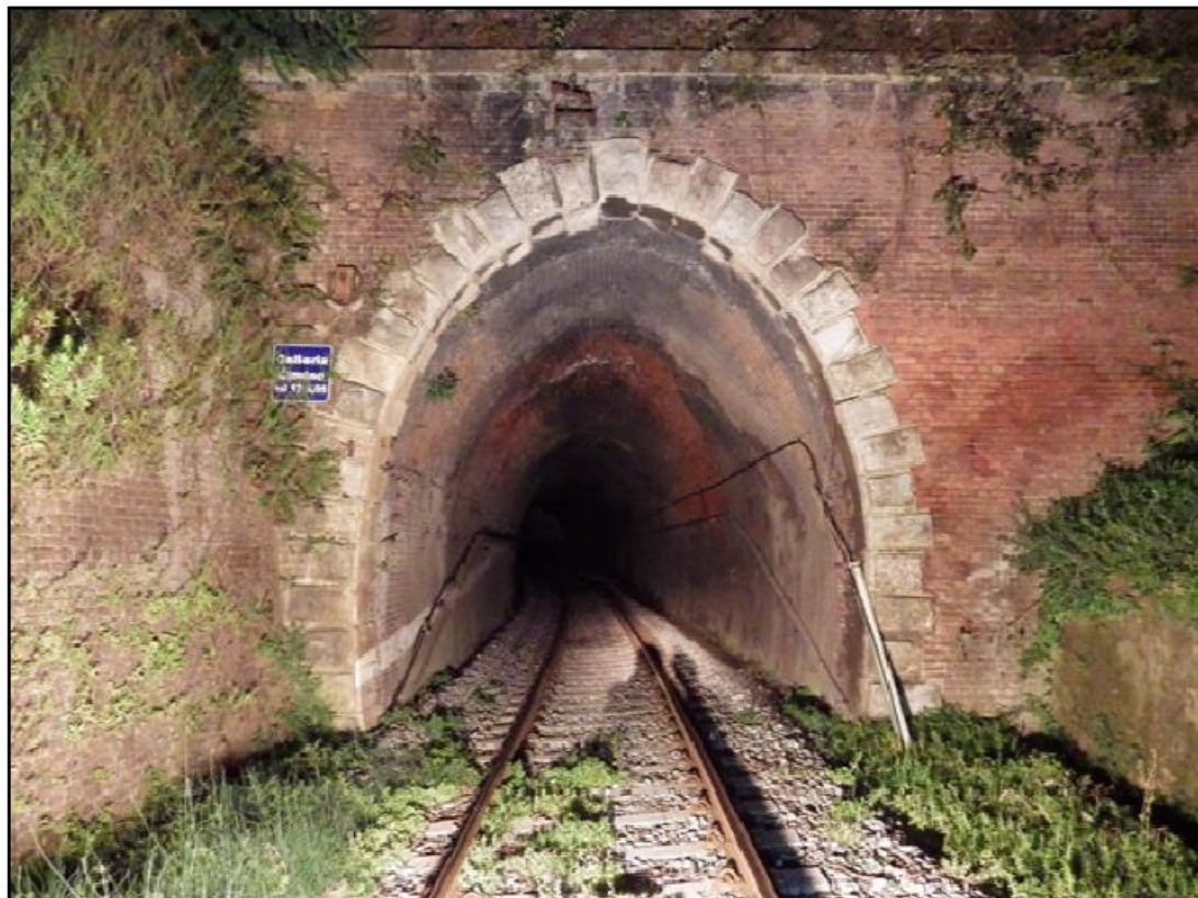
Figura 2 Galleria Cimmino imbocco lato Lamezia T.
