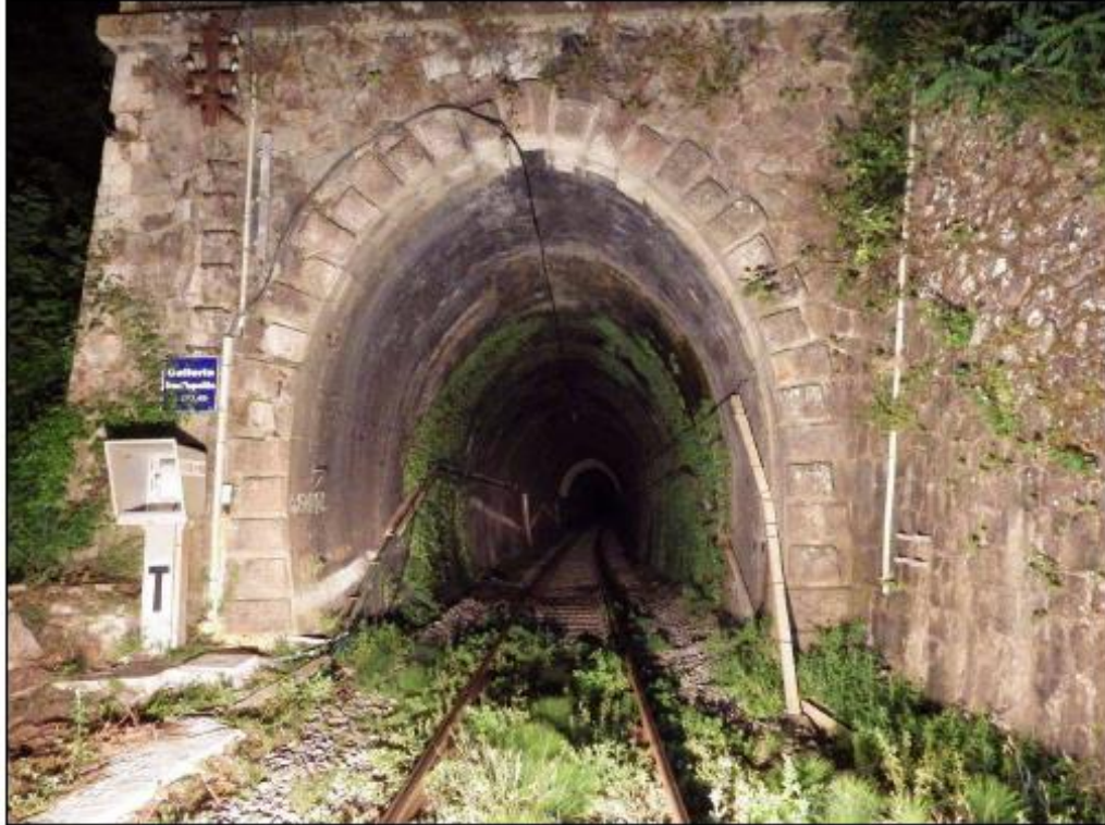
Figura 3 Galleria San Ippolito imbocco lato Lamezia T.
