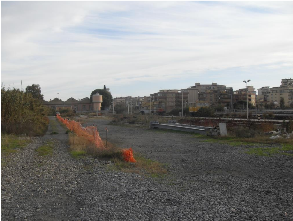
Foto 1 - Vista dell'area di Cantiere CA.04 (fonte sopralluogo)
