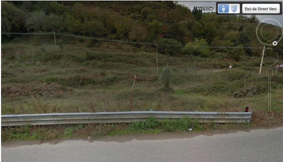
Foto 1 - Vista del cantiere (fonte Google Street view)
