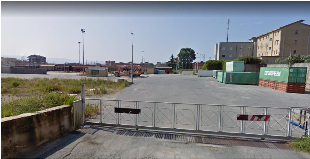
Vista dell'accesso al cantiere
