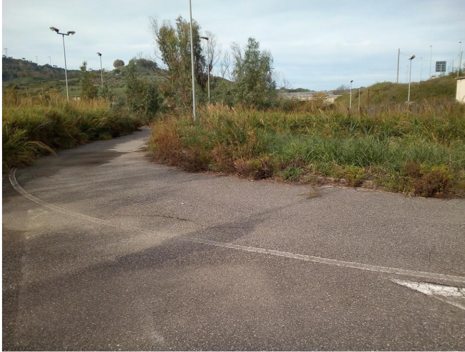
vista della viabilità interna all'area ferroviaria per l'accesso al cantiere (fonte sopralluogo)
