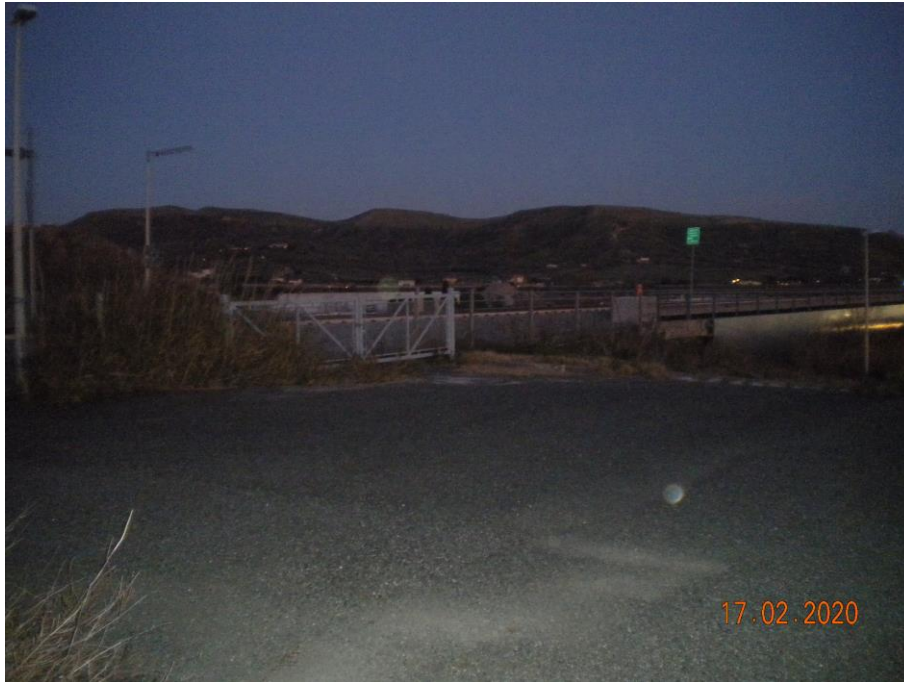
Foto 1 - Vista del cantiere AT.10
