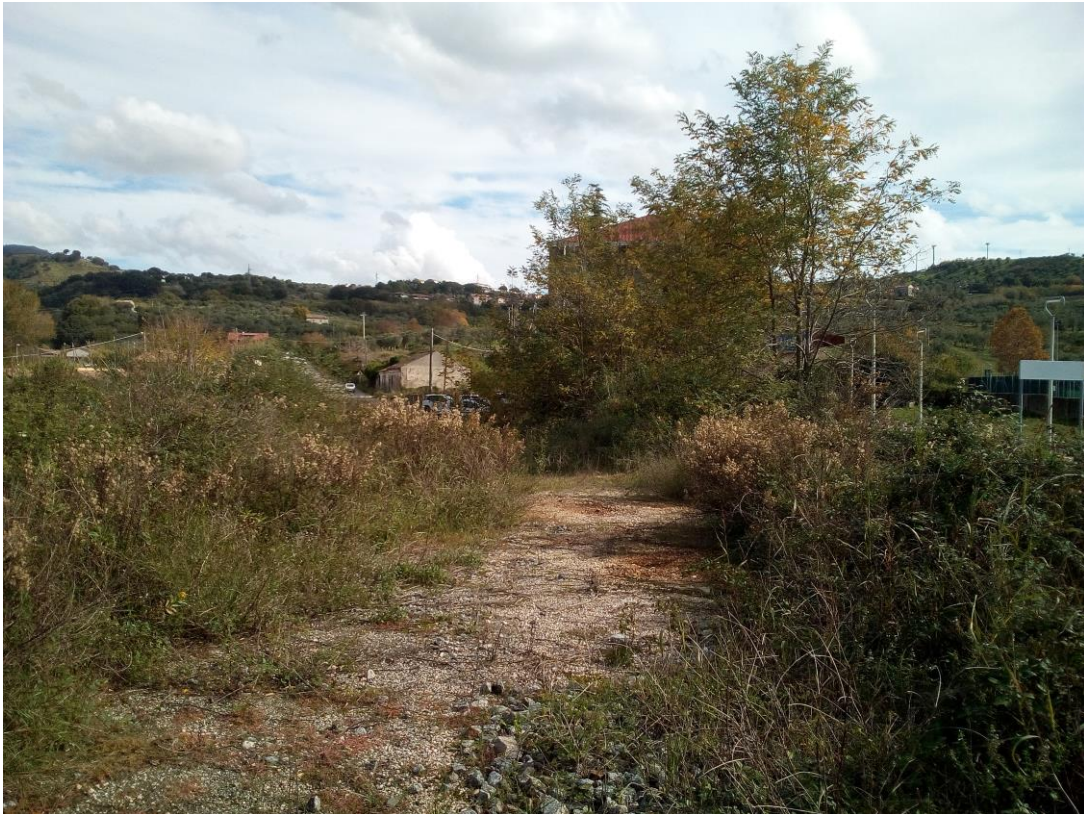
Foto1 – vista dell'area di cantiere CA.03 (fonte sopralluogo)
