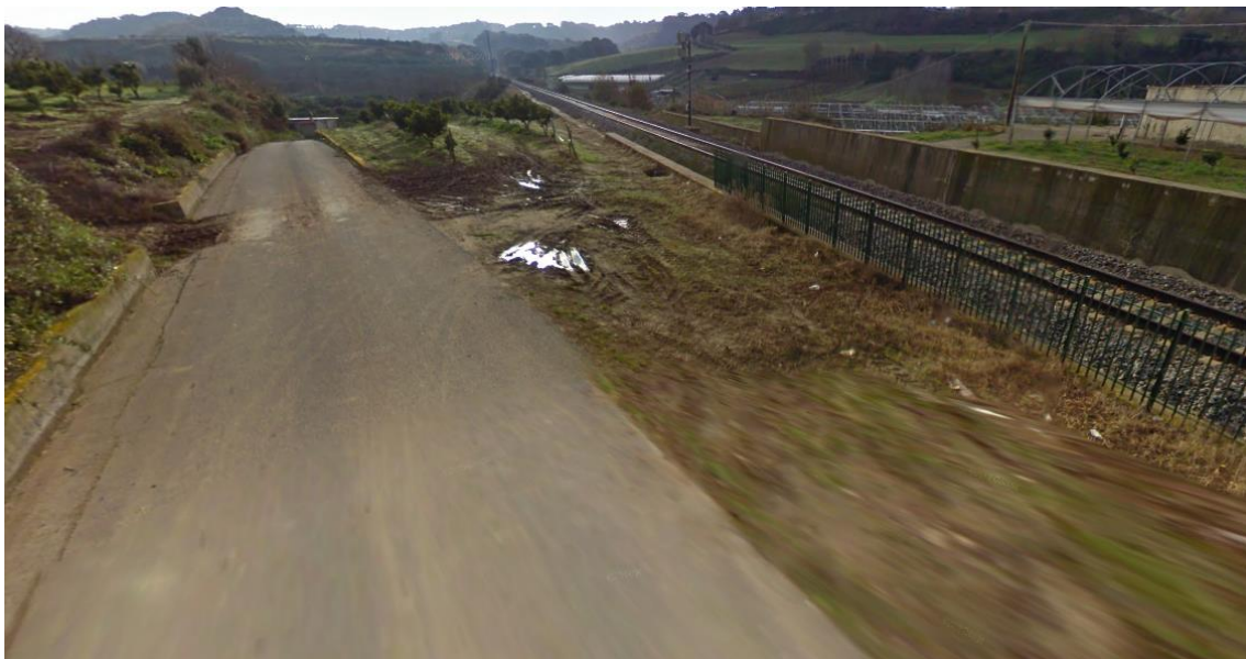
Foto 1 - Vista del cantiere AT.04 e della viabilità di accesso
