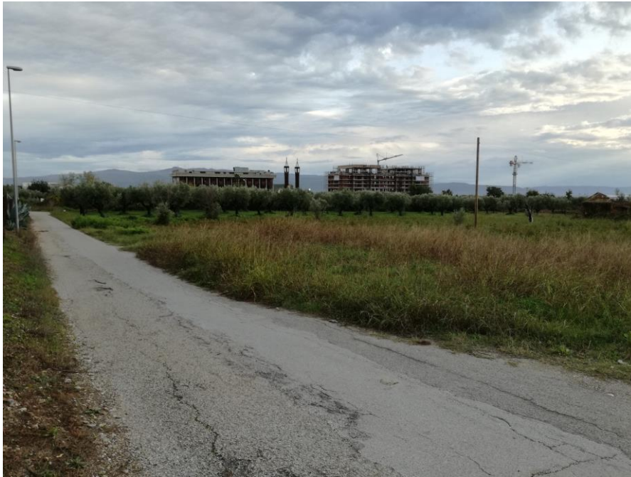
Foto 1 - Vista del cantiere CO.01 (fonte sopralluogo)
