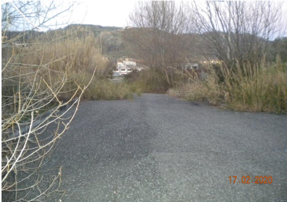
Foto 1 - Vista del cantiere AT.09
