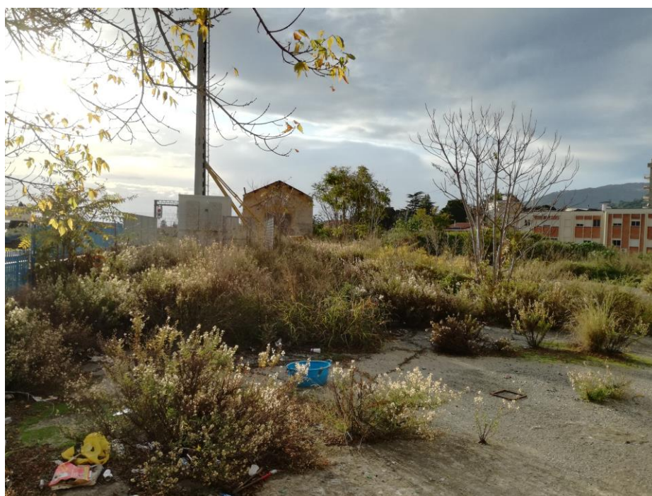
Foto 2 - vista dell'area di cantiere (fonte sopralluogo)
