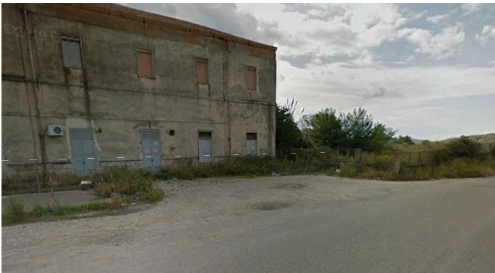
Foto2 – vista dell'accesso all'area di cantiere (fonte Google Earth)
