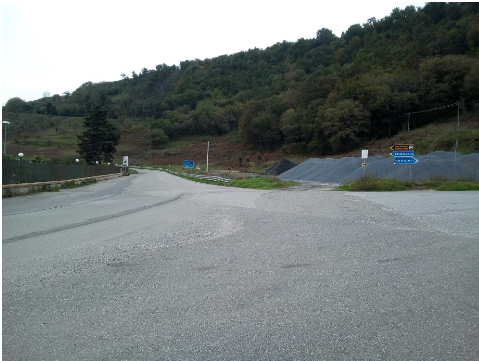
Viabilità di accesso al cantiere
