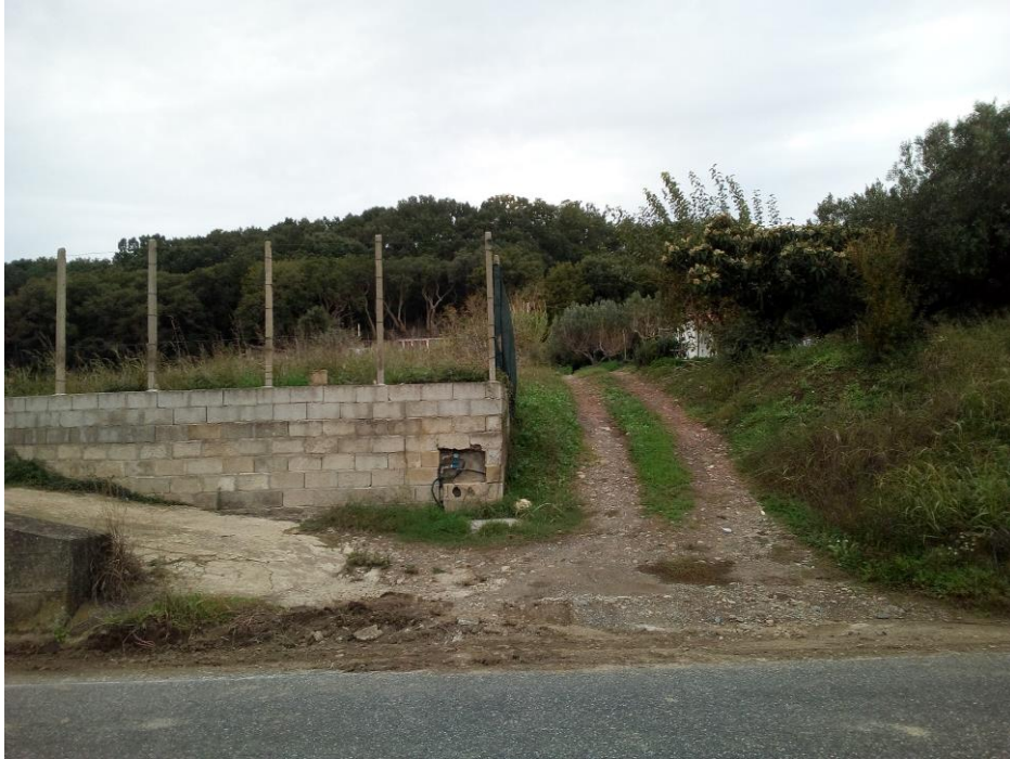
vista dell'accesso all'area di cantiere (fonte sopralluogo)
