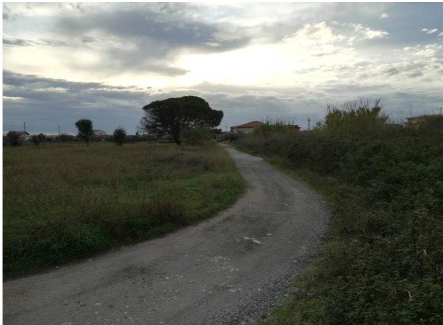
Vista della viabilità di accesso al cantiere (fonte sopralluogo)
