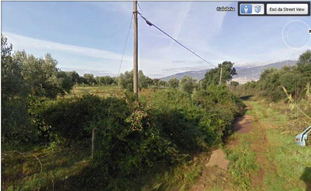
Foto 1 – vista dell'area di cantiere e della poderale d'accesso (fonte Google Street view)
