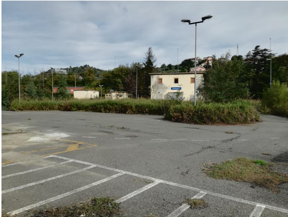
Foto 1 - vista dell'area di cantiere (fonte sopralluogo)
