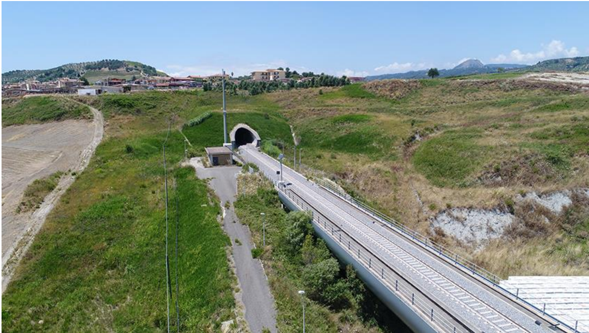
Figura 78 – Panoramica dell’imbocco della galleria Monaci (lato Catanzaro).
