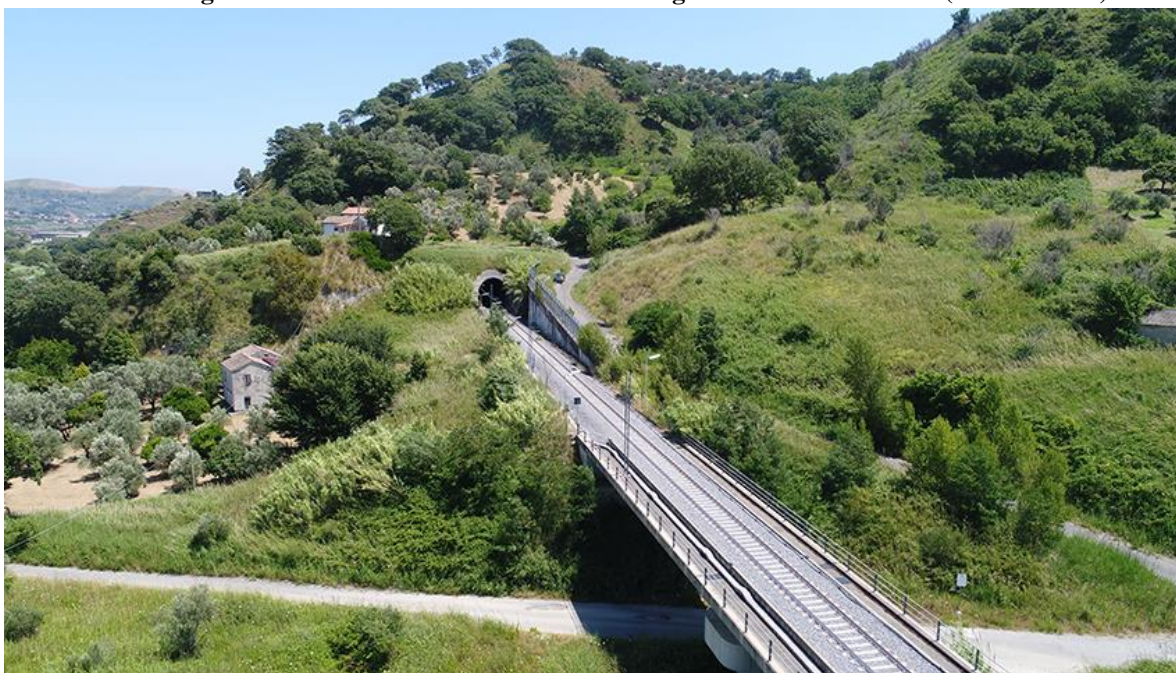
Figura 77 – Panoramica dell’imbocco della galleria Monaci (lato Lamezia).
