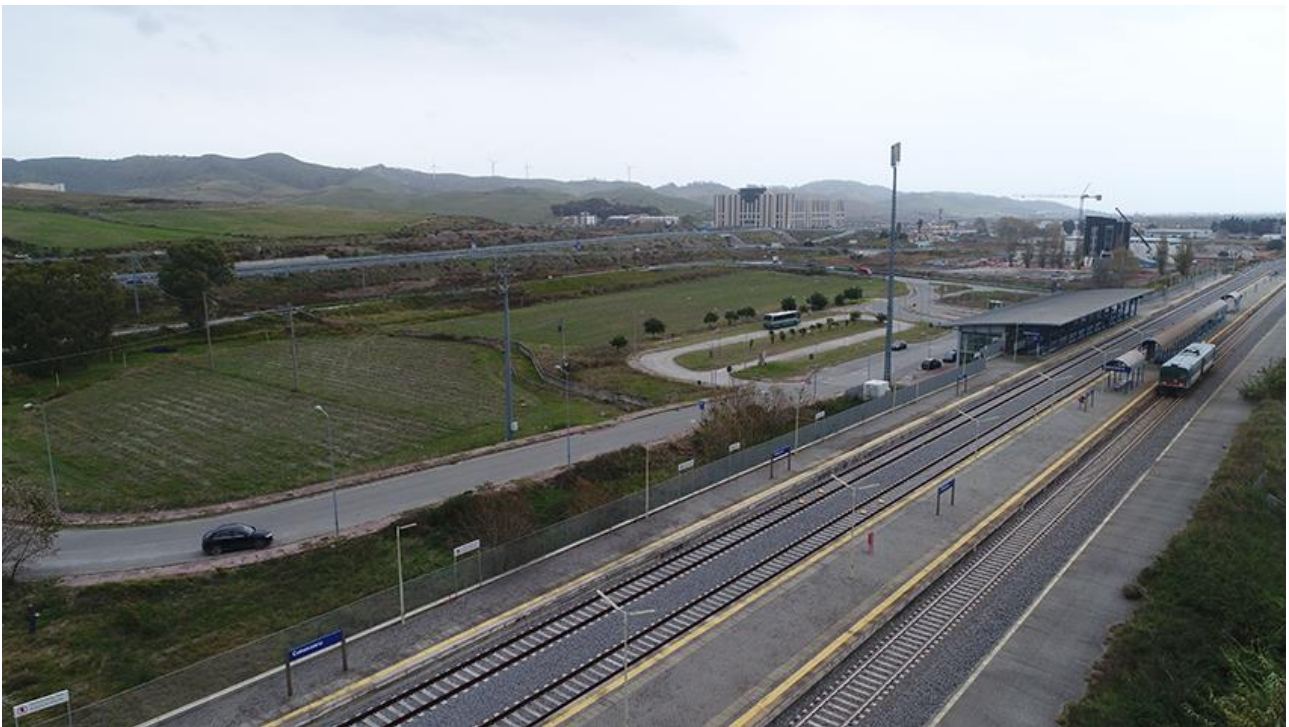
Figura 80 – Panoramica aerea, da Nord-Ovest, dell'area della stazione di Germaneto.
