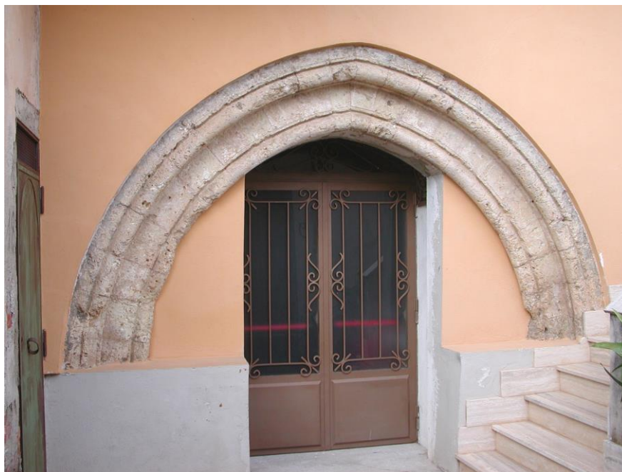
Figura 25 – Resti di un arco a sesto acuto, in calcare modanato, situato nella struttura dell'ex convento degli Agostiniani nel comune di Pianopoli (da DONATO 2004)
