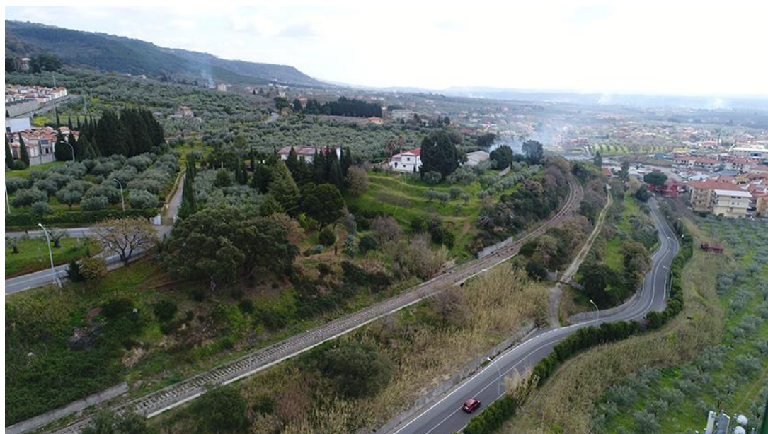
Figura 57 – Panoramica aerea del tratto ferroviario nei pressi del cimitero di Nicastro, vista da ovest.
