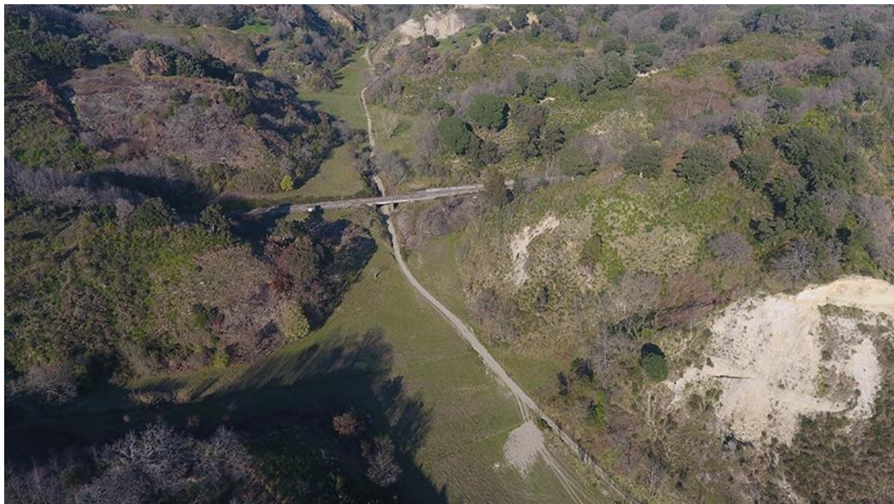
Figura 67 – Il tratto ferroviario in loc. Valle Grotte.
