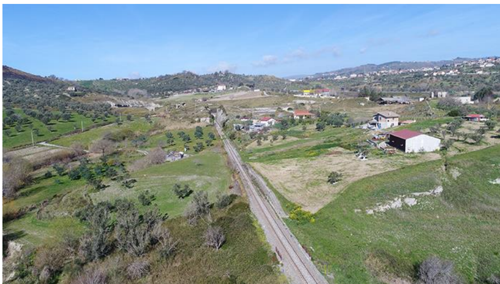
Figura 74 – La tratta ferroviaria dopo la galleria Marcellinara.
