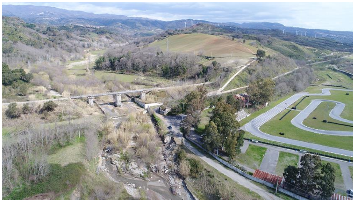
Figura 69 – Il tratto ferroviario sul torrente Cannello.
