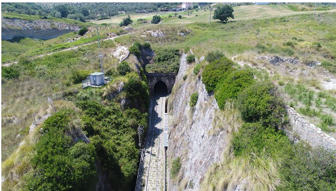
Figura 72 – Imbocco galleria Marcellinara (lato Catanzaro).
