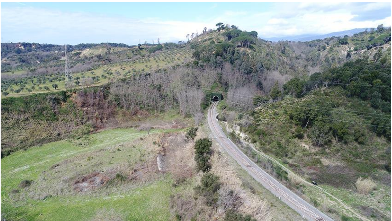
Figura 68 – Galleria Monte Cavaliere, lato Catanzaro.
