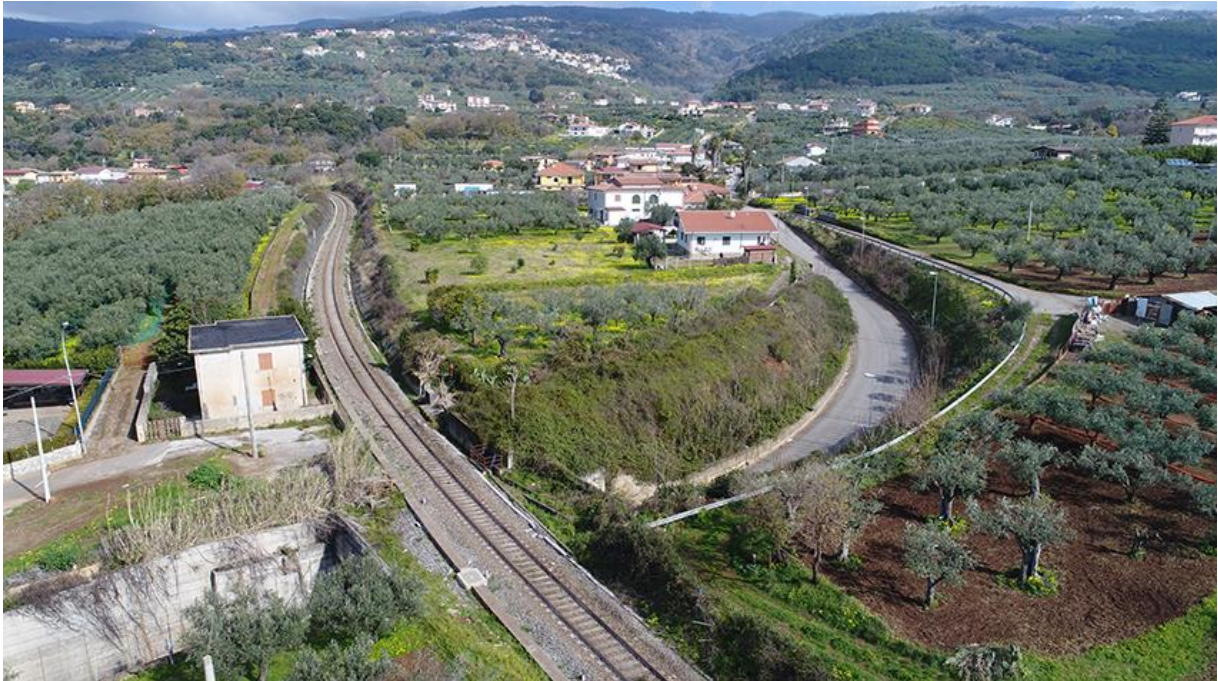
Figura 59 – Panoramica aerea del tratto interessato dalle curve 8 e 9, nella variante 10, vista da sud.
