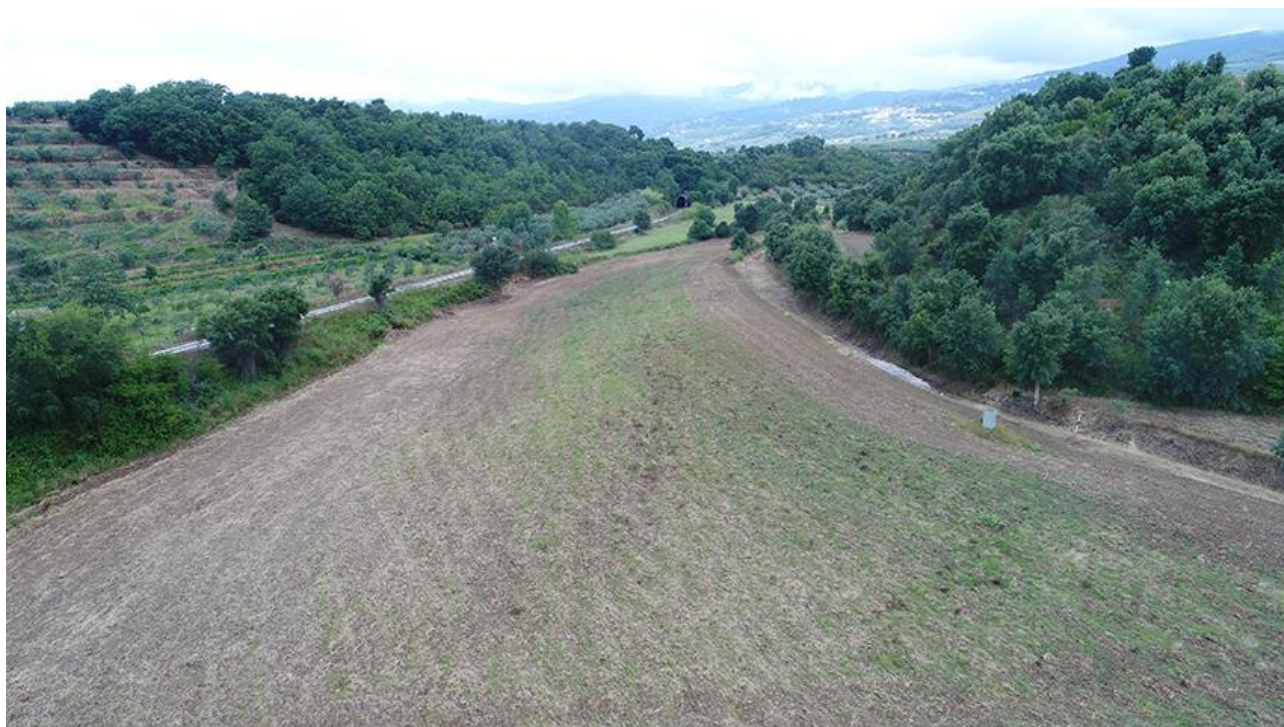
Figura 66 – Imbocco della galleria Pianopoli (lato Lamezia).
