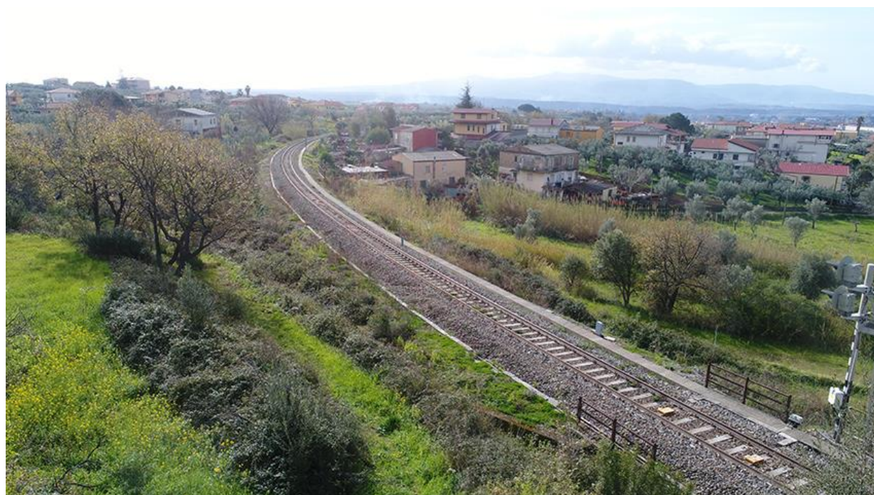
Figura 58 – Panoramica del tratto ferroviario in loc. Gaccia.
