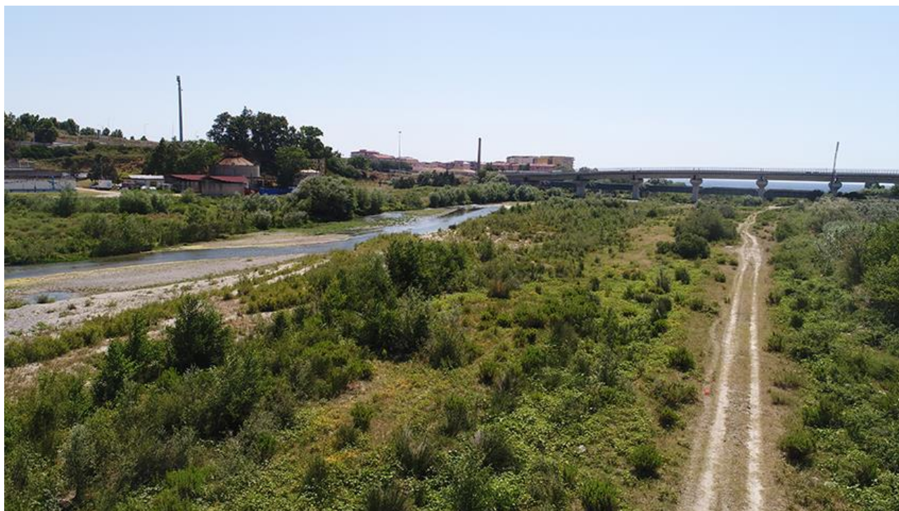
Figura 81 – Panoramica del viadotto sul Corace all’altezza dell’innesto con la linea ionica.
