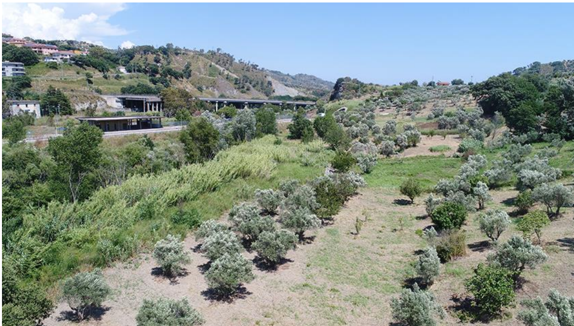
Figura 76 – Panoramica dell’imbocco della galleria Chiana Munda (lato Lamezia).
