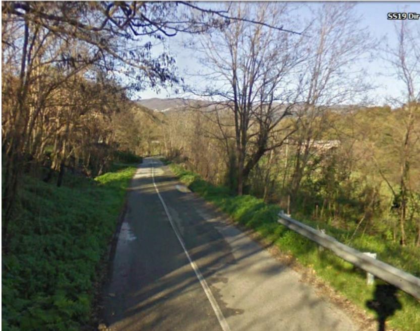
SS19Dir – progressiva iniziale della NV01.
