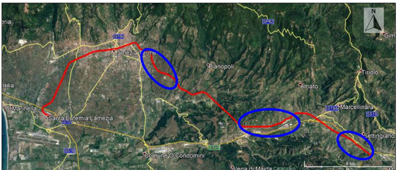
Figura 3-1 – Immagine aerea complessiva tratta ferroviaria Lamezia Terme - Settingiano (in rosso), lungo la quale ricadono le varianti di tracciato in progetto, indicativamente contrassegnate in blu. (Google Earth).
