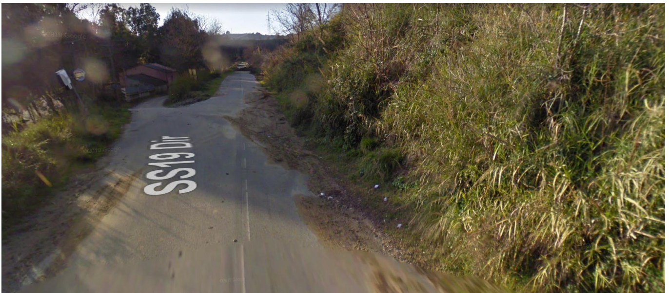
Figura 2 Vista del materiale accumulato sulla sede stradale
