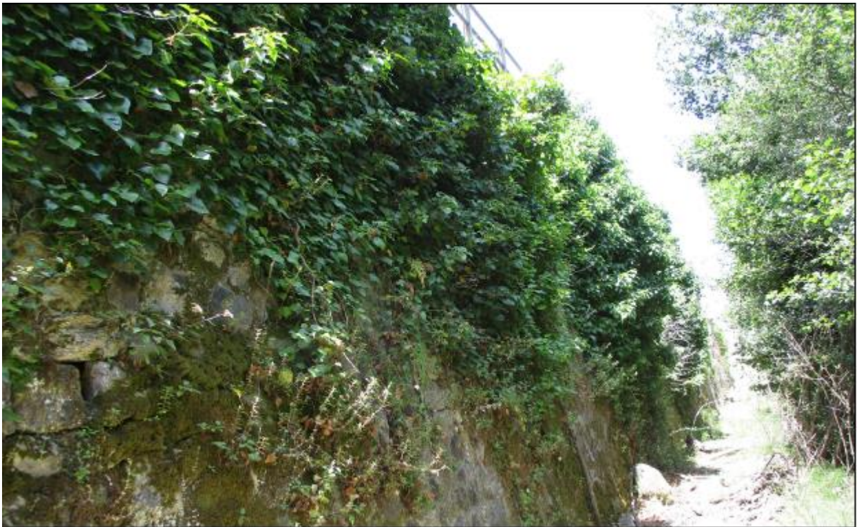
Figura 8-1 – Muro di sottoscarpa esistente al km 28 circa
