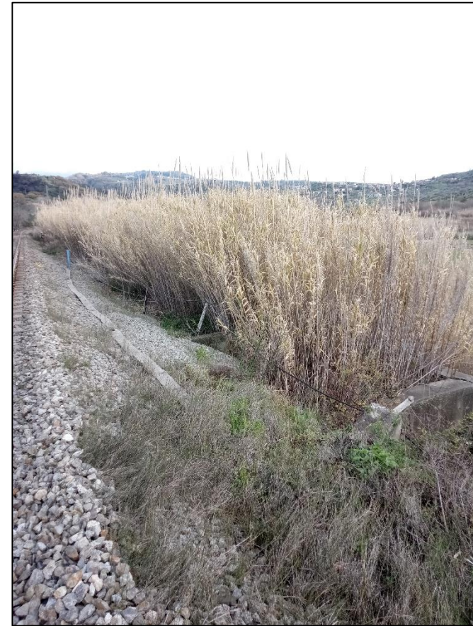
Tratto terminale del muro di contenimento (Foto 3).
