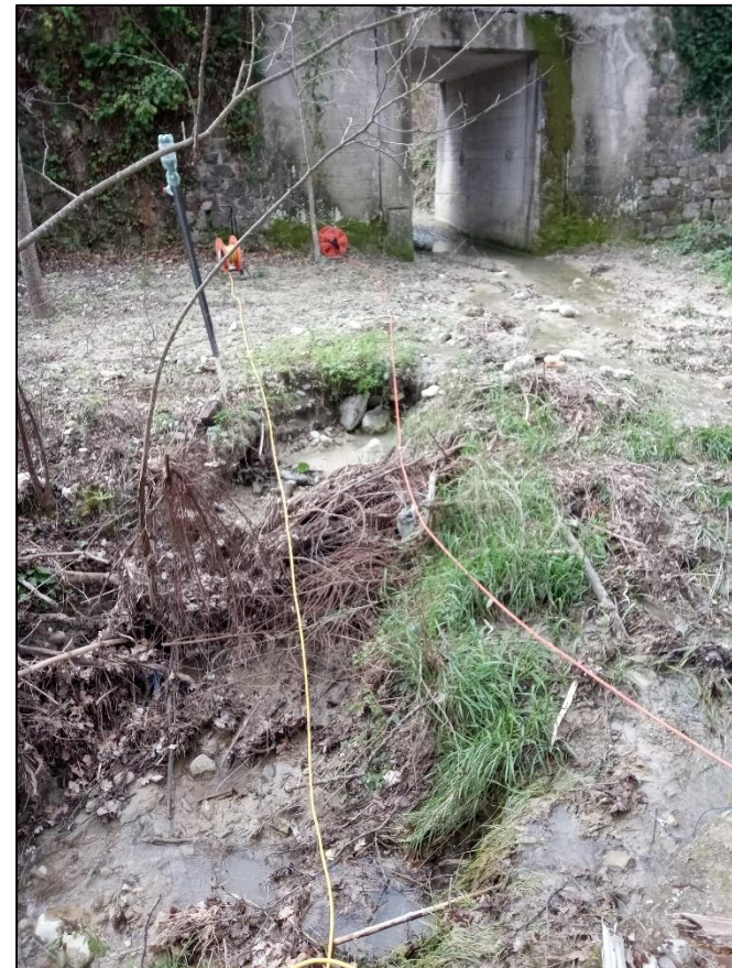
Fase di acquisizione dati ERT21/L2 – tratto centrale
