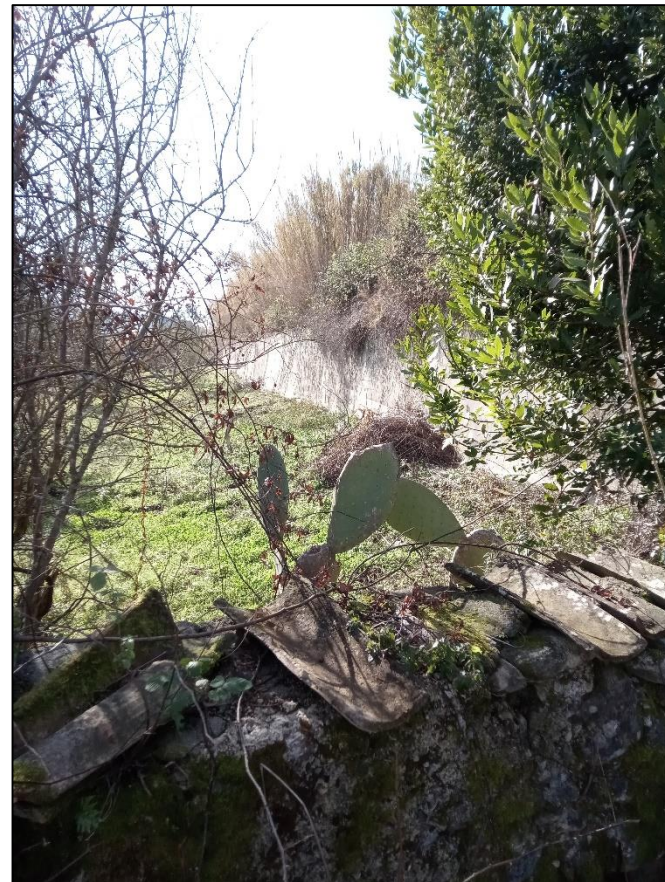
Sviluppo del muro di contenimento ubicato a valle del tracciato ferroviario (Foto 2). Il manufatto è privo di correttivi idraulici
