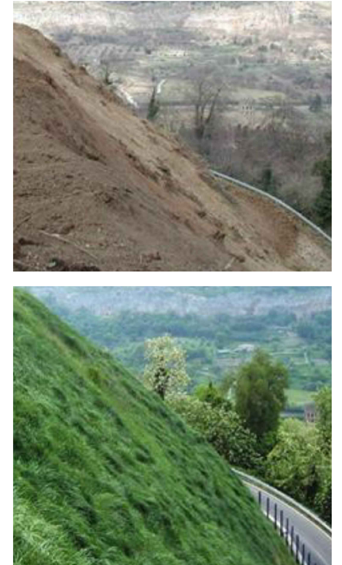
INTERVENTI DI STABILIZZAZIONE tipo PRATI ARMATI
