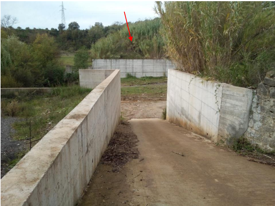
Foto 4 - Vista dell'area di cantiere AT.11 (fonte sopralluogo)
