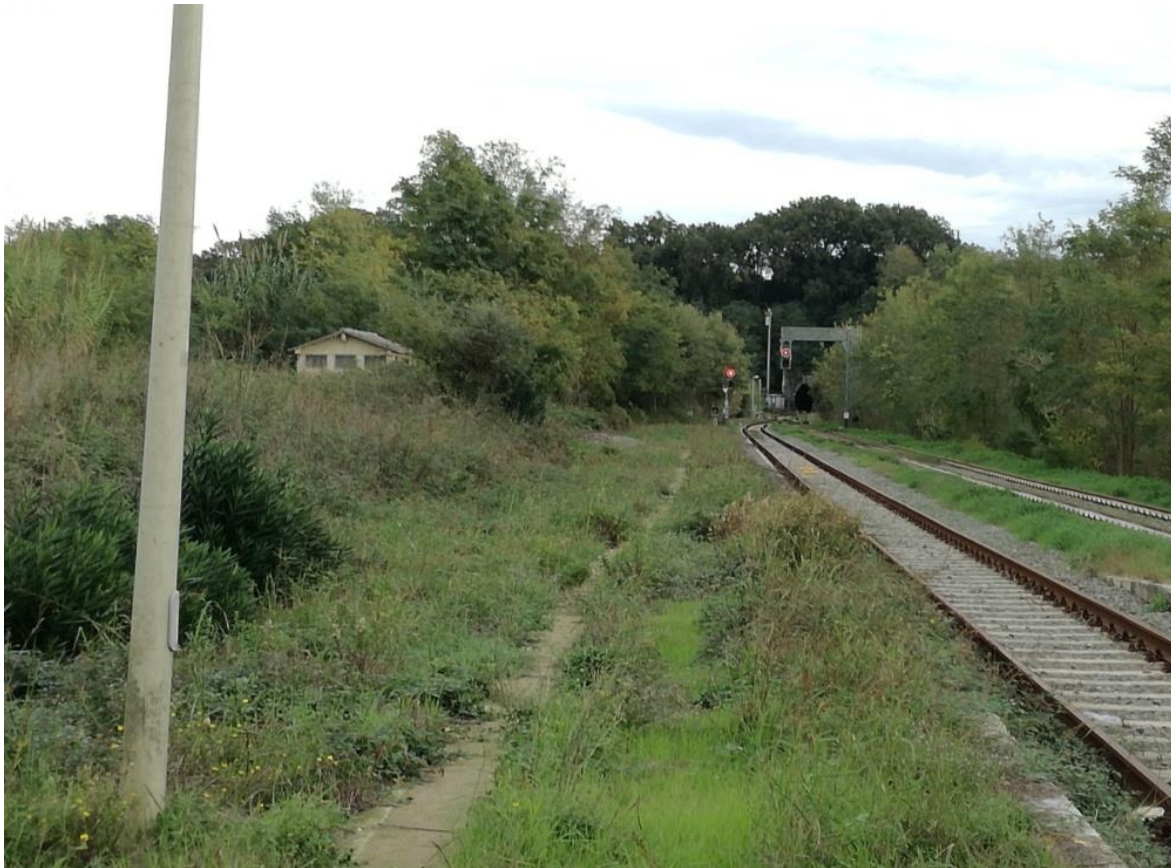
Foto 1 – (vista dell'area di cantiere)
