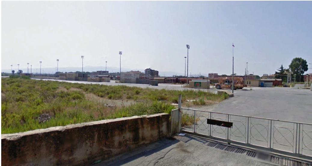
Foto 1 – (vista dell'area di cantiere dall'accesso di via Bosco Amatello)
