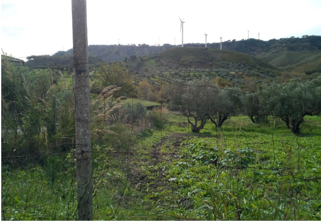
Foto 1 - Vista delle aree di cantiere lungo linea (AT.27, AT.28 e AT.29) e del sedime di installazione della pista di cantiere (fonte: sopralluogo)
