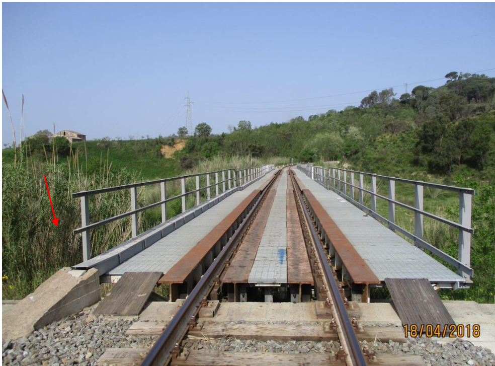
Foto 1 - Vista dell'area di cantiere AT.11 (fonte sopralluogo)
