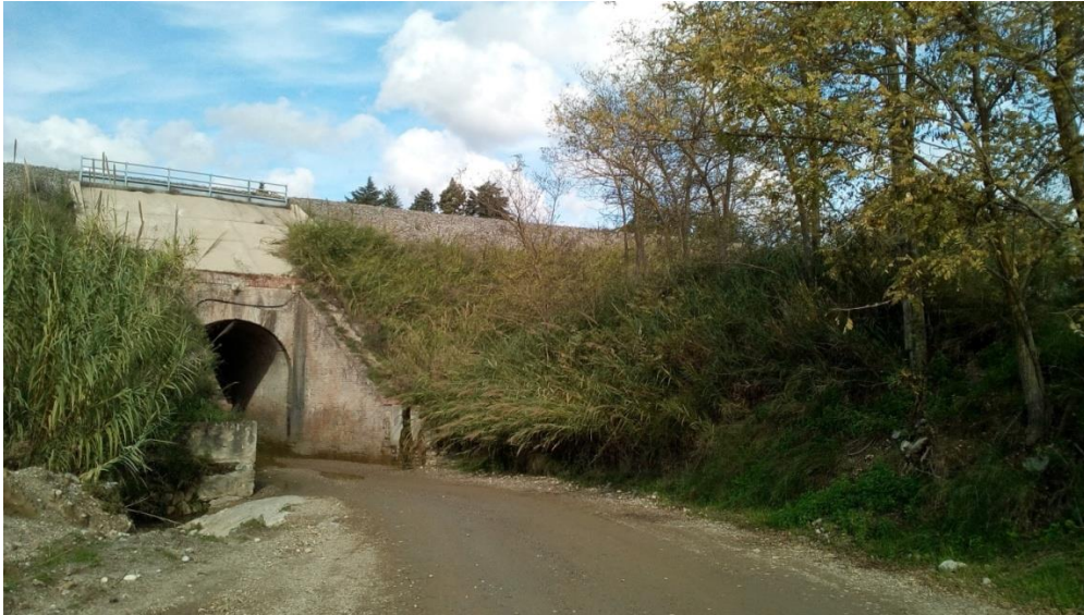
Foto 2 - Vista del sottopasso di accesso alle aree di cantiere (fonte sopralluogo)
