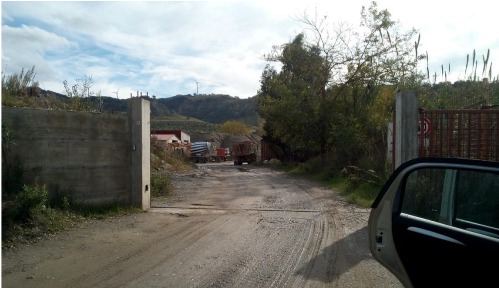
Vista dell'ingresso dell'impianto di betonaggio
