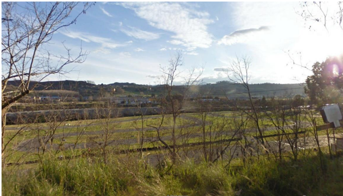
Foto 1 - Vista dell'area di cantiere CB.01 e CO.01 (fonte google earth)
