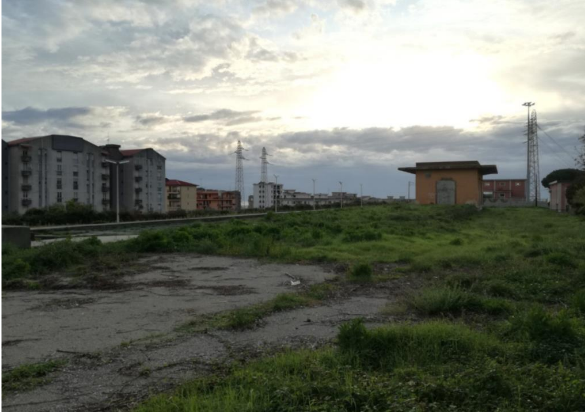
Foto 1 – (vista dell'area di cantiere)
