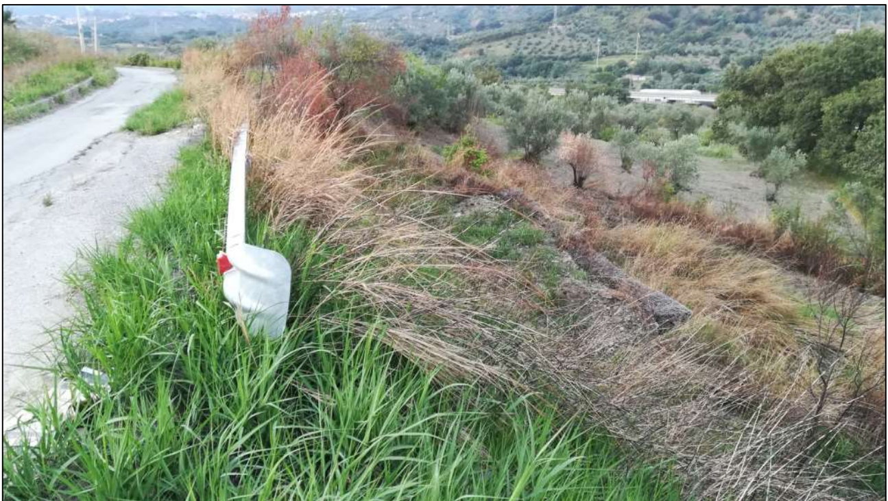
Figura 11-50 - la stessa nicchia della foto precedente che prosegue, si vede la strada deformata e nel pendio una serie di gabbionate in pietra ribaltate.
