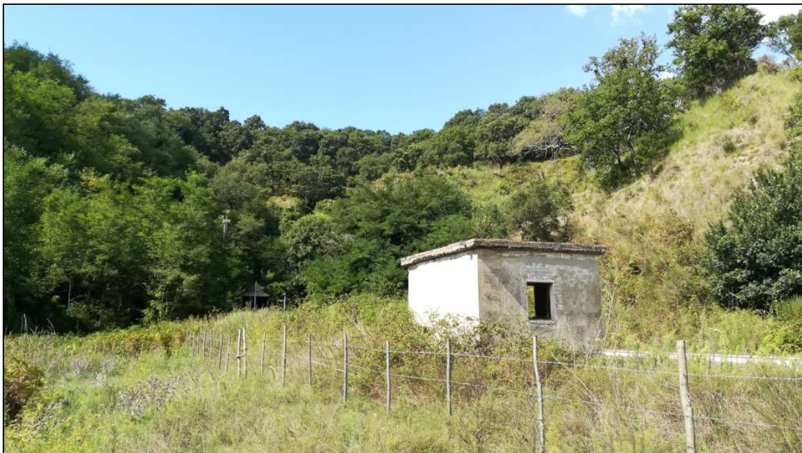
Figura 11-16 - Foto dell'imbocco Ovest prima del rimodellamento del versante.
