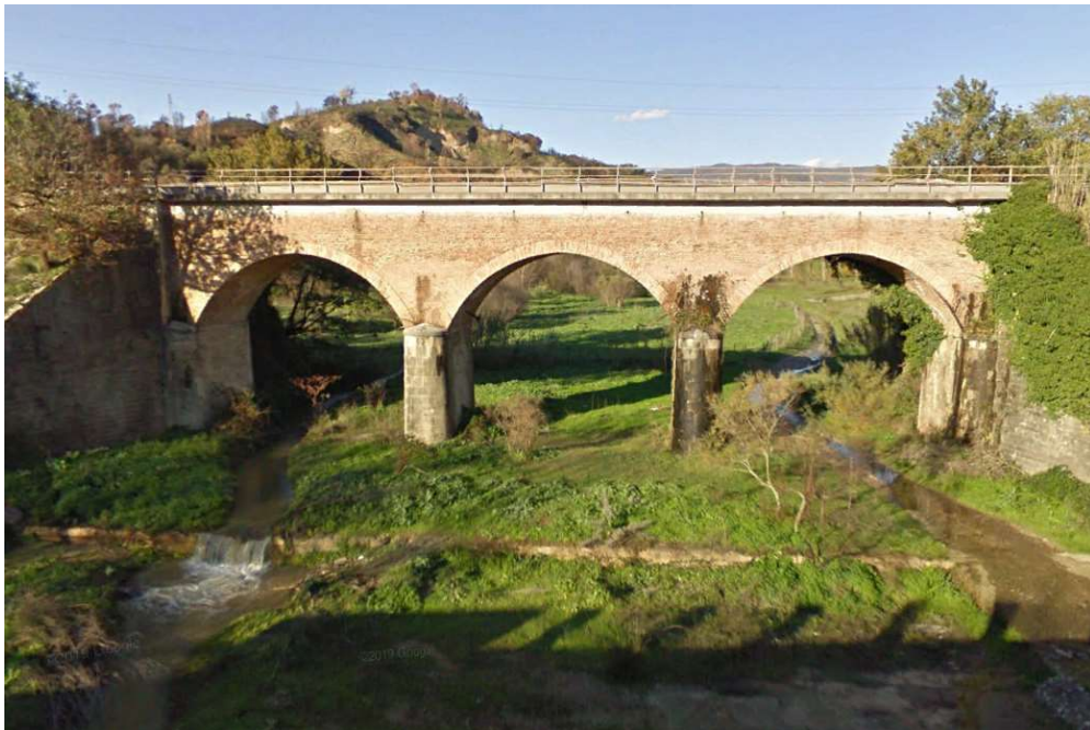
Figura 11-28 – Ponte immediatamente a valle della travata metallica della linea ferroviaria.
