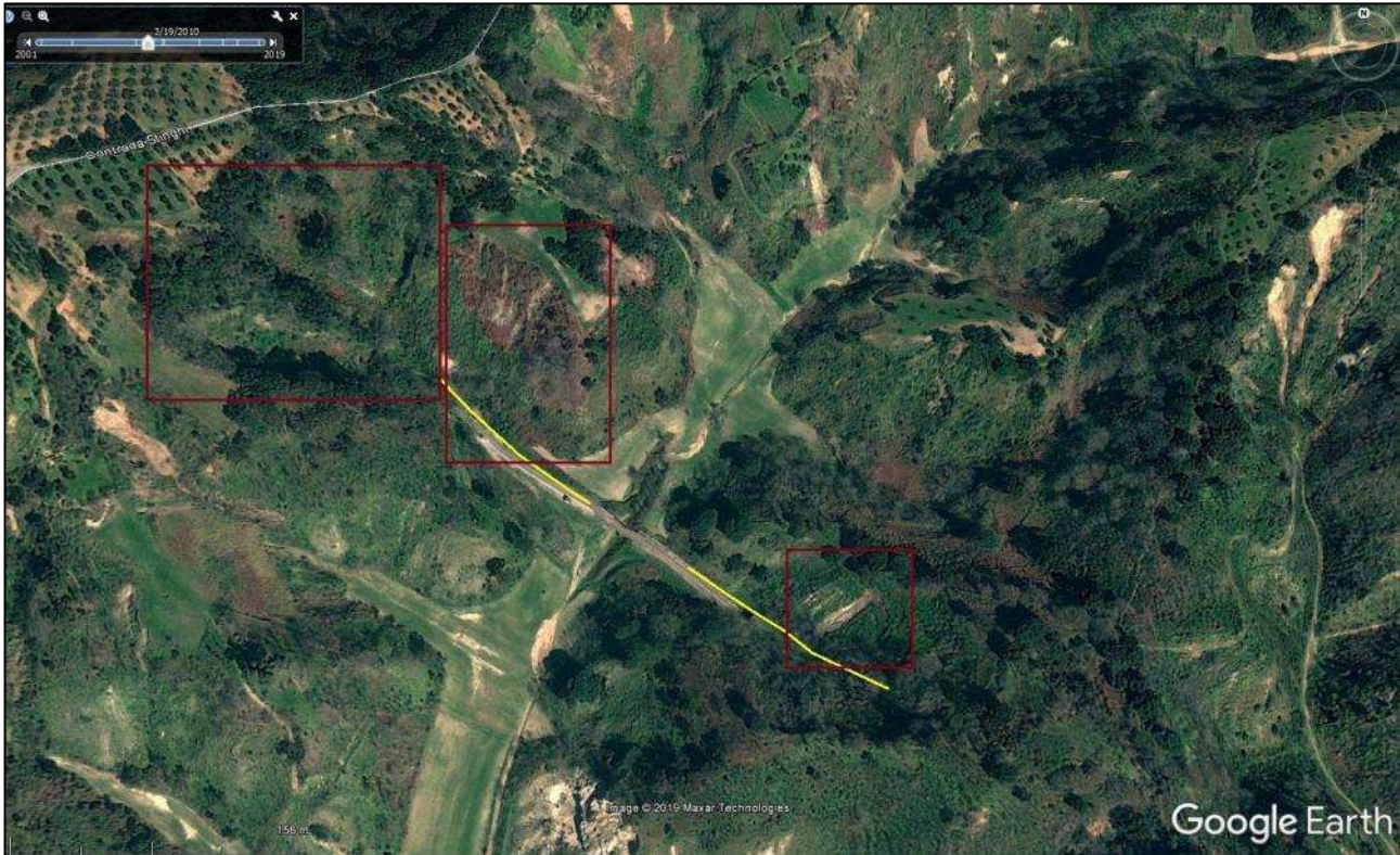
Figura 11-15 - Vista aerea (anno 2010) dell'area delle curve 18 e 19. All'interno dei quadrati rossi sono stati evidenziati gli impluvi sovrastanti all'imbocco Ovest, e un probabile relitto di frana. Vicino all'imbocco Est una frana superficiale.
