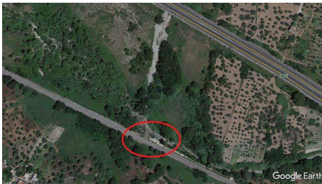
Figura 11-56 - Erosione della base della massicciata dovuta alla naturale divagazione del corso d'acqua nel fondovalle o ad un evento di piena.
