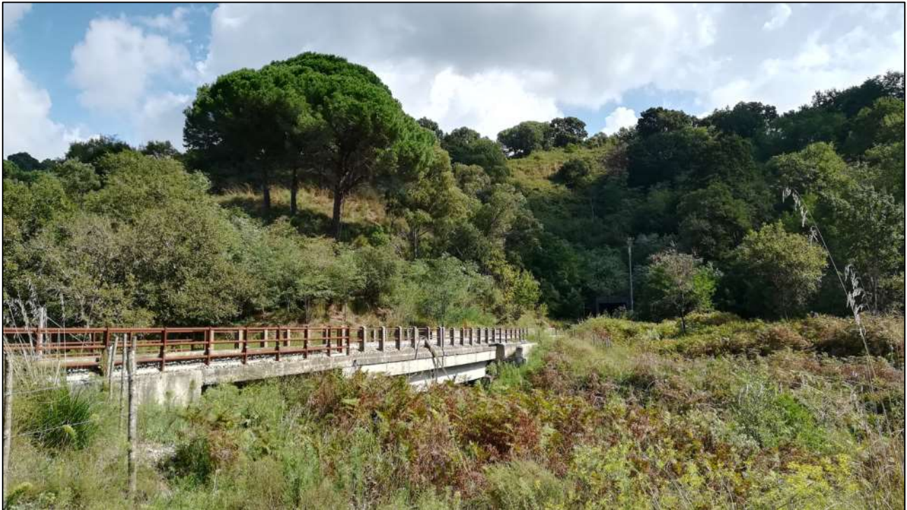
Figura 11-18 - Foto dell'imbocco Est.
