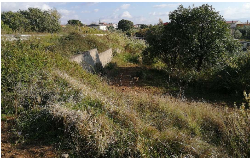
Figura 11-8 – Variante 10, curva 08. Dettaglio del muro di sostegno costruito a ridosso del deposito detritico.
