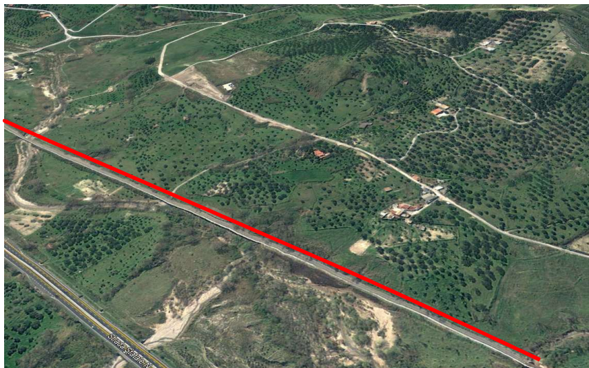
Figura 11-48 – Immagine aerea del 2010 in cui il versante presenta varie aree soggette ad erosione e trasporto gravitativo di materiale in prossimità della linea ferroviaria (in rosso).
