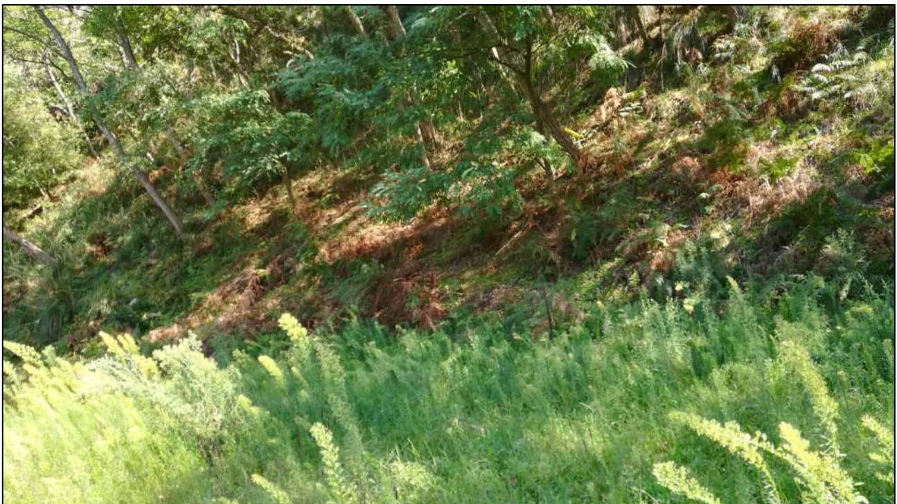
Figura 11-19 - Particolare del raccordo tra pendio e fondovalle, nei pressi dell'imbocco Est.
