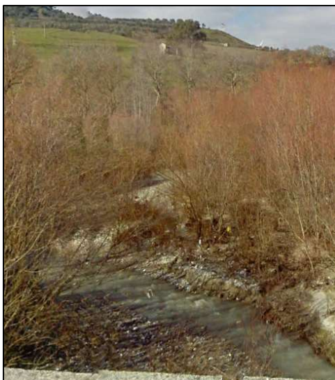
Figura 10-21 – Alveo del Fiume Fallaco presso la variante 9.
