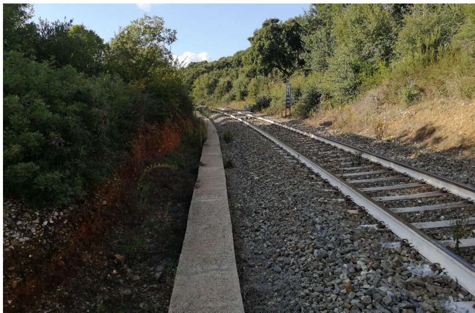
Figura 11-7 – Variante 10, curva 08. L'attuale linea ferroviaria è stata costruita scavando una trincea nel deposito colluviale.
