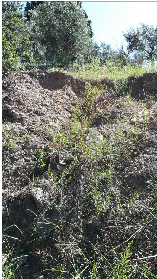
Figura 11-3 - Piccolo colamento dovuto al ruscellamento delle acque superficiali, nei pressi del Cimitero di Nicastro.
