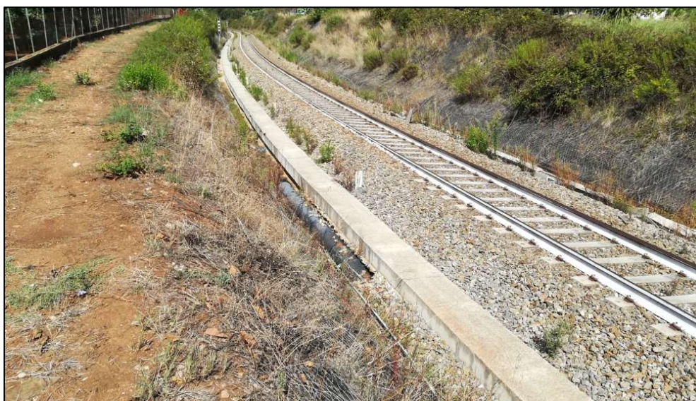
Figura 11-5 - Trincea con pareti in terra; nel tratto a bassa pendenza le scarpate sono dotate di antiersivo e reti in aderenza.
