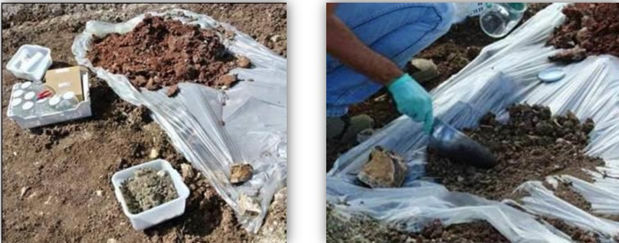
Figura 8-5: Deposito materiale scavato e Campionamento terre.
