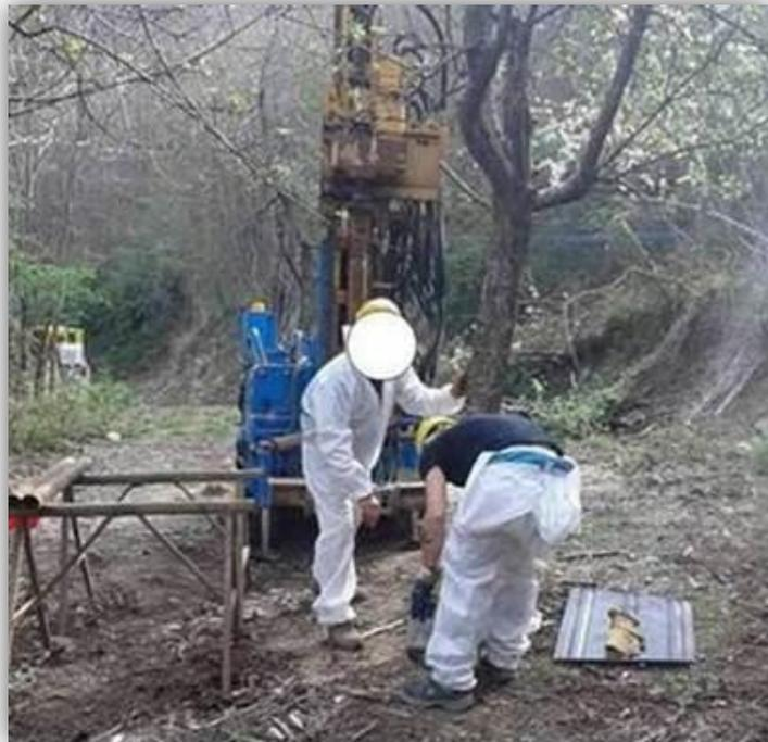
Figura 8-1: Sondaggio effettuato mediante perforazione a carotaggio.
