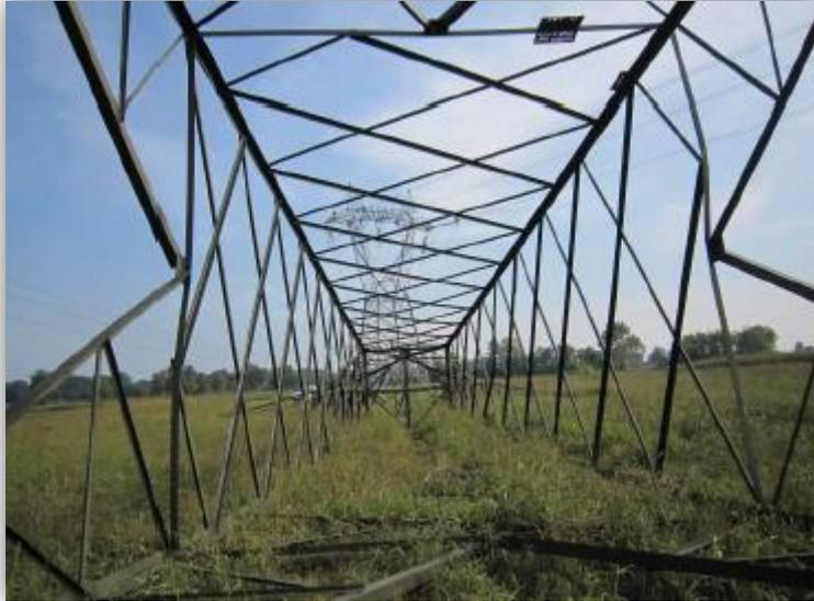
Figura 4-2: Fasi demolizione di un sostegno a traliccio: carpenteria metallica
