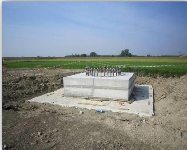
Figura 6-2: Realizzazione di fondazione superficiale tipo plinto a monoblocco per un sostegno monostelo.
