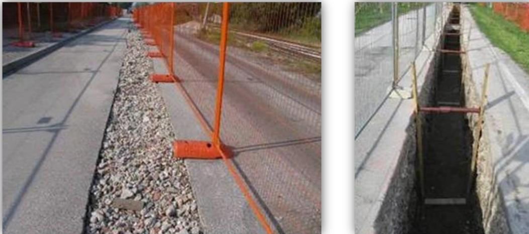
Figura 6-1: Taglio dell'asfaltatura e scavo aperto.
