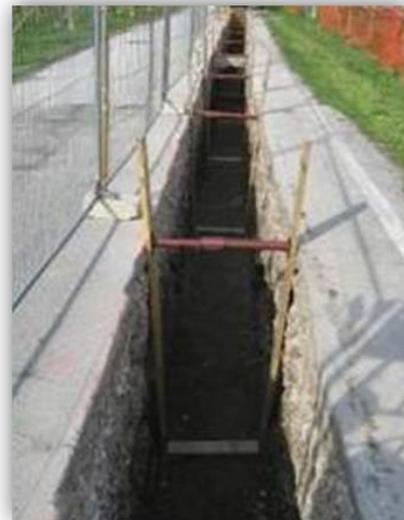
Figura 6-1: Taglio dell'asfaltatura e scavo aperto.
