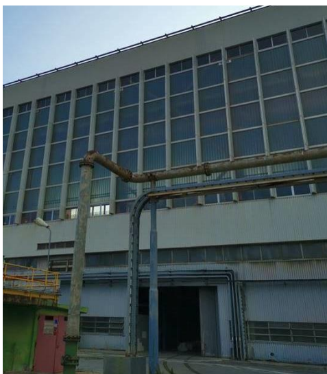
Immagine 6: Esterno sala macchine ex unità VL3-4
