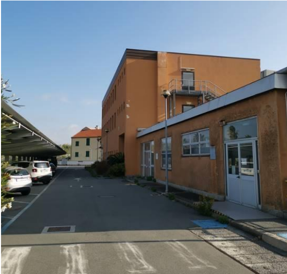
Immagine 1: palazzina Staff (uffici)
