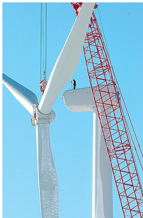
Fig. 5.11 - Installazione della Turbina: montaggio del rotore.
