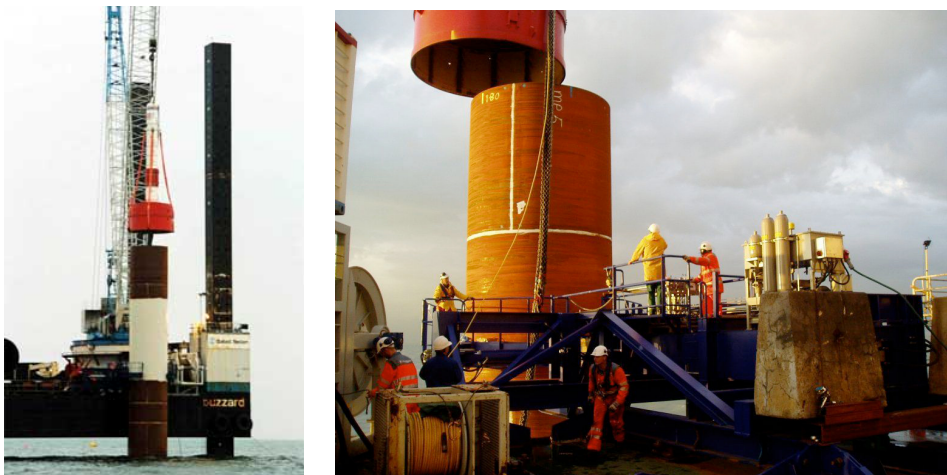
Fig. 5.5 - Fase di sollevamento del maglio e successivo posizionamento in corrispondenza del palo.
