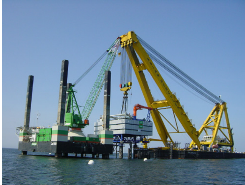
Fig. 5.12 - Installazione della Stazione di trasformazione a mare: operazioni di sollevamento componenti.
