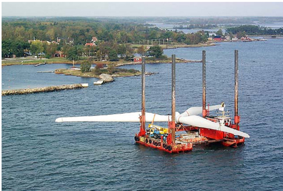
Fig. 5.10 - Installazione della Turbina: trasporto del rotore pre-assemblato a terra.
