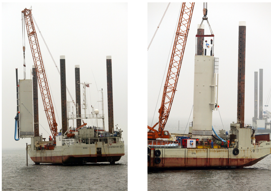
Fig. 5.7 - Installazione del pezzo di transizione.
