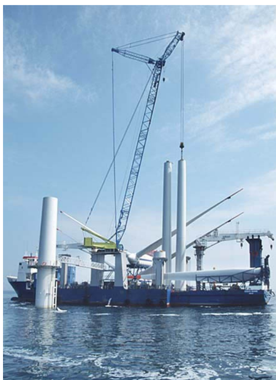
Fig. 5.8 - Installazione della Turbina: montaggio dei conchi di torre.
