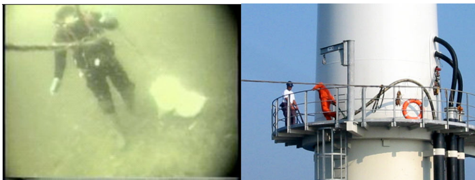
Fig. 5.13 - Posa dei cavi sottomarini: Inserimento del cavo nel tubo a J.
