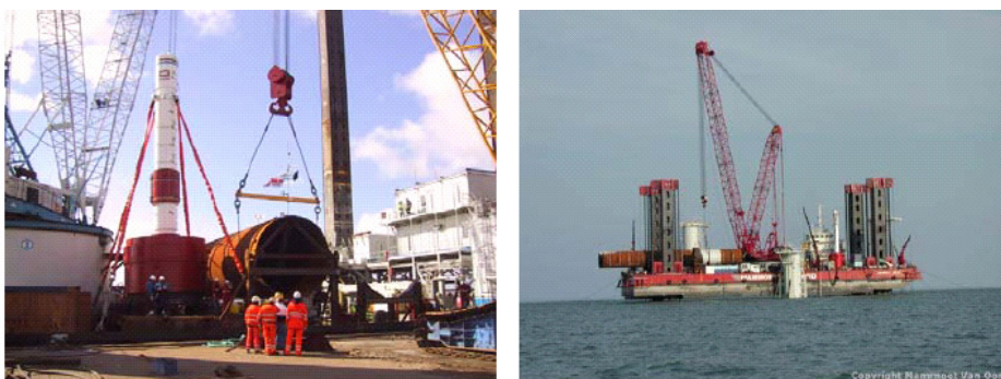
Fig. 5.3 - Operazioni portuali di carico dei pali di fondazione sul pontone.
