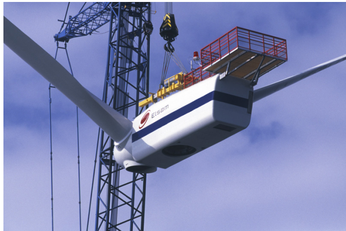
Fig. 5.9 - Installazione della Turbina: sollevamento della navicella e del rotore.
