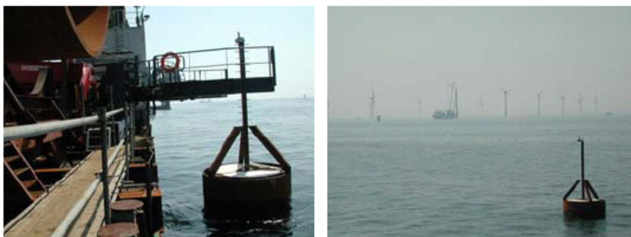
Fig. 5.6 - Faro di segnalazione temporaneo installato sul palo di fondazione appena installato.
