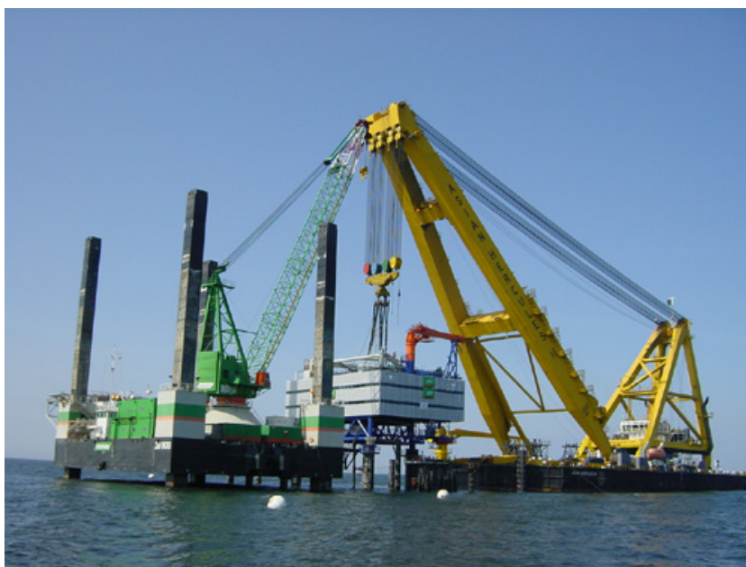
Figura 4.35 – Installazione della Stazione di trasformazione a mare: operazioni di sollevamento componenti.
