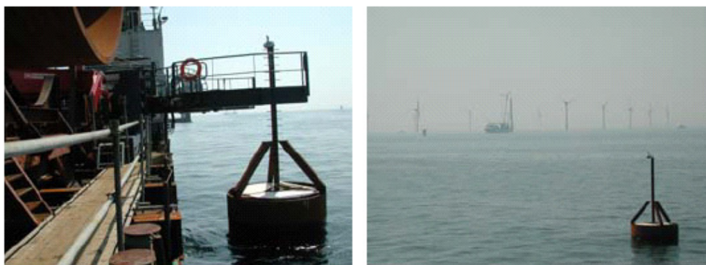
Figura 4.29 – Faro di segnalazione temporaneo installato sul palo di fondazione appena installato.
