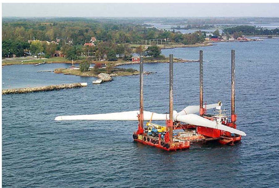
Figura 4.33 – Installazione della Turbina: trasporto del rotore pre-assemblato a terra.
