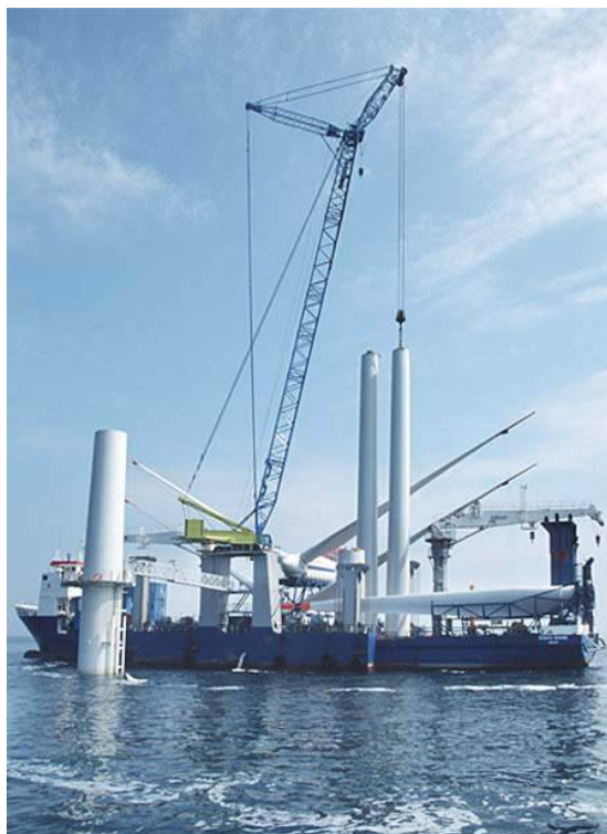
Figura 4.31 – Installazione della Turbina: montaggio dei conci di torre.
