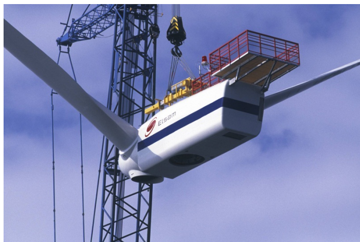
Figura 4.32 – Installazione della Turbina: sollevamento della navicella e del rotore.
