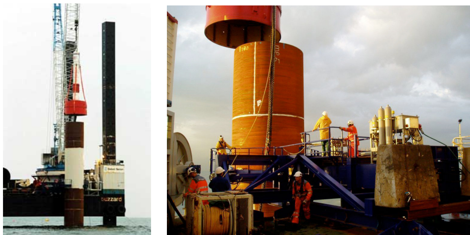
Figura 4.28 – Fase di sollevamento del maglio e successivo posizionamento in corrispondenza del palo.
