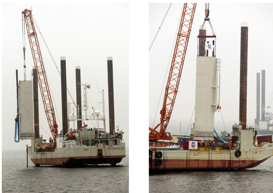
Figura 4.30 – Faro di segnalazione temporaneo installato sul palo di fondazione appena installato.
