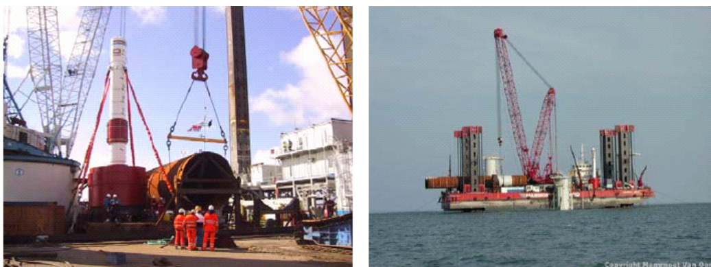
Figura 4.26 – Operazioni portuali di carico dei pali di fondazione sul pontone.
