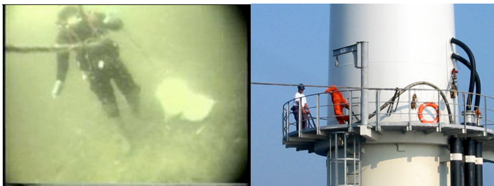
Figura 4.36 – Posa dei cavi sottomarini: Inserimento del cavo nel tubo a J.
