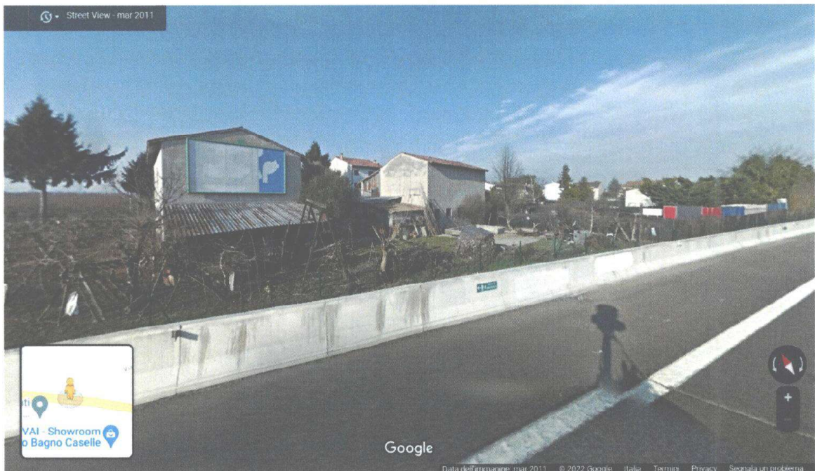
Vista dall'A4 verso nord, verso l'abitato di Caselle: il nastro autostradale dell'A4 (non dell'A22) è direttamente adiacente alle case di Caselle (NB la foto è del 2011: oggi nello stesso tratto vi è una barriera antirumore, ma la distanza fra A4 e l'abitato è evidentemente la medesima)
