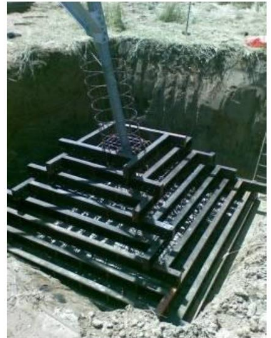
Figura 5 - Esempio di realizzazione di una fondazione a plinto con riseghe. Nell'immagine di sinistra di può osservare un disegno di progetto mentre nell'immagine di destra la fase di casseratura della fondazione
