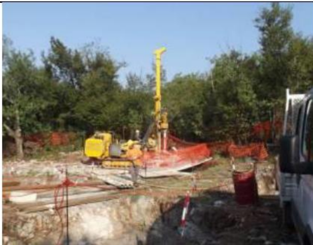
Figura 12 - Esempio di realizzazione di una fondazione su micropali tipo tubfix. Nell'immagine di destra si può notare il particolare del raccordo tra i tubolari metallici dei micropali con l'armatura del plinto di fondazione; al centro del plinto si nota il moncone del sostegno (elemento di raccordo tra il sostegno e la fondazione) il quale viene annegato nella fondazione stessa
