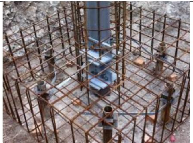
Figura 12 - Esempio di realizzazione di una fondazione su micropali tipo tubfix. Nell'immagine di destra si può notare il particolare del raccordo tra i tubolari metallici dei micropali con l'armatura del plinto di fondazione; al centro del plinto si nota il moncone del sostegno (elemento di raccordo tra il sostegno e la fondazione) il quale viene annegato nella fondazione stessa
