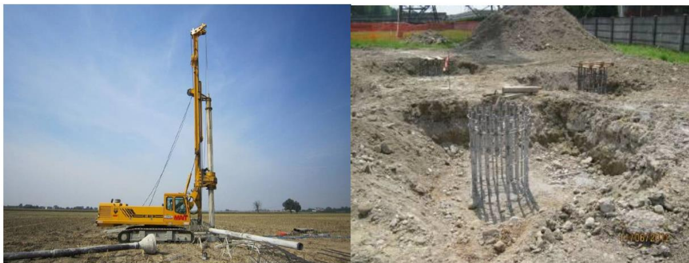
Figura 10 - Macchina operatrice per la realizzazione di pali trivellati
