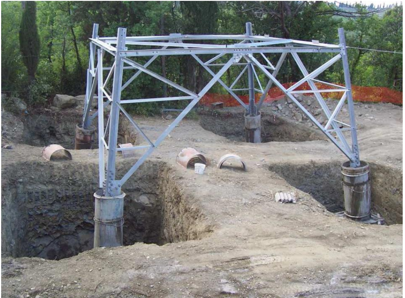
Figura 8 - Realizzazione di fondazioni superficiali tipo CR per un sostegno a traliccio. Nell'immagine si possono osservare le quattro buche, la base del sostegno collegata alla fondazione tramite i "monconi" ed i casseri utilizzati per i quattro "colonnini"
