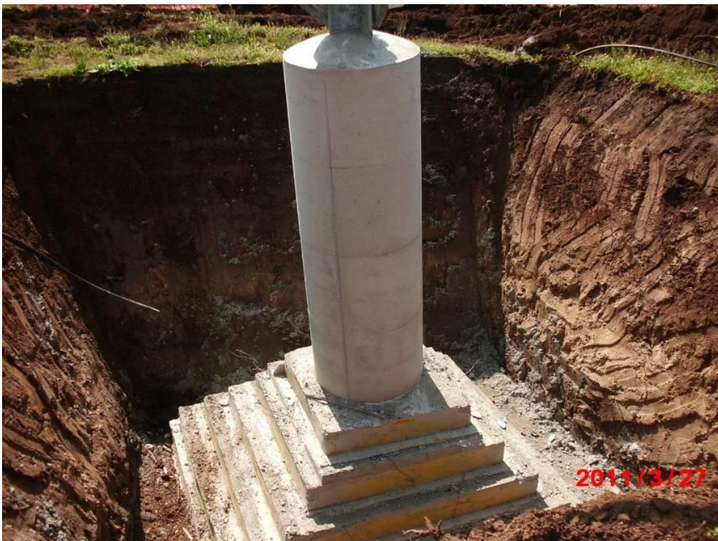
Figura 7 - Realizzazione di fondazioni superficiali tipo CR per un sostegno a traliccio. Nell'immagine si può osservare una fondazione CR appena "scasserata". Si possono distinguere facilmente la parte inferiore a parallelepipedo tronco piramidale e il colonnino di raccordo con la "base" del sostegno
