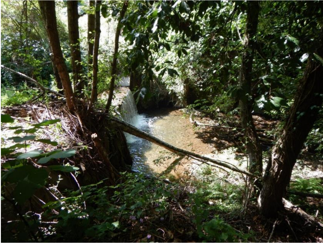
Briglia in calcestruzzo lungo l'alveo del T. Pesipe
