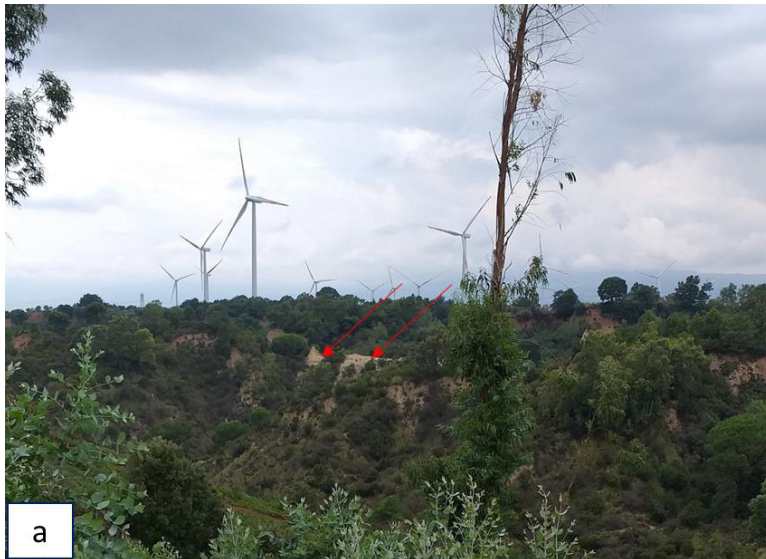
Figura 13: a. esempio di versante ubicato nei dintorni del sostegno 16 in cui sono stati osservati fenomeni di erosione accelerata; b. esempio di versante ubicato nei dintorni del sostegno 16 in cui sono stati osservati fenomeni di instabilità di versante.
