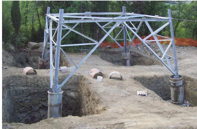
Figura 16: Realizzazione di fondazioni superficiali tipo CR per sostegno a traliccio. Nell'immagine si osservano le quattro buche, la base del sostegno collegata alla fondazione tramite i "monconi" e i casseri utilizzati per i quattro "colonnini"
