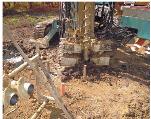
Figura 21: Macchina operatrice per la realizzazione di micropali tubfix. A sinistra sistema di scavo a rotopercussione, a destra sistema di scavo mediante trivella elicoidale.
