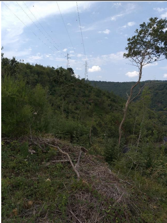
Foto 2 – Vista della scarpata a NNW in direzione ENE verso WSW in prossimità del sostegno A1
