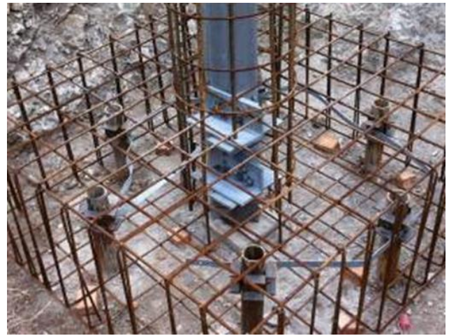
Figura 20: Esempio di realizzazione di fondazione su micropali tipo tubfix. Nell'immagine di destra è mostrato il raccordo tra i tubolari metallici dei micropali con l'armatura del plinto di fondazione; al centro del plinto si nota il moncone del sostegno (elemento di raccordo tra il sostegno e la fondazione), inglobato nella fondazione stessa.
