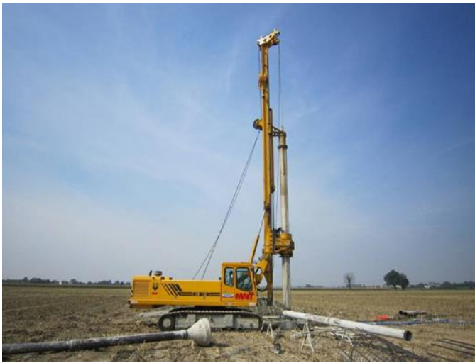
Figura 18: Macchina operatrice per la realizzazione di pali trivellati
