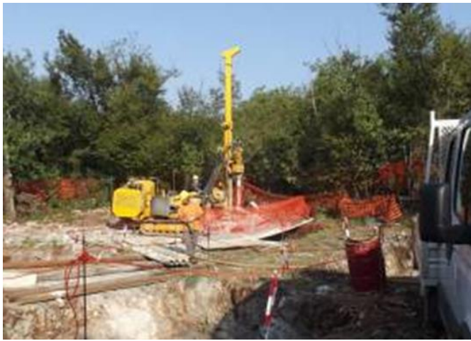
Figura 20: Esempio di realizzazione di fondazione su micropali tipo tubfix. Nell'immagine di destra è mostrato il raccordo tra i tubolari metallici dei micropali con l'armatura del plinto di fondazione; al centro del plinto si nota il moncone del sostegno (elemento di raccordo tra il sostegno e la fondazione), inglobato nella fondazione stessa.
