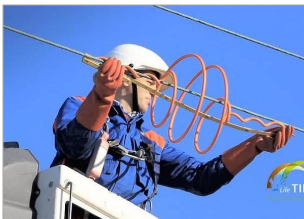
Figura 9: Dissuasore per avifauna (tipo a spirale)
