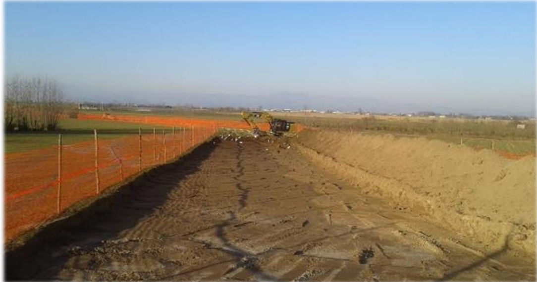
Figura 9-1 – Foto di apertura della pista di lavoro
