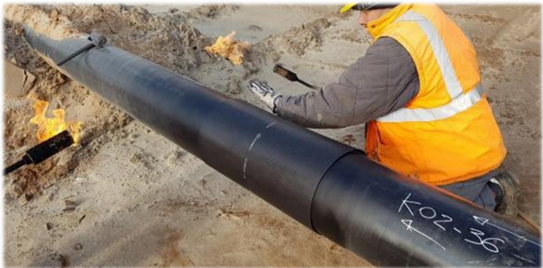
Figura 9-7 – Applicazione manuale di una fascia termo-restringente su giunto saldatura
