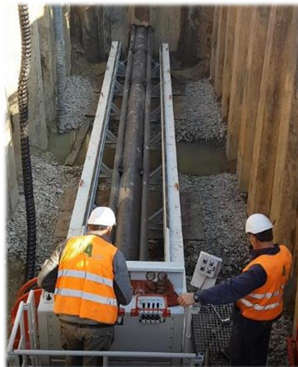
Figura 9-13 – Esecuzione di trivellazione spingitubo
