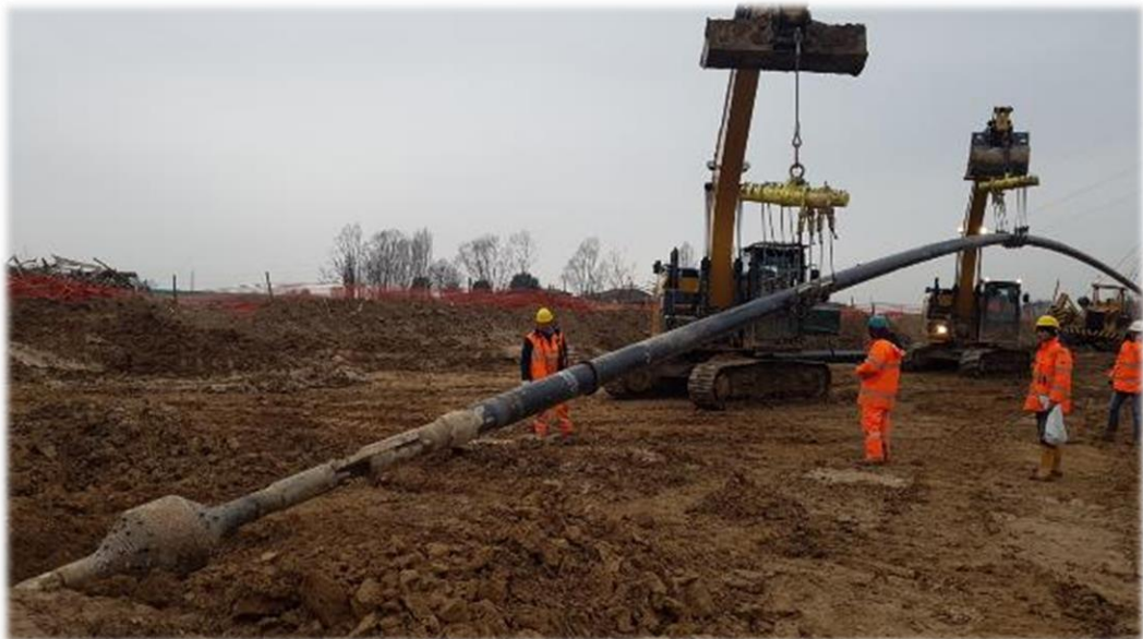
Figura 9-17 – Esempio di operazione di varo della TOC
