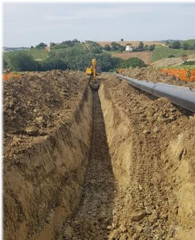
Figura 9-6 – Scavo della trincea
