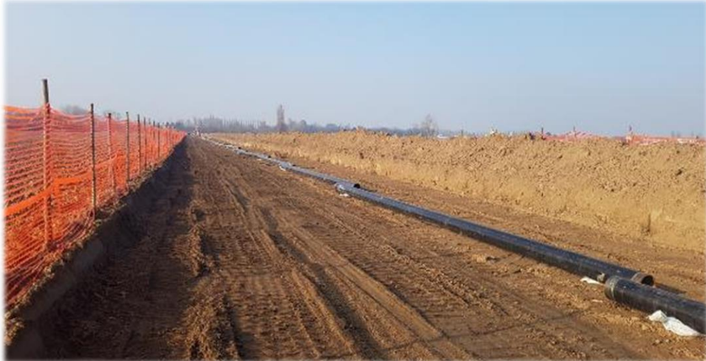
Figura 9-4 – Sfilamento delle tubazioni di linea
