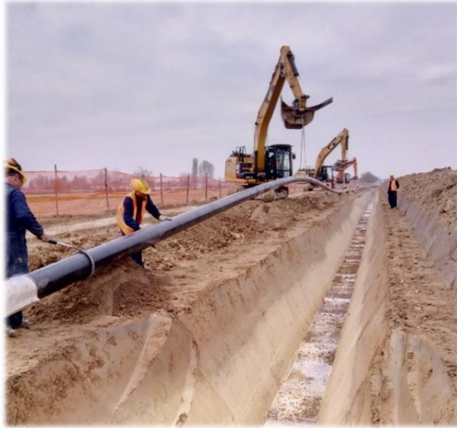
Figura 9-8 – Posa della condotta
