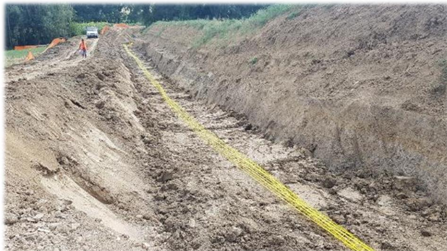
Figura 9-9 – Rinterro della condotta
