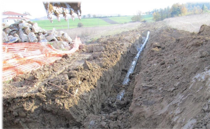
Figura 9-26 – Esempio di scavo e sezionamento della condotta da rimuovere
