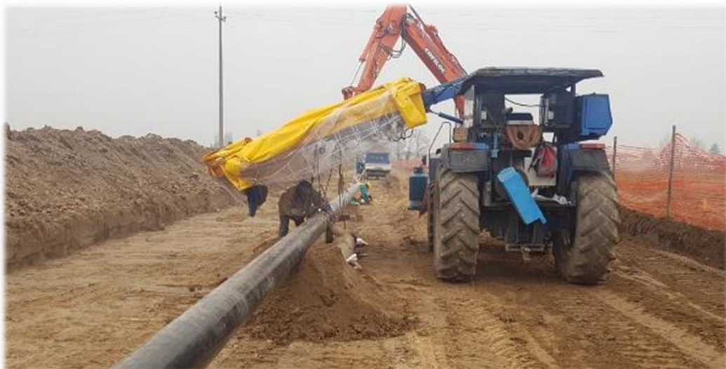
Figura 9-5 – Fase di saldatura manuale
