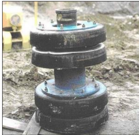
Figura 9-27 – Pig convenzionale impiegato in operazioni di collaudo idraulico e pulizia della condotta
