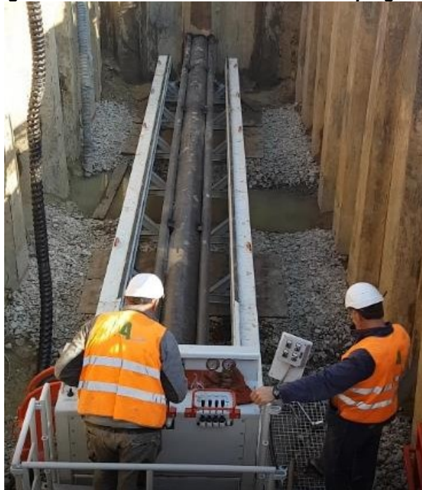
Figura 5-6 – Esecuzione di trivellazione spingitubo
