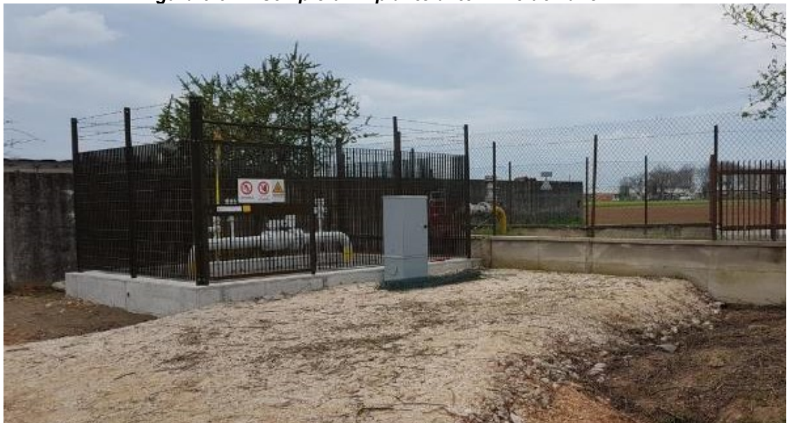
Figura 5-9 – Esempio di impianto al termine dei lavori
