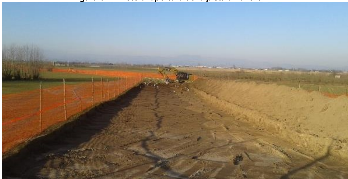
Figura 5-1 – Foto di apertura della pista di lavoro
