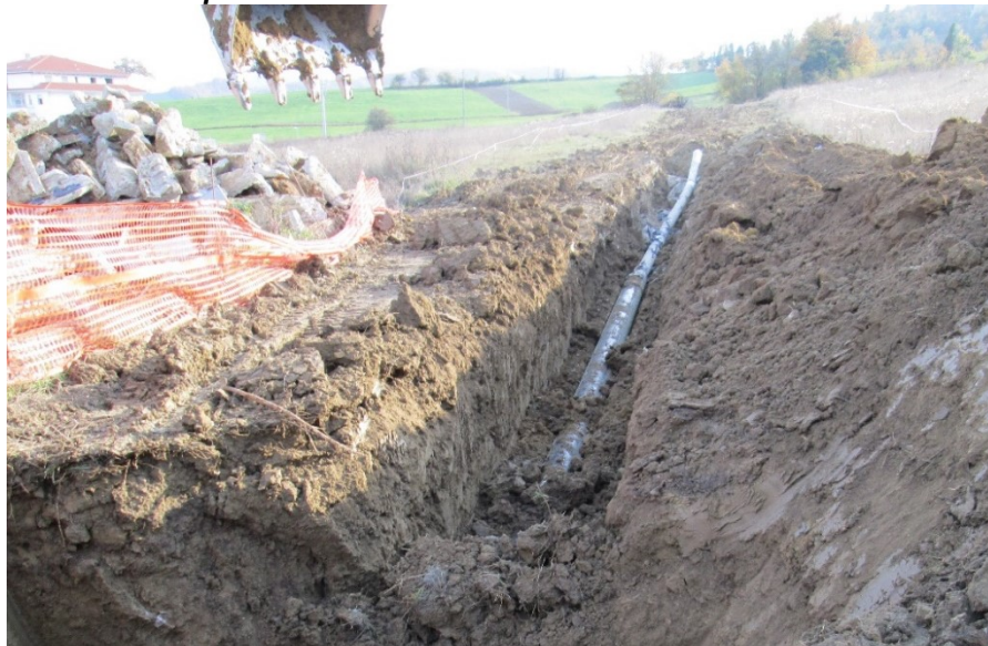
Figura 5-15 – Esempio di scavo e sezionamento della condotta da rimuovere
