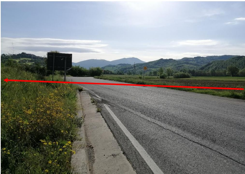
Foto n.16 – Attraversamento S.S. n.219 in trivellazione
