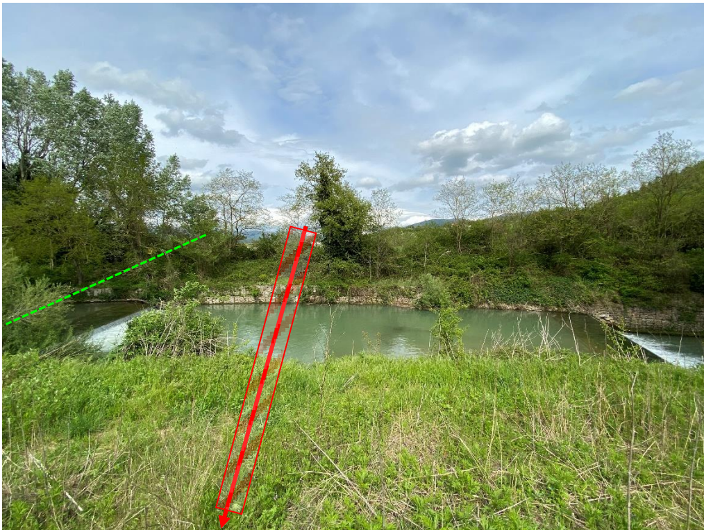
Foto n.6 – Attraversamento Fiume Chiascio in TOC
