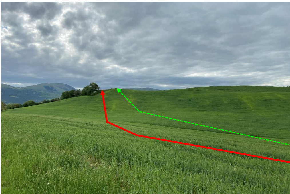
Foto n.57 – Panoramica metanodotto in progetto, risalita versante
