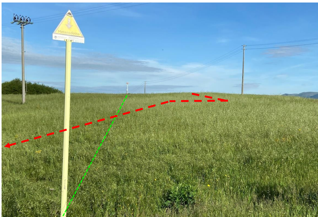
Foto n.46 – Rifacimento Metanodotto Allacciamento Colacem DN 200(8”), DP 75 bar in progetto – attraversamento metanodotto esistente da dismettere
