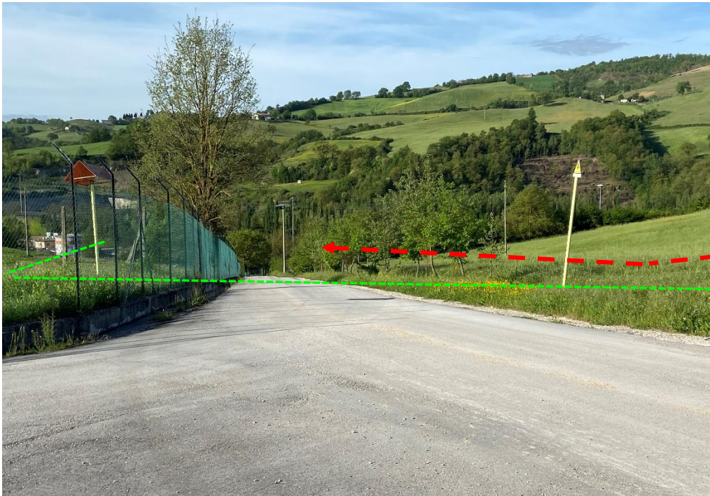
Foto n.47 – Rifacimento Metanodotto Allacciamento Colacem DN 200(8"), DP 75 bar in progetto
