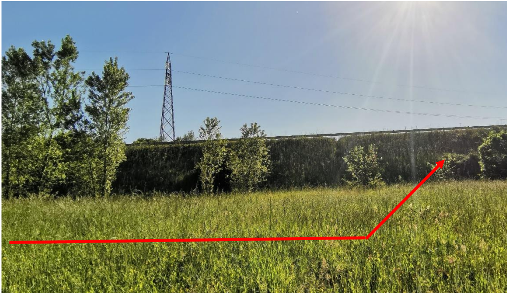
Foto n.23 – Panoramica metanodotto e attraversamento S.S. n.219 in trivellazione
