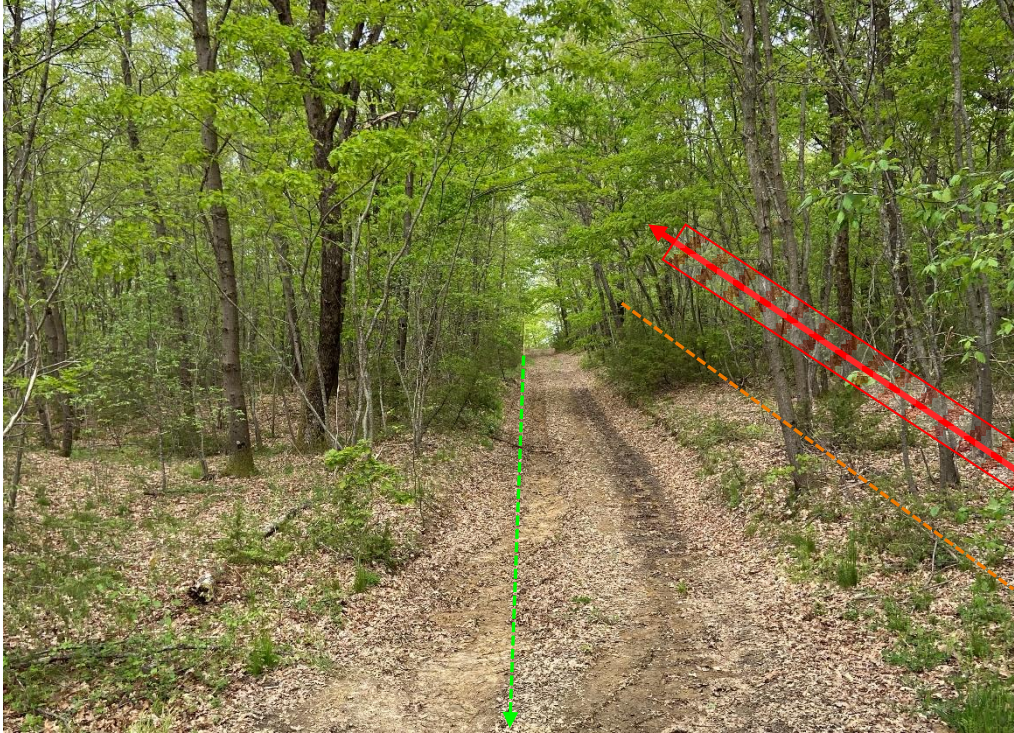
Foto n.31 – Attraversamento area boscata in TOC (vista senso gas in asse a metanodotto esistente)
