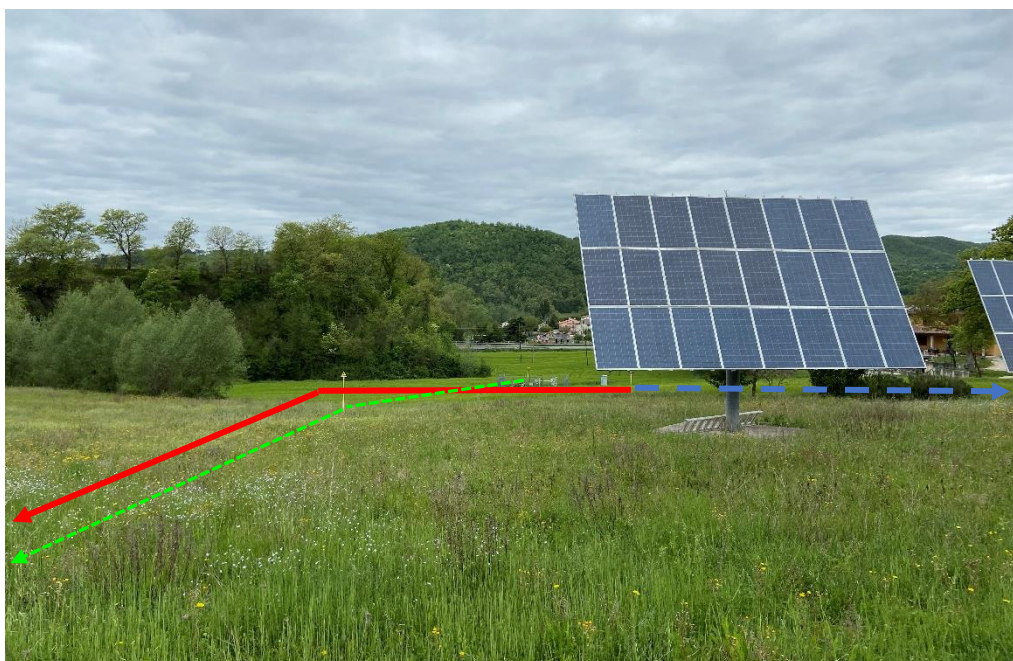
Foto n.51 – Metanodotto “Collegamento a Spina di Gualdo Tadino, DN 150 (6”), DP 75 bar, allargamento per evitare pannelli fotovoltaici
