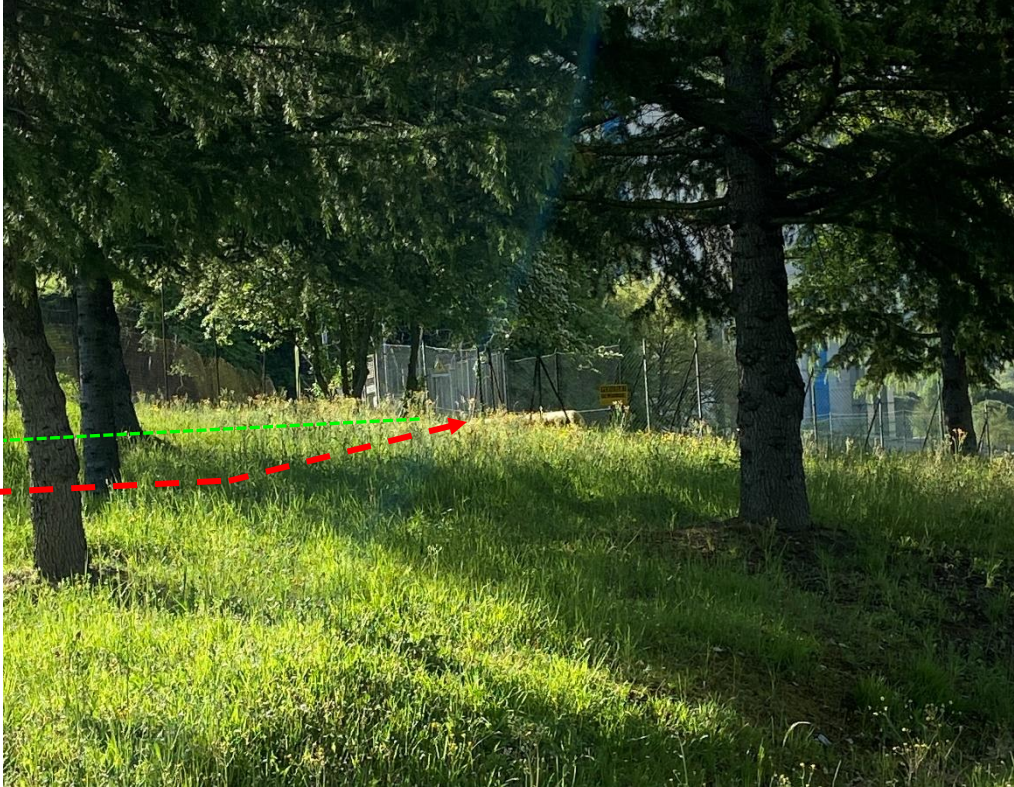
Foto n.49 – Ricollegamento a Cabina Utente Colacem S.p.A.
