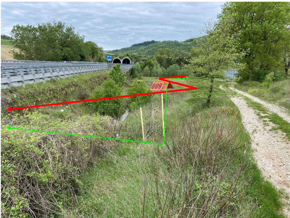
Foto n.53 – Attraversamento S.S. n.318 di Valfabbrica in trivellazione (vista lato ovest)
