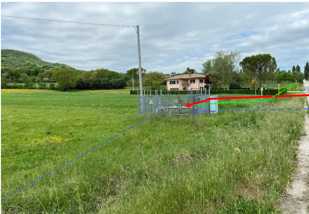
Foto n.75 – Ricollegamento a impianto esistente 4103572/1
