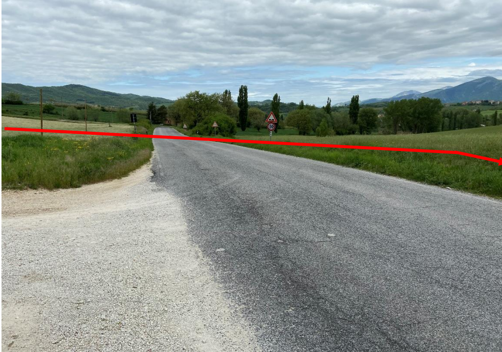
Foto n.60 – Attraversamento S.P. n. 241 in trivellazione
