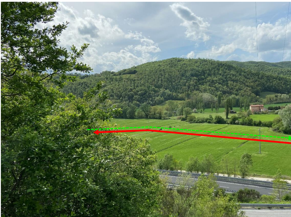
Foto n.4 – Panoramica metanodotto in progetto in parallelismo a metanodotto da dismettere (panoramica da via del Castello)
