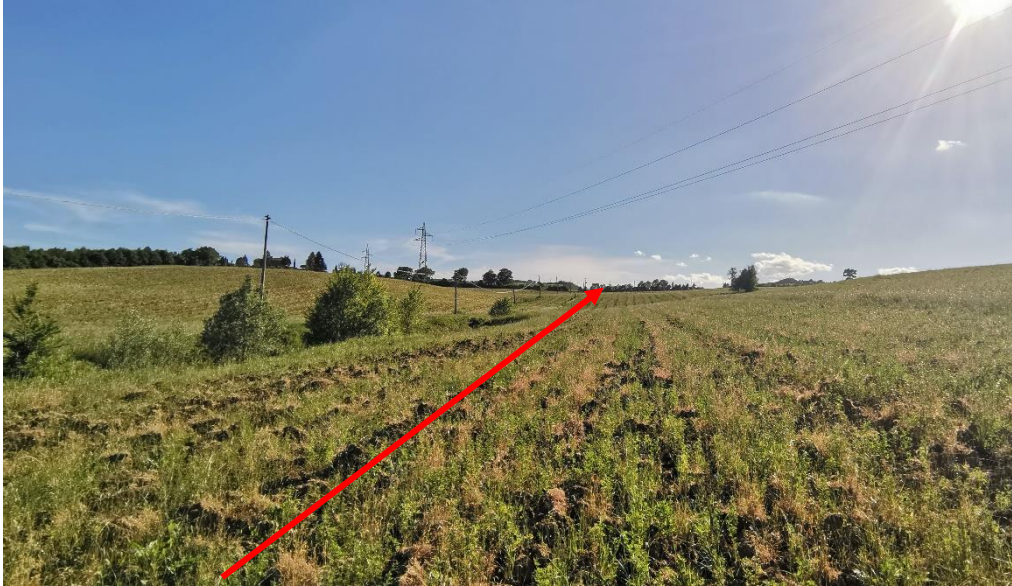
Foto n.43 – Panoramica metanodotto (vista senso gas)
