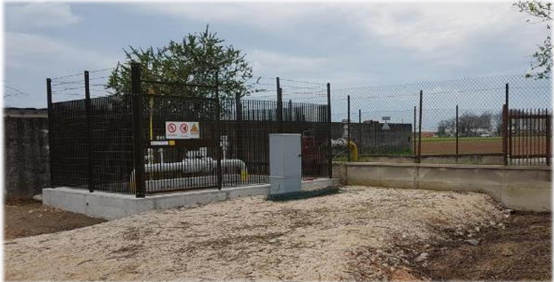
Figura 2-19 – Esempio di impianto al termine dei lavori
