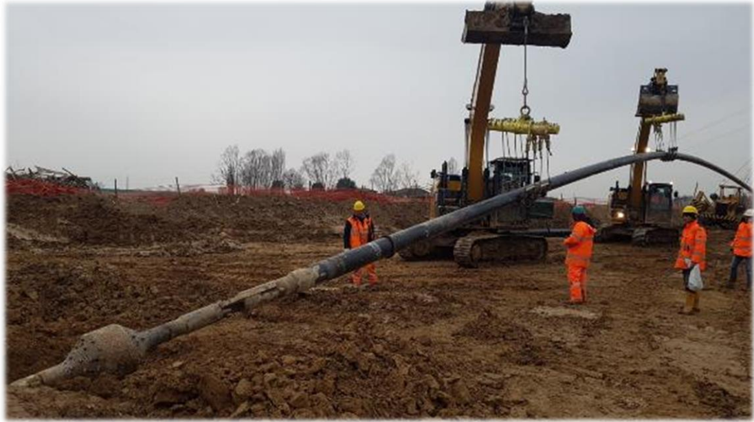
Figura 2-18 – Esempio di operazione di varo della TOC
