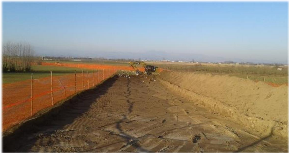
Figura 2-2 – Foto di apertura della pista di lavoro
