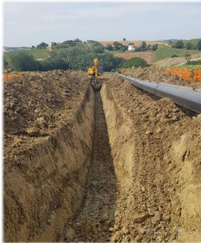
Figura 2-7 – Scavo della trincea
