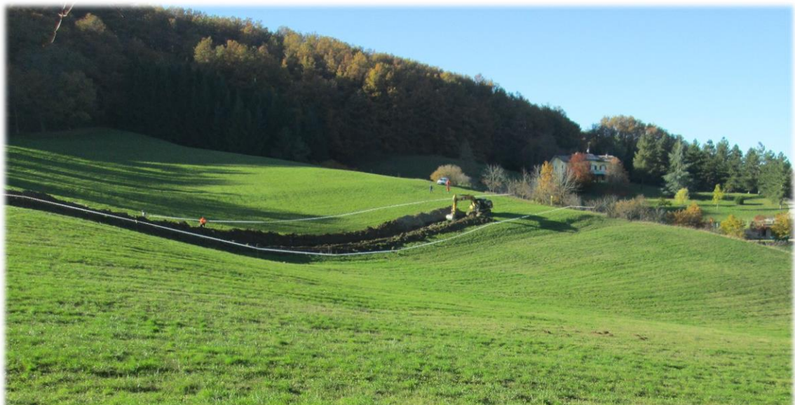
Figura 2-26 – Esempio di apertura della fascia di lavoro per la dismissione
