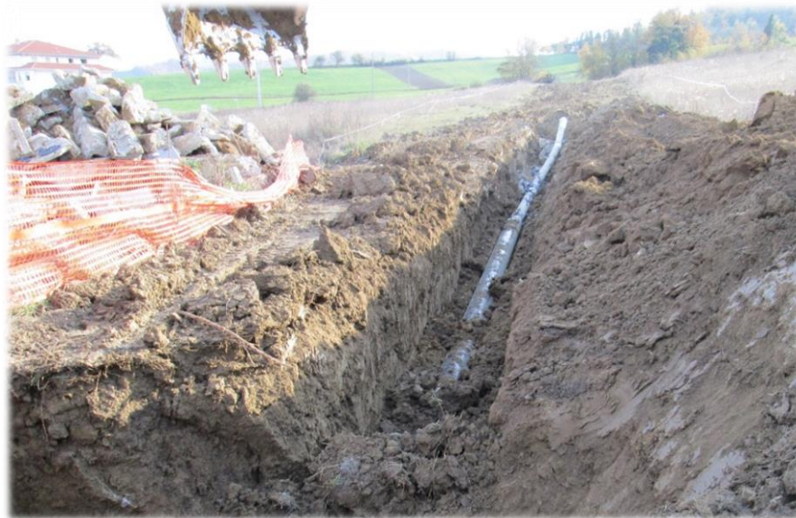
Figura 2-27 – Esempio di scavo e sezionamento della condotta da rimuovere
