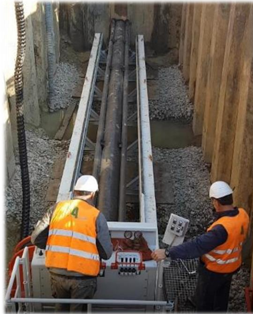
Figura 2-14 – Esecuzione di trivellazione spingitubo
