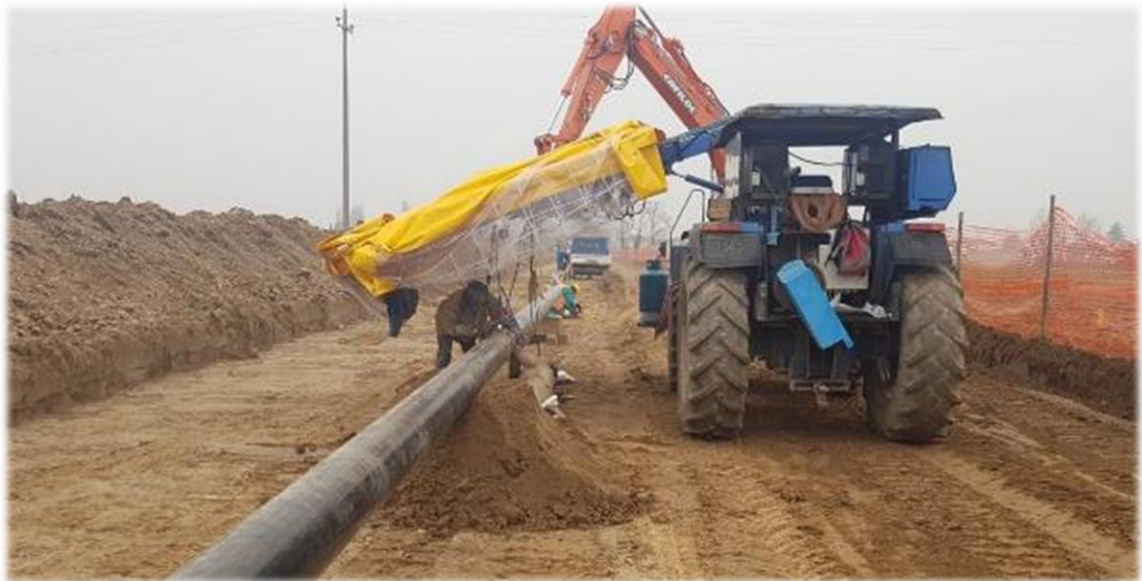
Figura 2-6 – Fase di saldatura manuale
