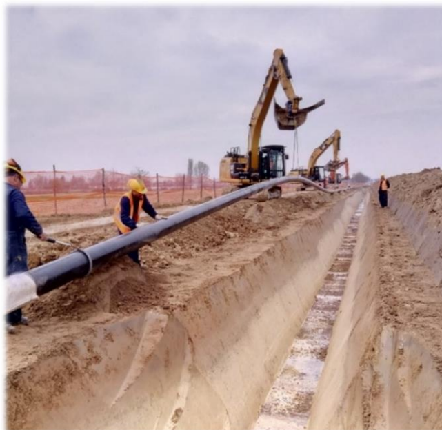
Figura 2-9 – Posa della condotta
