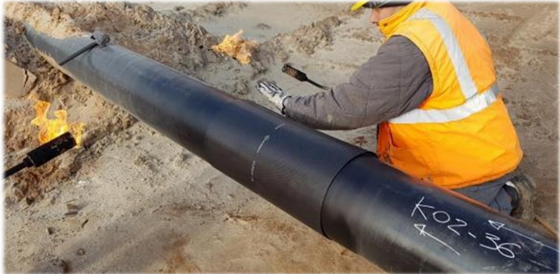
Figura 2-8 – Applicazione manuale di una fascia termo-restringente su giunto saldatura
