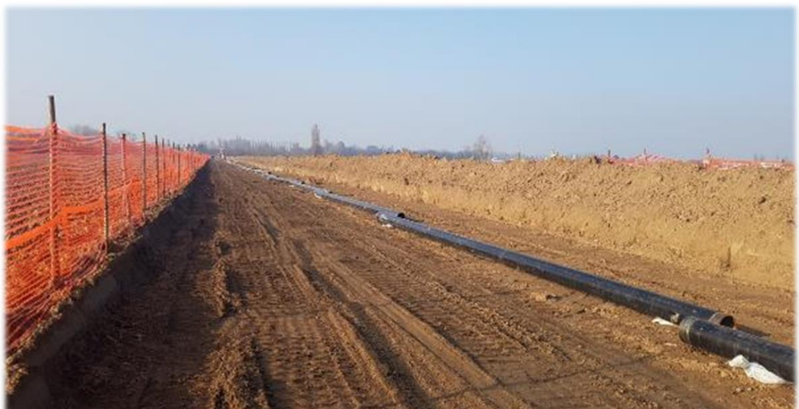
Figura 2-5 – Sfilamento delle tubazioni di linea
