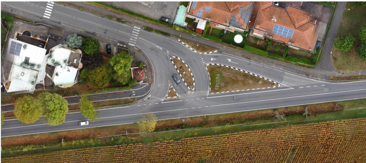
Figura 0-7 – Ortofoto Stato di fatto
