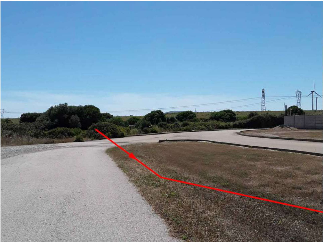
Figura 3–C. Attraversamento con scavo a cielo aperto Strada km 2+742.
