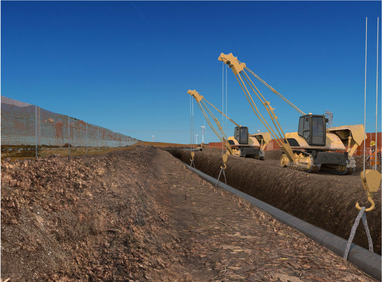
Figura 3-G. Realizzazione della trincea di scavo e posa della condotta.
