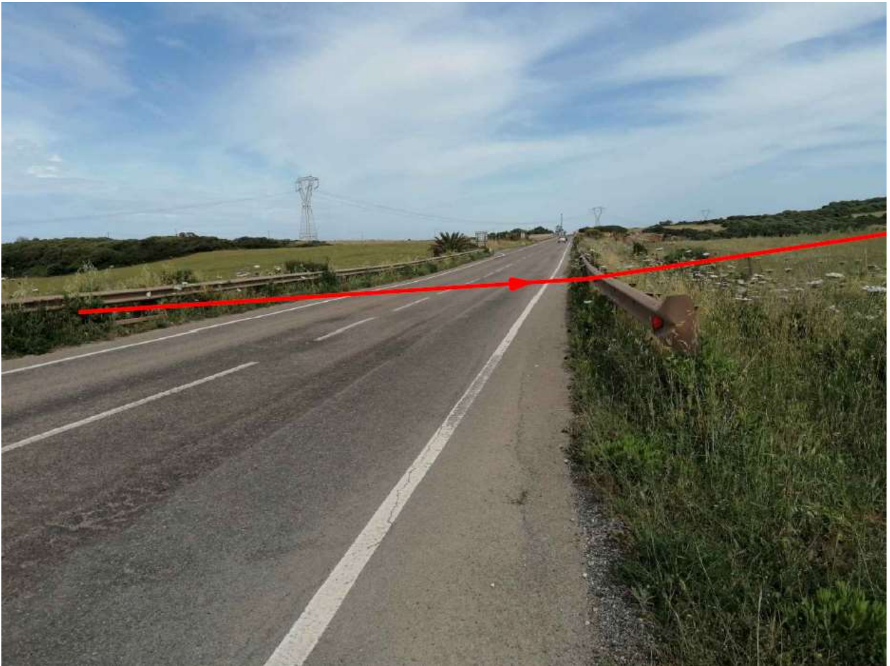
Figura 3-B. Attraversamento in spingitubo Strada Provinciale S.P. 57.
