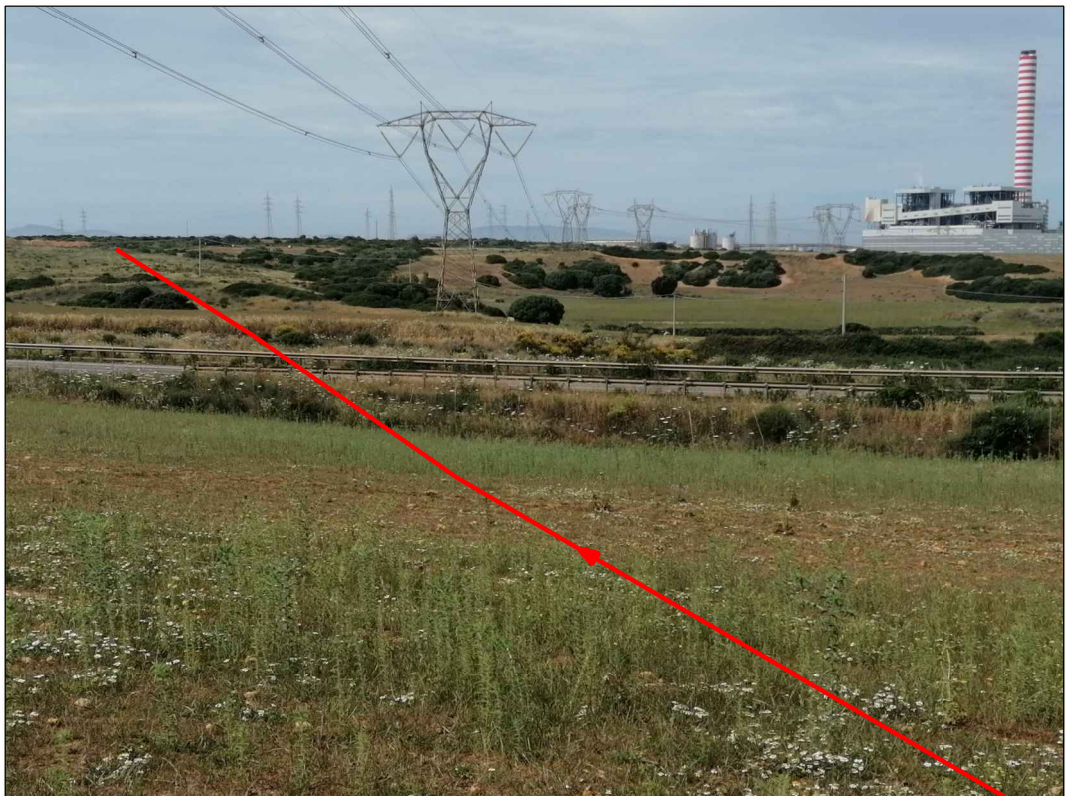
Descrizione: Attraversamento S.P. n.57 con spingitubo km 1+578
