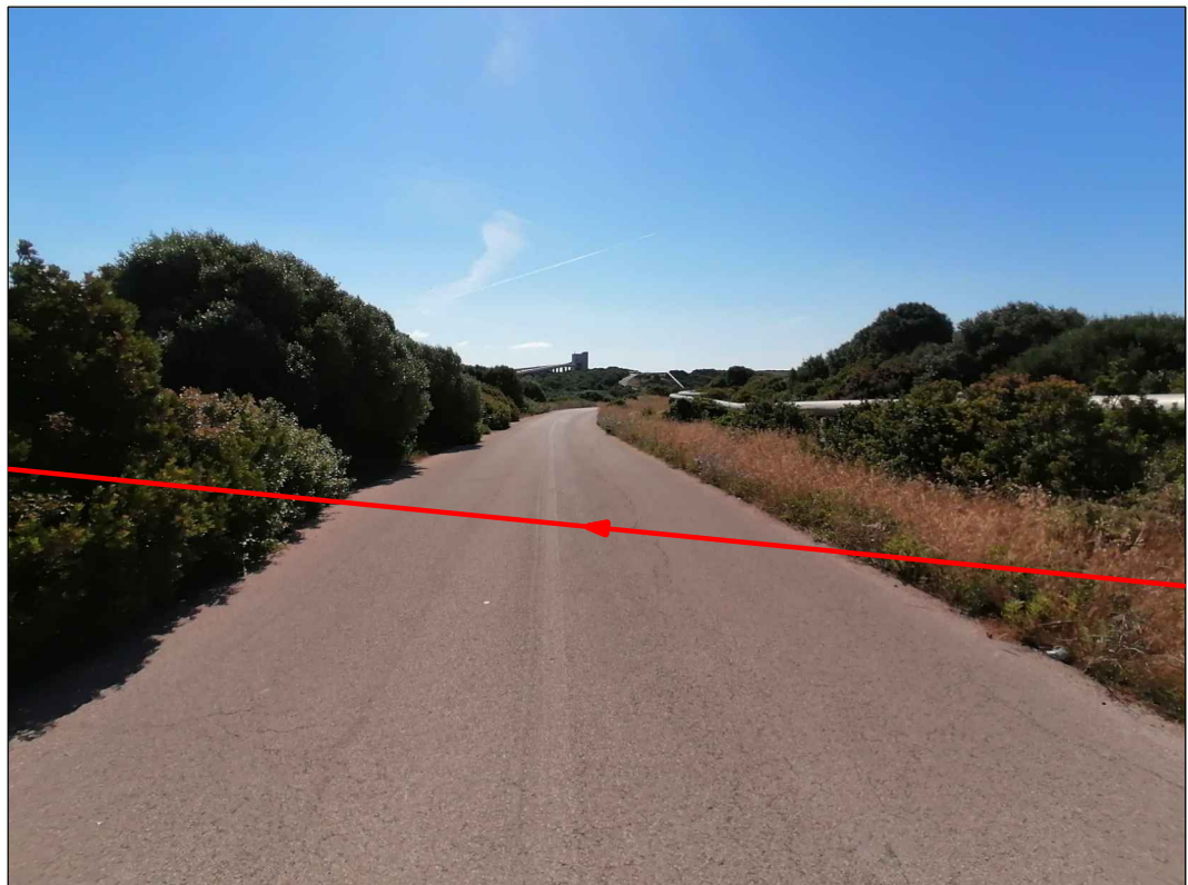
Descrizione: Attraversamento Strada km 2+695
