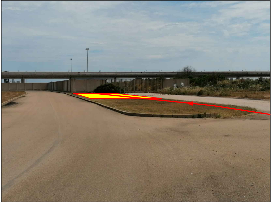
Descrizione: Punto di consegna impianto P.I.D.A. n.1 km 2+814
