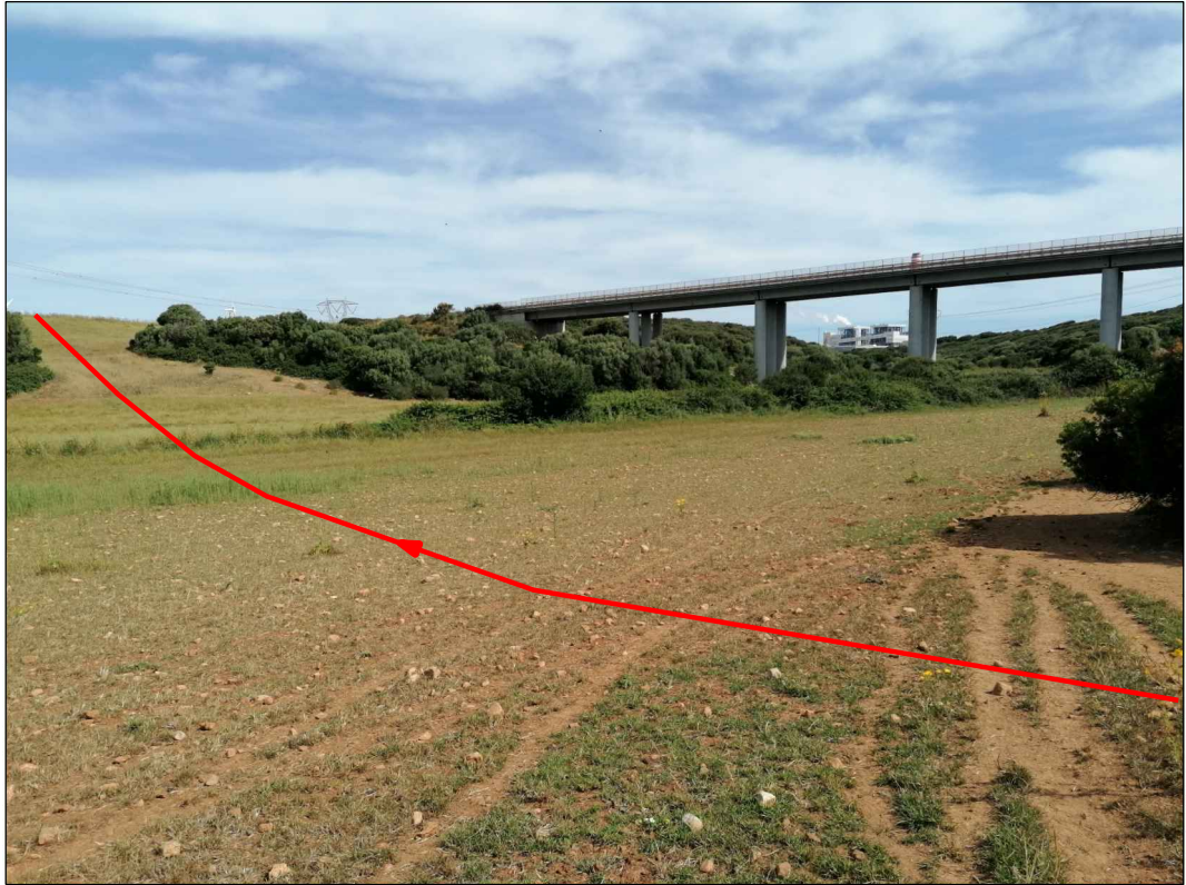
Descrizione: Attraversamento Fiume Santo con scavo a cielo aperto km 1+295
