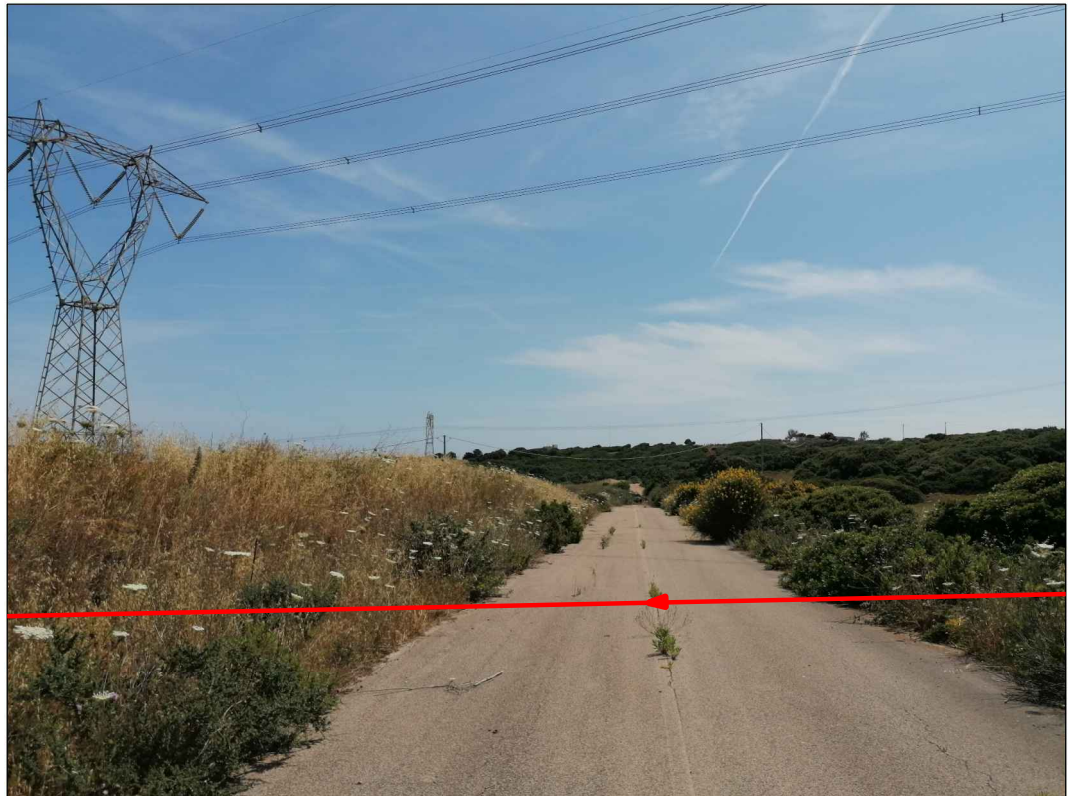
Descrizione: Attraversamento Strada km 1+677
