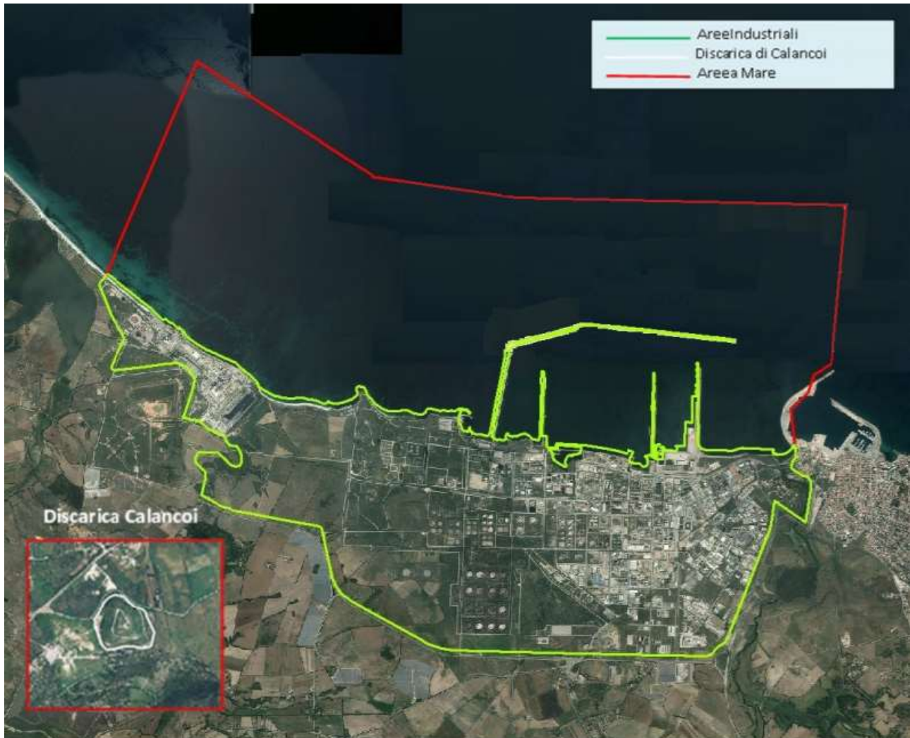
Figura 2.1.5–A. Foto aerea del SIN Porto Torres, tratta dal “Piano Regionale Bonifica delle Aree Inquinare (PRB) – febbraio 2019” della Regione Sardegna.
