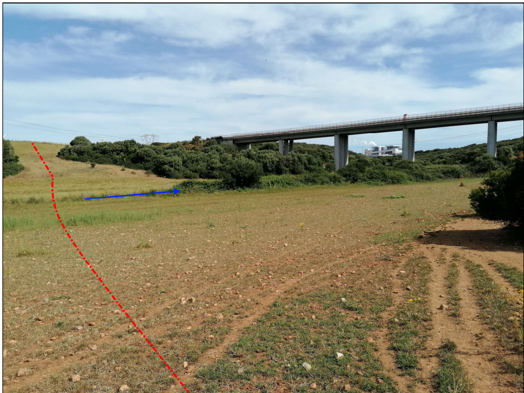
Fig.3.2/B: Foto ambito d'attraversamento
