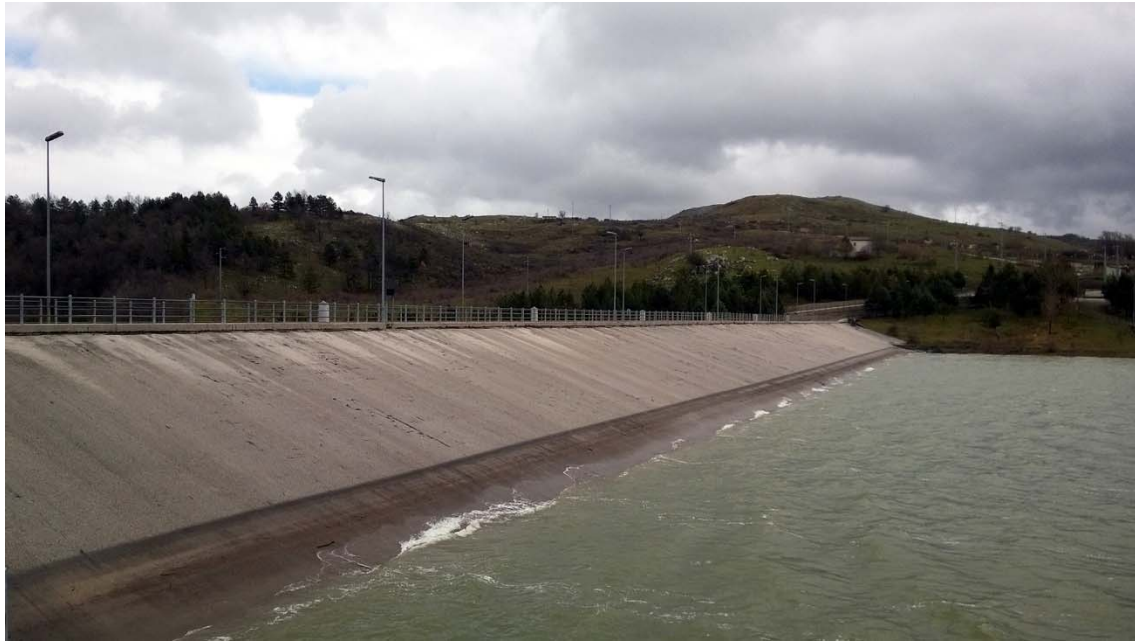
Figura 1 - Vista da monte della diga di Saetta
