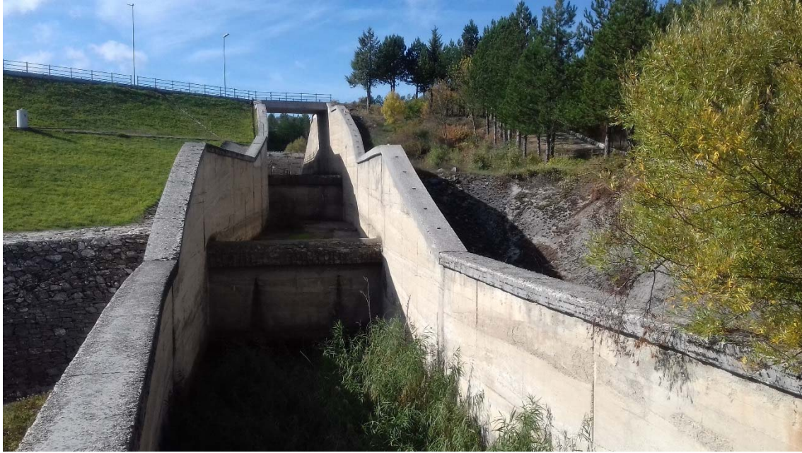
Figura 4 - Vista da valle del canale fuggatore dello scarico di superficie
