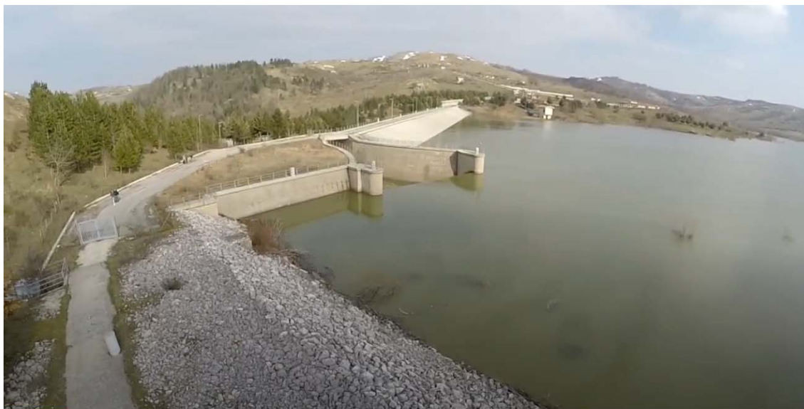
Figura 3 - Vista aerea dello scarico di superficie
