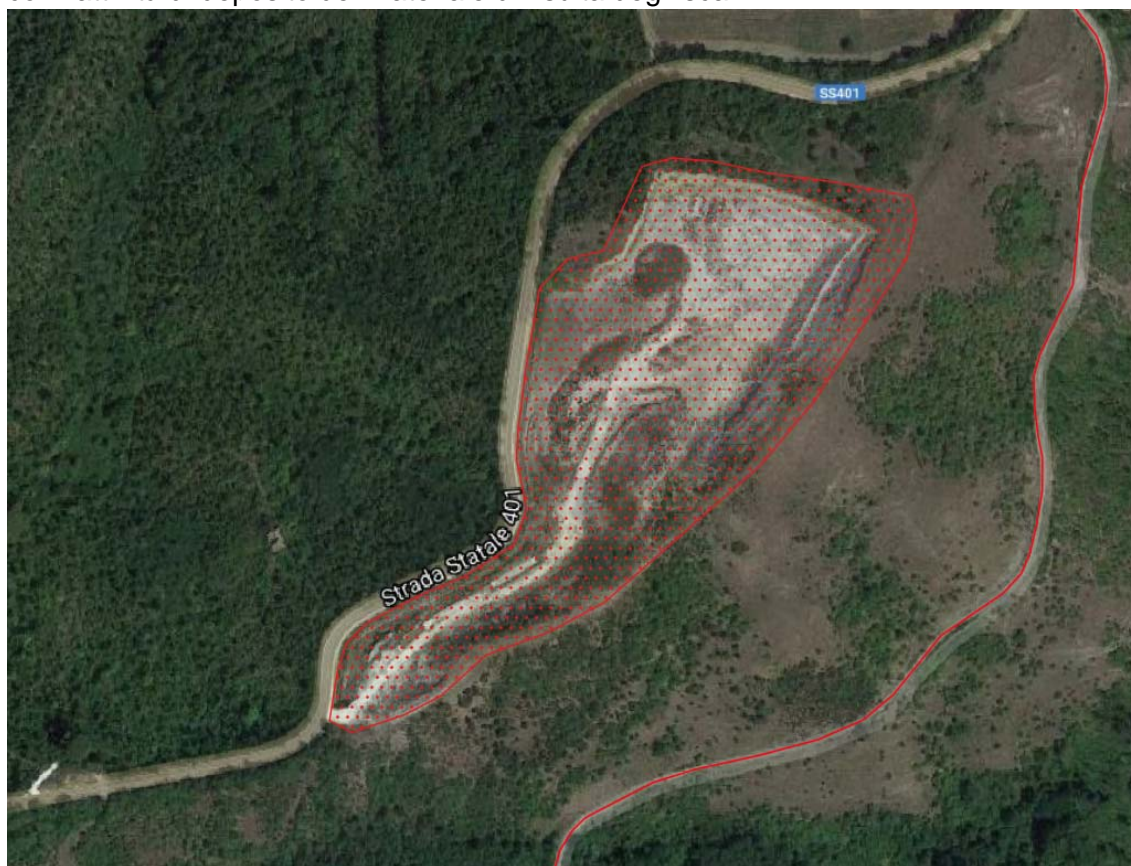
Figura 10 – Cantiere cava “Costa della Guana”
