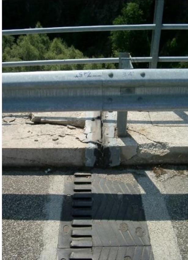
*Figura 9-14 Viadotto Ficocchia. Chiusura del giunto e rottura a compressione di un bordo in cls dell'impalcato*
