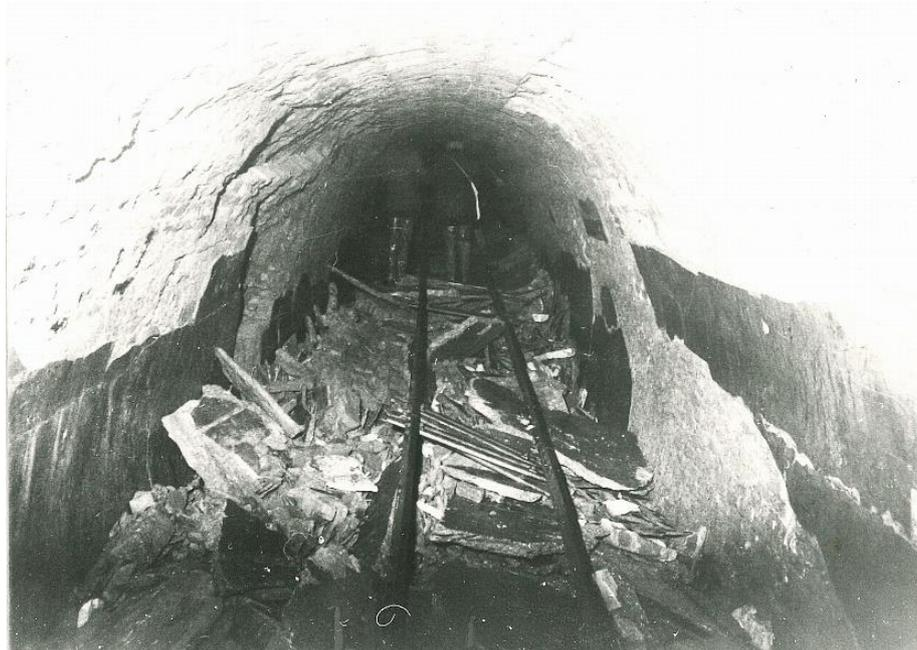
Figura 5-9 Esempio di dissesto della Galleria Pavoncelli dell'EAAP a seguito del terremoto del 1980.
