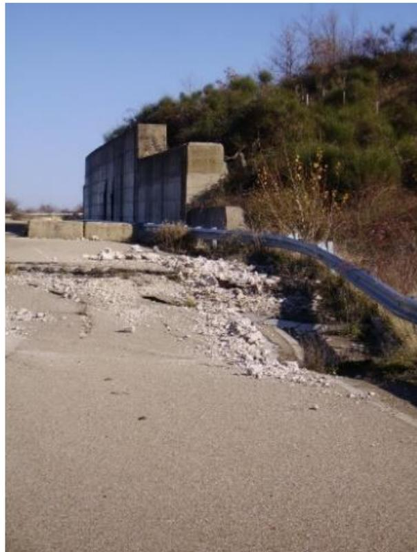
*Figura 9-13 Svincolo Pescopagano, punto B (rottura e ribassamento sede stradale, 2004)*
