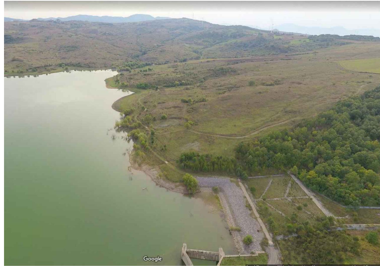
STATO DI FATTO VISTA PANORAMICA
