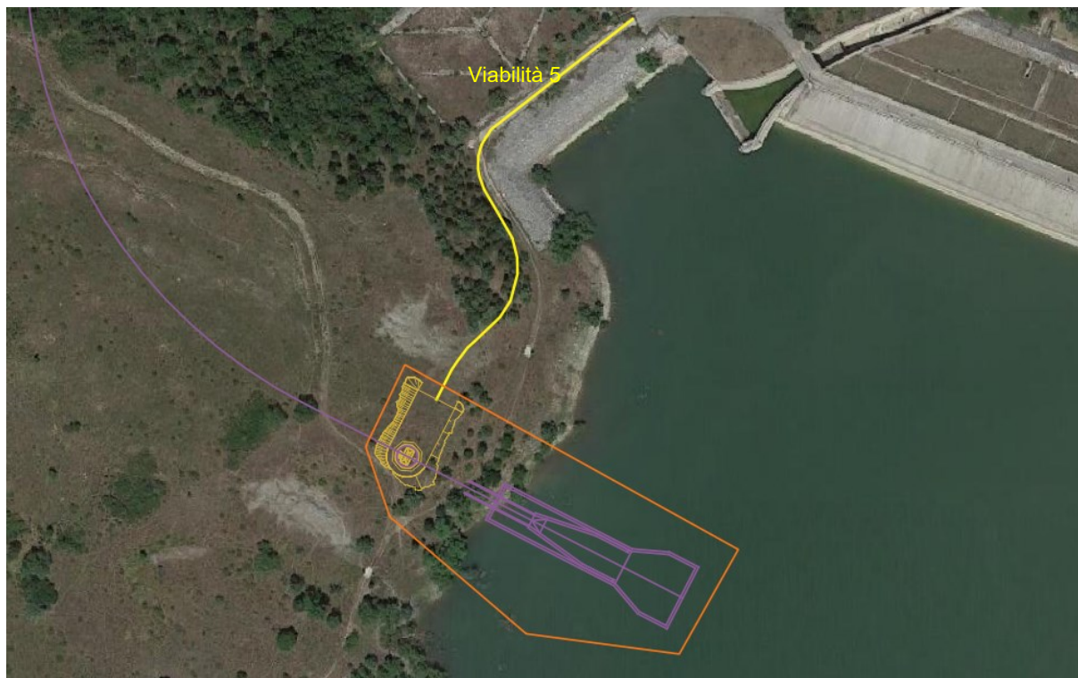
Figura 4.1: Cantiere Bacino Saetta
