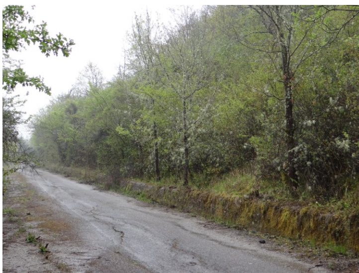
Figura 5.17: Area Cantiere Accesso Centrale in Caverna
