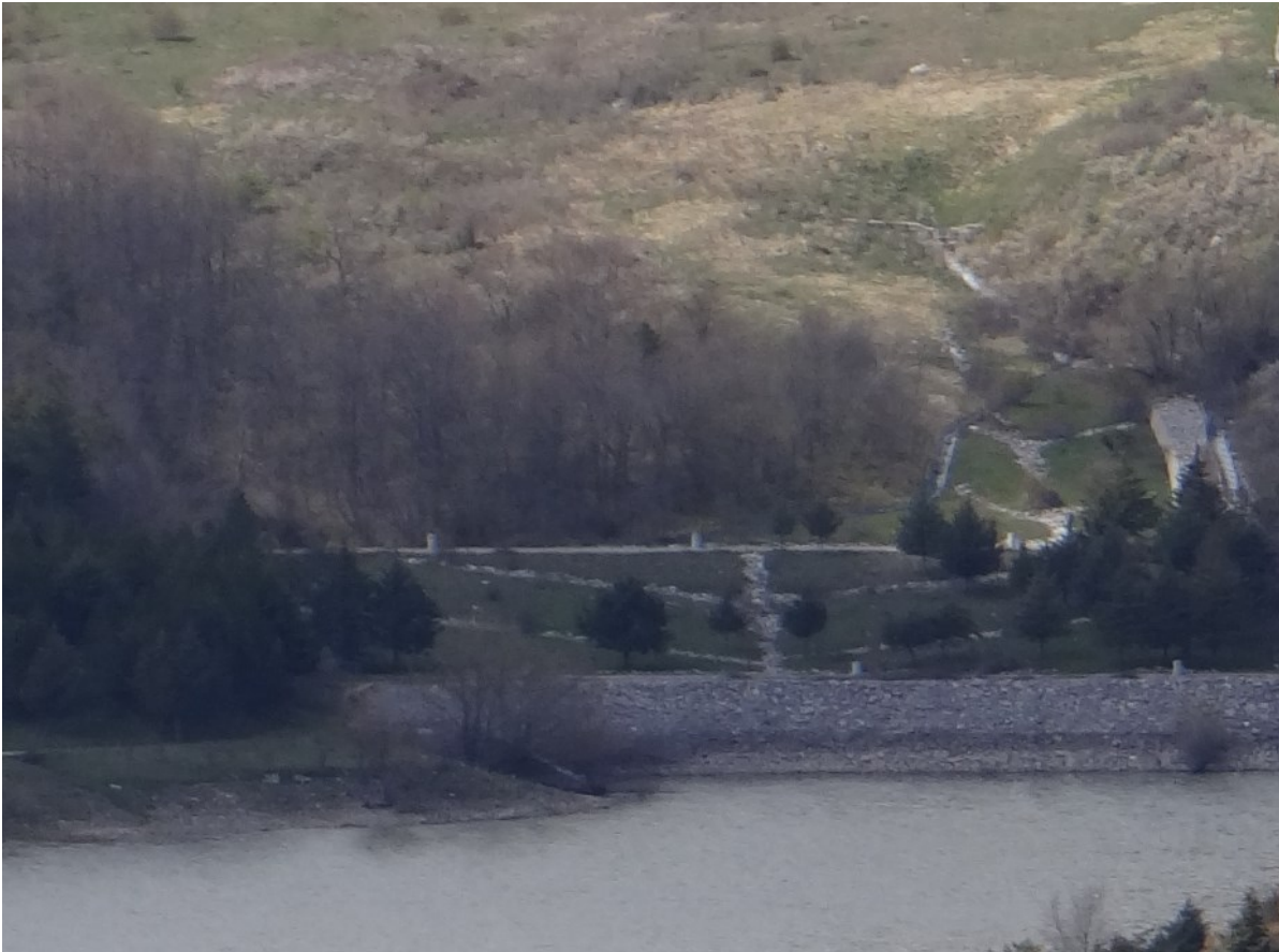
Figura 5.8: Sponda Sinistra dello Sbarramento con evidenza degli Interventi per il Consolidamento
