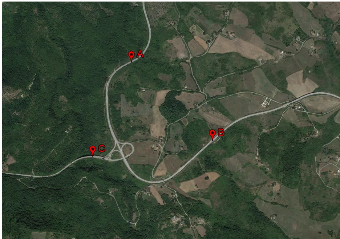
Figura 5.7: Svincolo Stradale di Pescopagano con indicazione dei punti di Rottura rilevati sulla Sede Stradale
