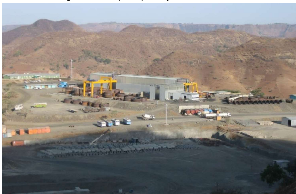
Figura 2 – Esempio impianto fabbricazione virole
