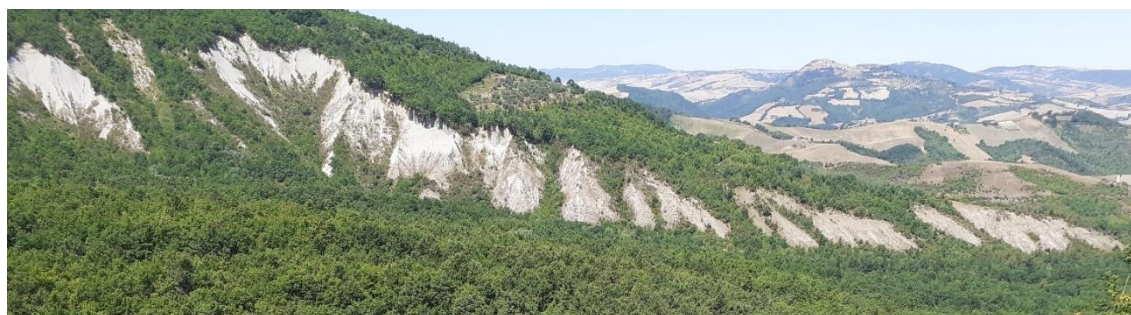
Figura 14 - Scarpate nelle argille plioceniche fortemente addensate, dove si sono originate le tipiche morfologie calanchive in cui la superficie esposta ad alta pendenza è soggetta a fenomeni erosivi di superficie (esfoliazioni, slaking, etc.). a scala centimetrica e tuttavia responsabili di modesti accumuli vegetati nelle tasche delle scarpate
