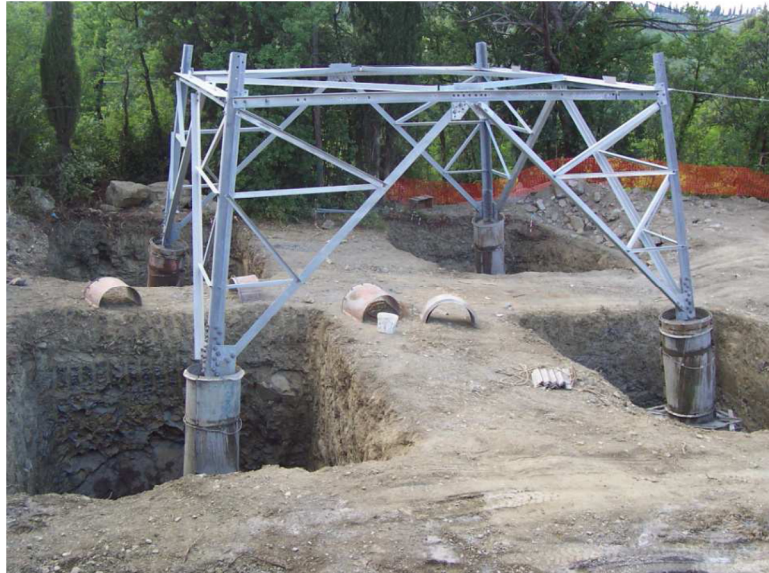
Figura 31: realizzazione di fondazioni superficiali tipo CR per un sostegno a traliccio. Nell'immagine si possono osservare le quattro buche, la base del sostegno collegata alla fondazione tramite i "monconi" ed i casseri utilizzati per i quattro "colonnini" (immagine d'archivio)
