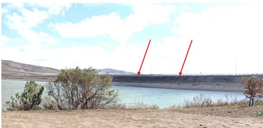
**Figura 13** Paramento di monte della diga. Le frecce indicano la presenza di vegetazione tra le piastrelle del paramento di monte.
