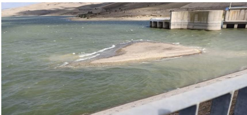
**Figura 14.** Sedimenti accumulati in corrispondenza del paramento di monte.
