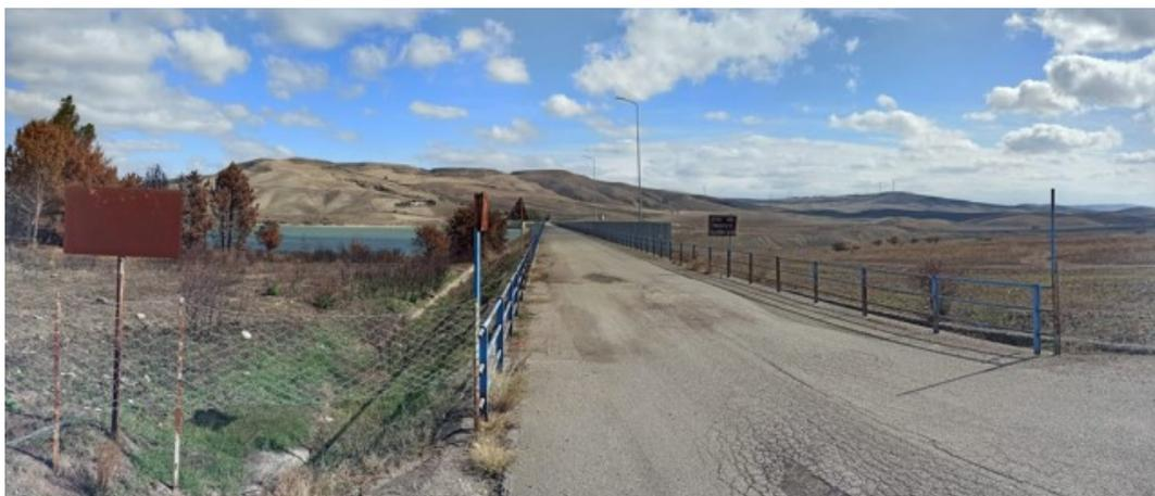
**Figura 15.** Stato di abbandono di recinzioni, cartellonistica, vegetazione e strada visibilmente ammalorata.
