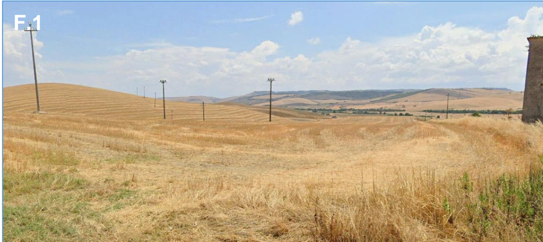
Figura 20. Il tracciato dell'elettrodotto visto dalla SP26 verso sud.
