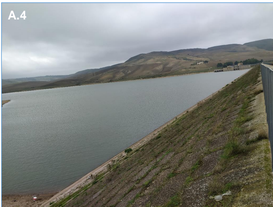
Figura 6. Il paramento di monte della diga del Basentello a servizio dell'invaso irriguo di Serra del Corvo.
