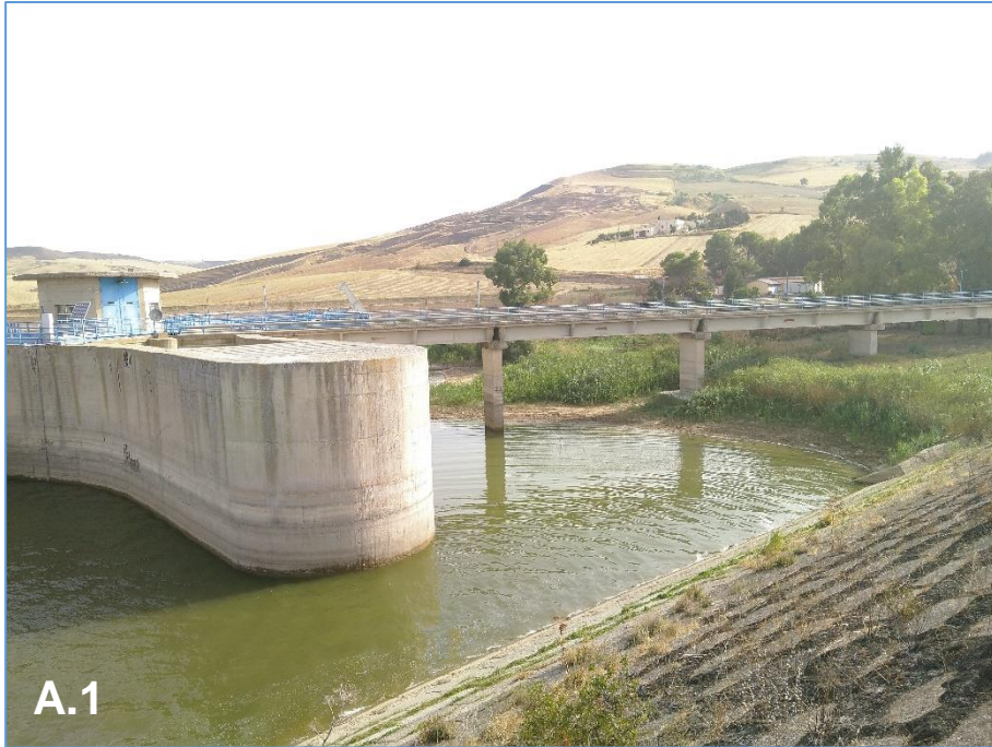
Figura 3. Le strutture di EIPLI in agosto 2021.
