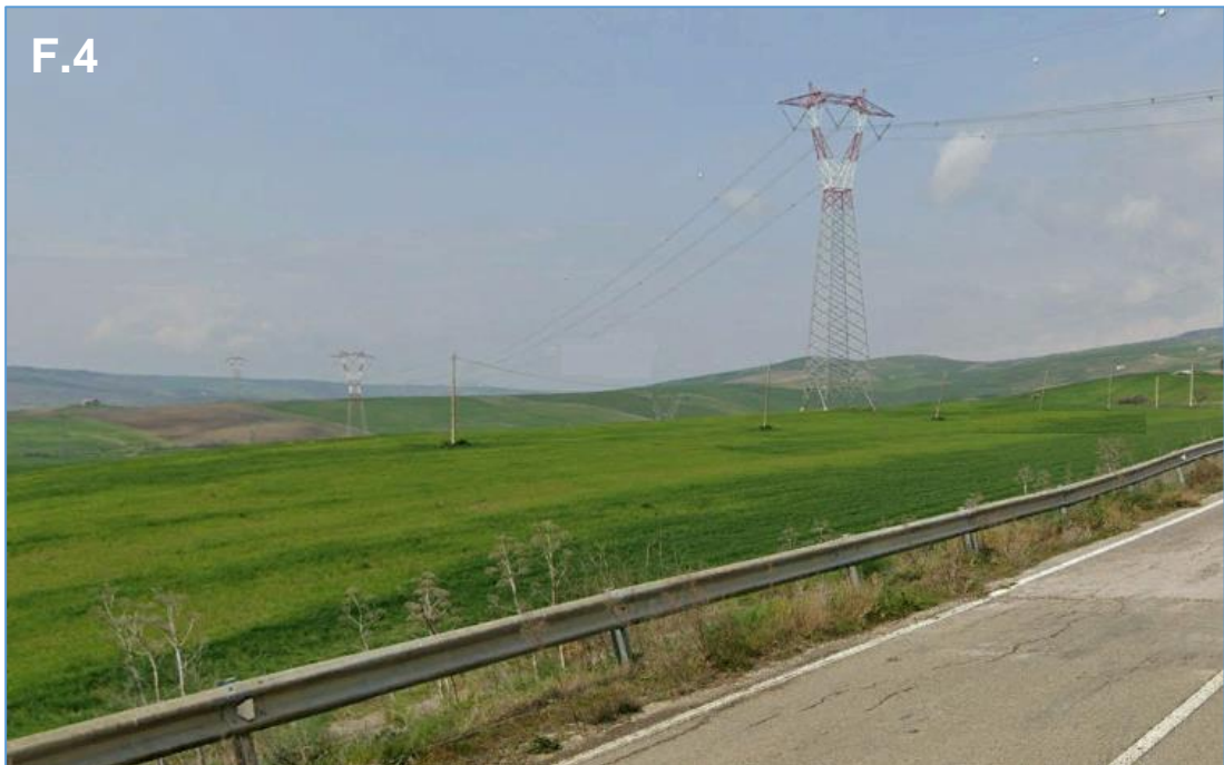
Figura 23. Il tracciato dell'elettrodotto aereo lungo la SS96 vista direzione nord.
