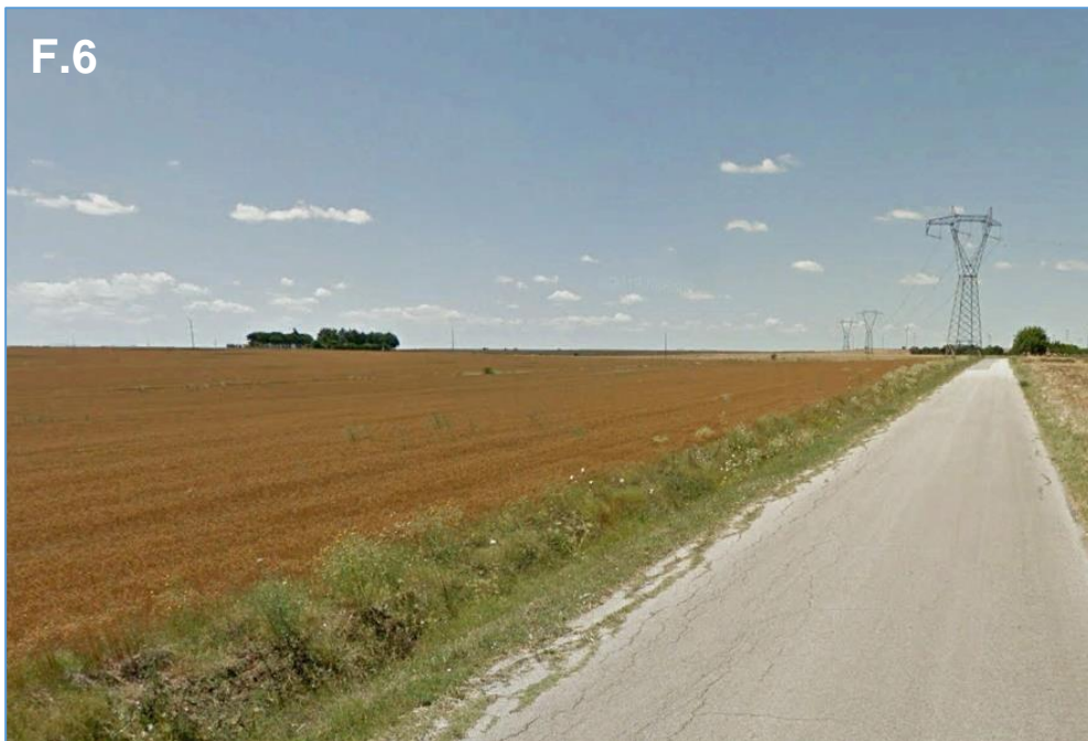
Figura 25. Vista dalla SP193 dell'area in cui terminerà l'elettrodotto aereo e dove sorgerà la stazione di trasformazione di TERNA.
