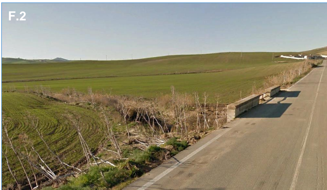
Figura 21. Il tracciato dell'elettrodotto aereo visto dalla SP203 verso nord.
