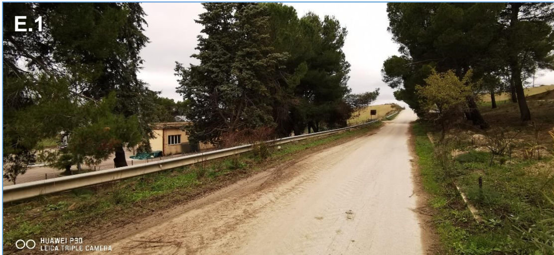
Figura 18. Il tratto della strada poderale per Contrada Basentello lungo la quale verrà realizzato il primo tratto interrato del cavidotto di consegna dell'energia elettrica.
