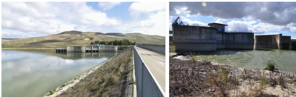
Figura 8. Alcune immagini delle strutture esistenti per i prelievi irrigui gestite da EIPLI.
