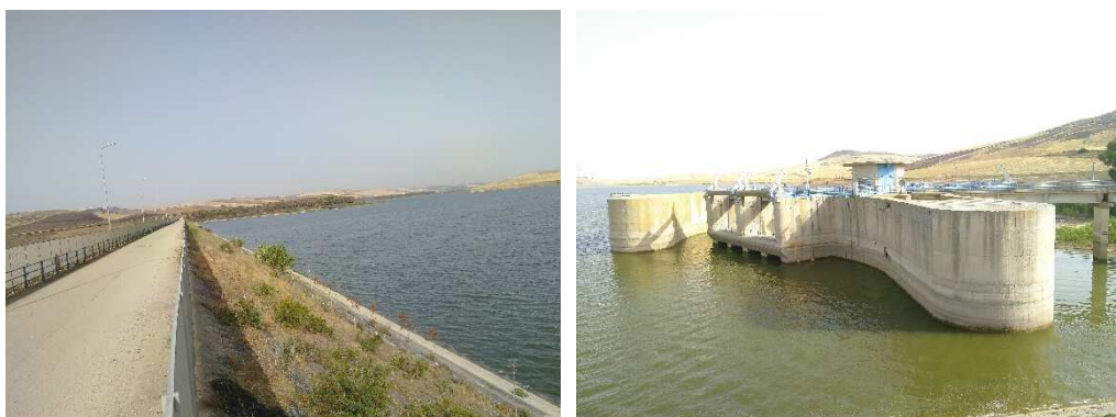
Figura 8. Il paramento di monte dello sbarramento della diga e organi di presa e sfioro presso l'invaso di Serra del Corvo.
