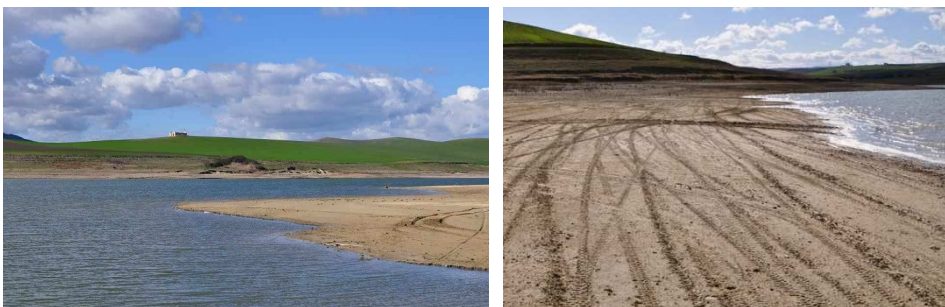
Figura 6. Gli estesi depositi di materiale solido all'interno del lago hanno causato una netta riduzione del volume utile di invaso.
