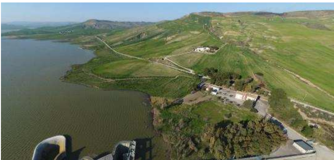
Figura 60. Vista aerea dei siti in cui verrà realizzata la centrale interrata e verranno posate le condotte forzate.
