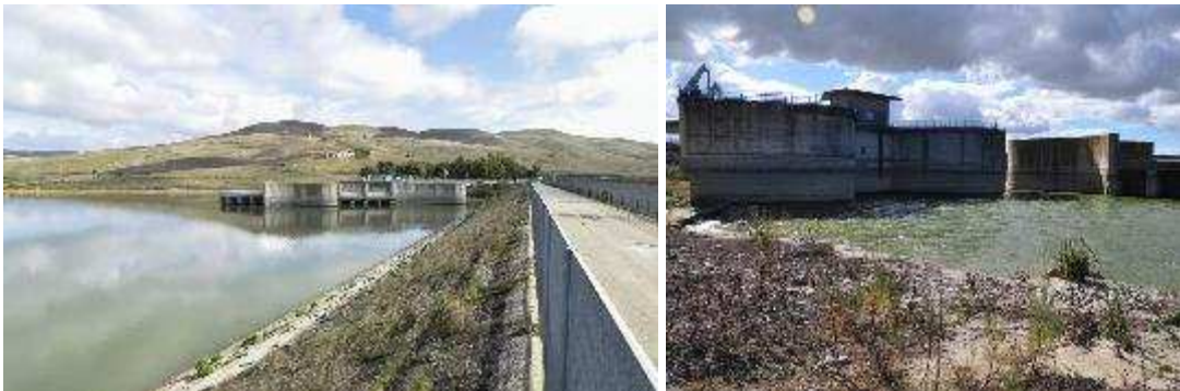
Figura 59. Alcune immagini delle strutture esistenti per i prelievi irrigui gestite da EIPLI.
