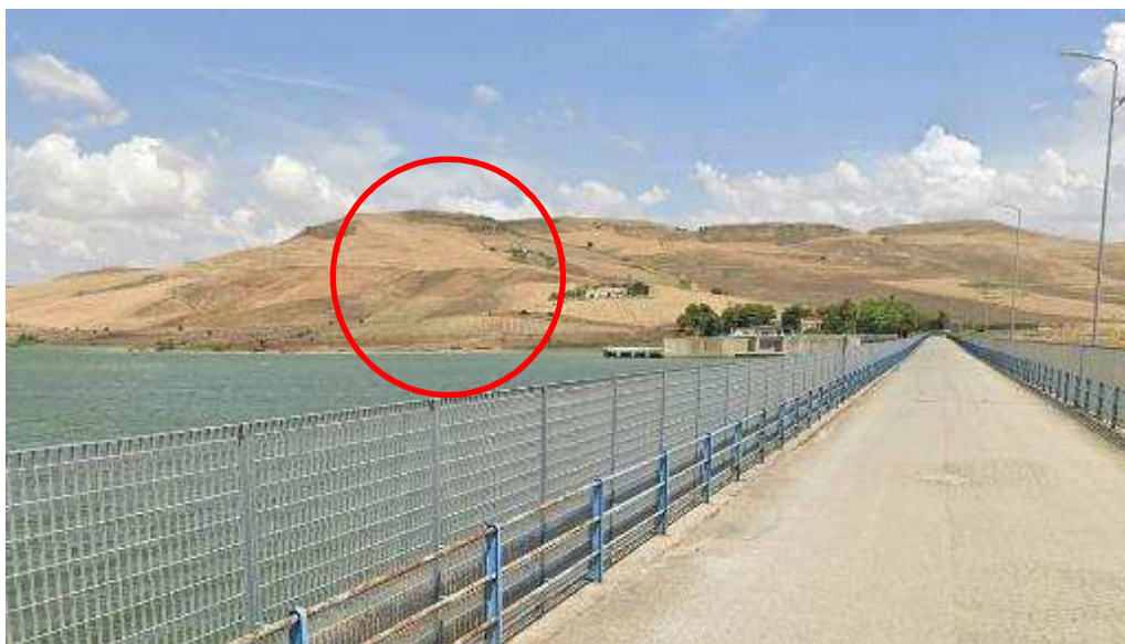
Figura 52 La diga di Serra del Corvo e la localizzazione dell'area in cui verranno posate le condotte forzate e verrà realizzata la centrale di produzione, completamente interrata.
