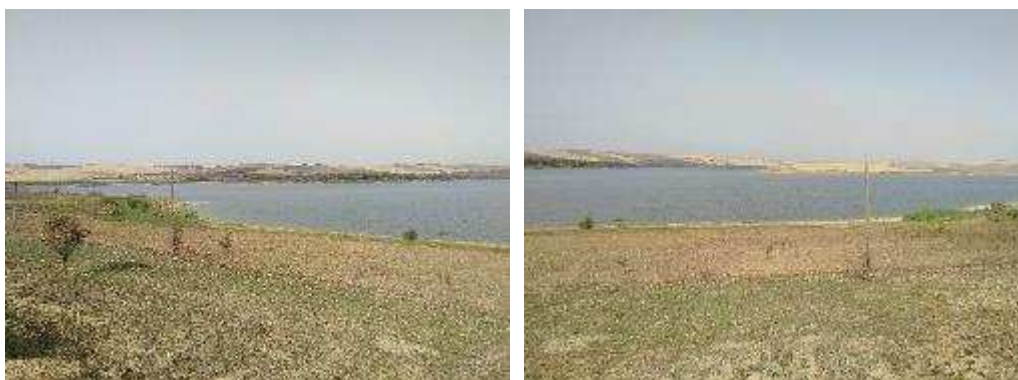
Figura 156. Alcune immagini delle sponde lacustri interessate dai lavori di costruzione della centrale di produzione e delle opere di prelievo e scarico delle acque.
