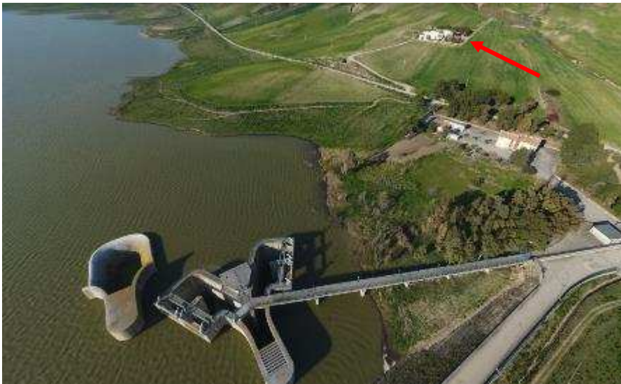
Figura 165. La masseria tutelata (recettore D-1) sarà esposta ad impatti sia in fase di cantiere che in fase di esercizio.
