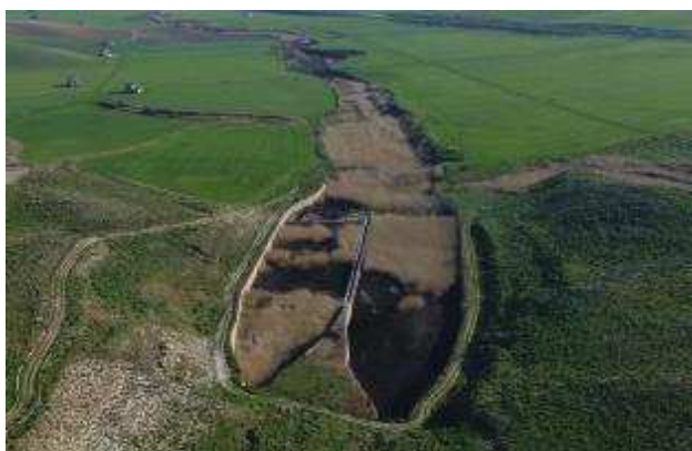
Figura 91. Gli ambienti umidi che si sono creati a valle degli organi di scarico della diga di Serra del Corvo, dai quali viene rilasciato anche il DMV di legge.
