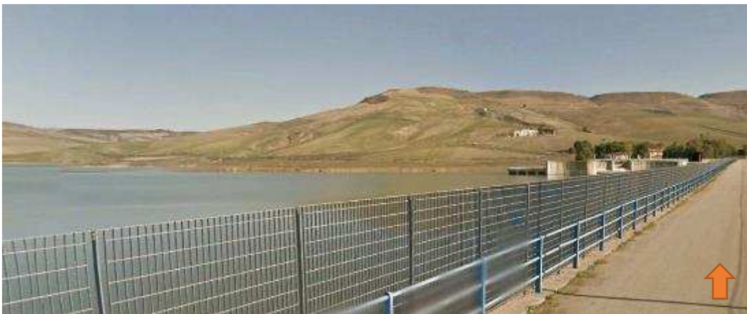
Figura 138. Vista in direzione del sito di intervento del recettore mobile N.
