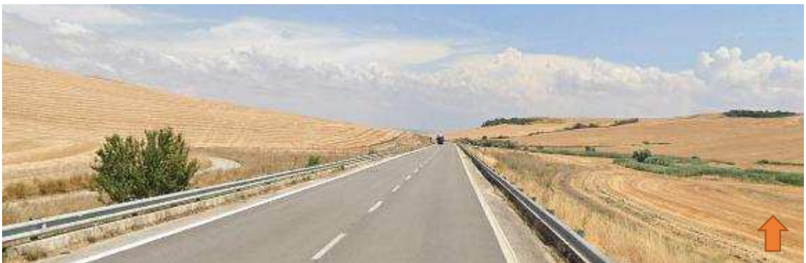
Figura 147. Vista allo stato attuale in direzione Lago Serra del Corso del recettore mobile Q.
